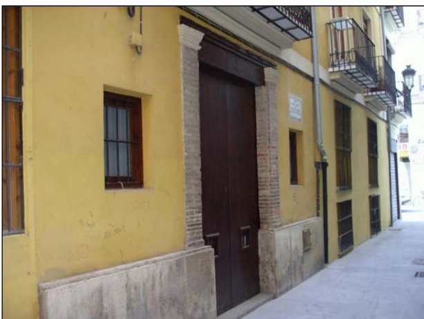
Fachada de la Capilla- Cárcel de San Vicente
