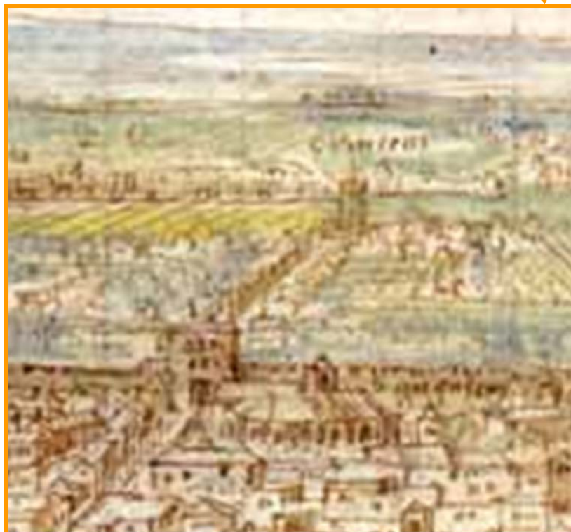
Vista de Valencia por Anthonie van den Wijngaerde en 1563, con detalle del conjunto (bajo), donde se observa el nombre de S. Vintius y bajo el conjunto con la torre campanario como único elemento destacado en la imagen.
