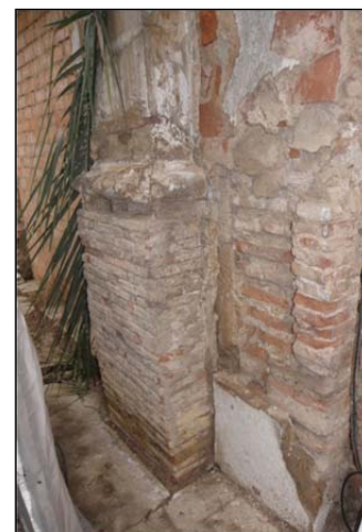
A la izquierda imagen de un pilar de la panda oeste, con arranque de sillares y a la derecha un pilar de la panda este, con arranque de fábrica de ladrillo
