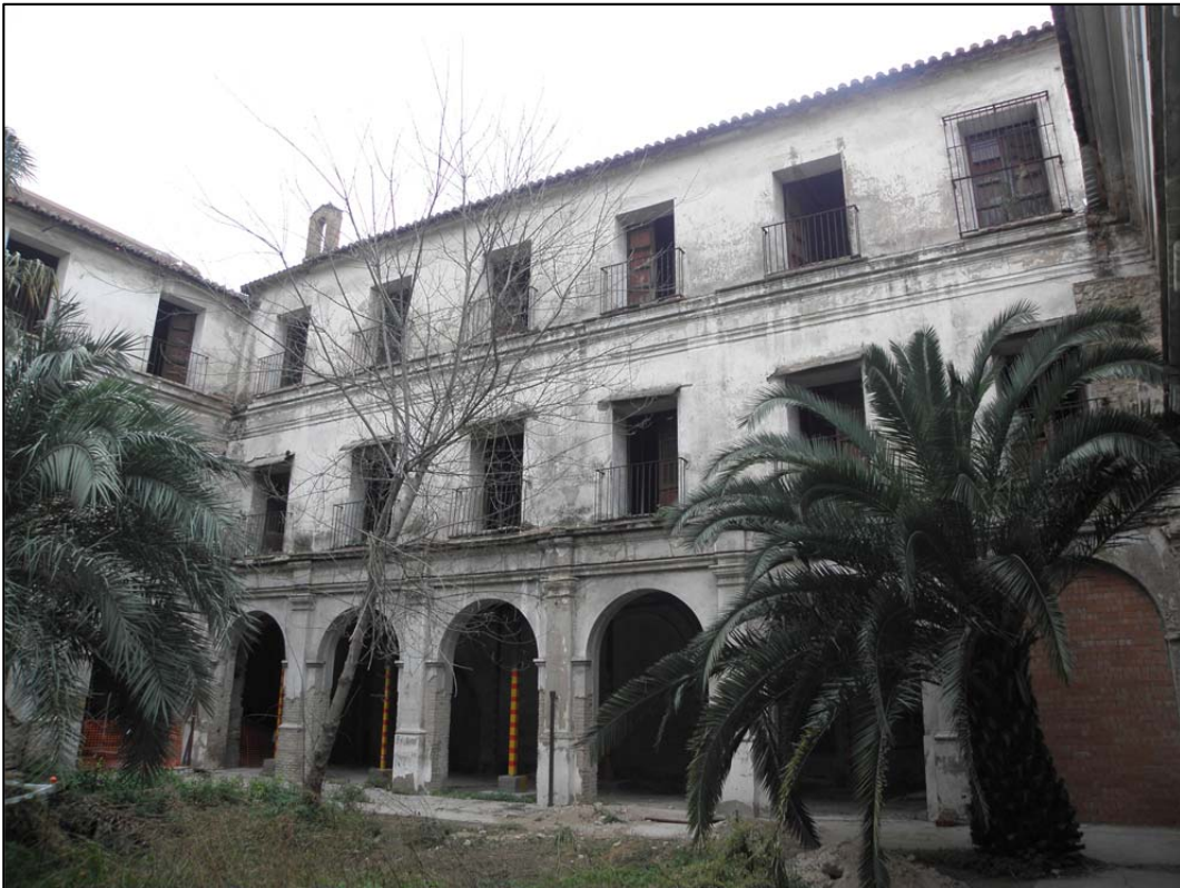
Vista de la panda Sur desde el interior del claustro
