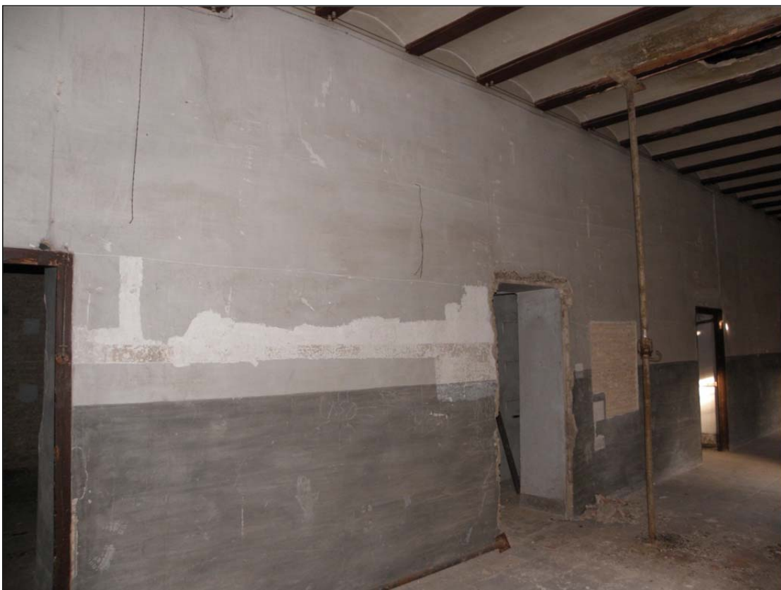
Vista general de pasillo de planta primera de la panda Norte.
