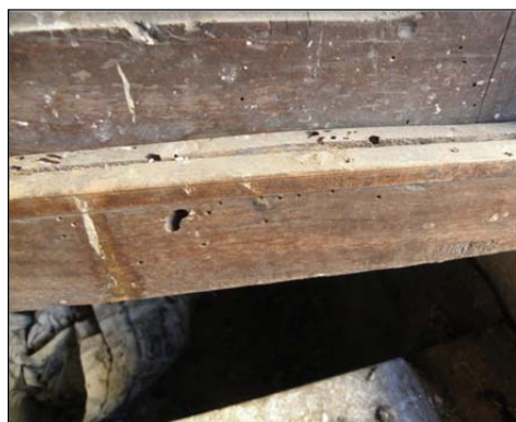
Ventana con ataque de xilófagos en cocina de primera planta.
