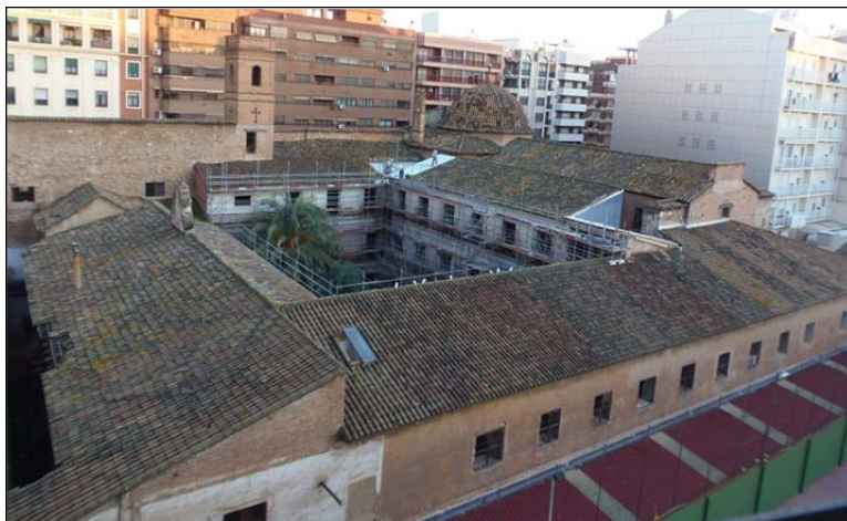
Vista general de la cubierta desde el colegio de Agustinos
