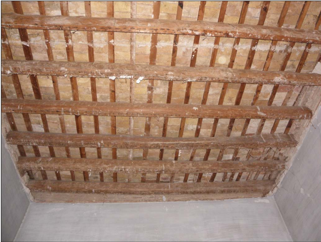
Vista del estado actual del forjado de planta primera de la panda Este.
