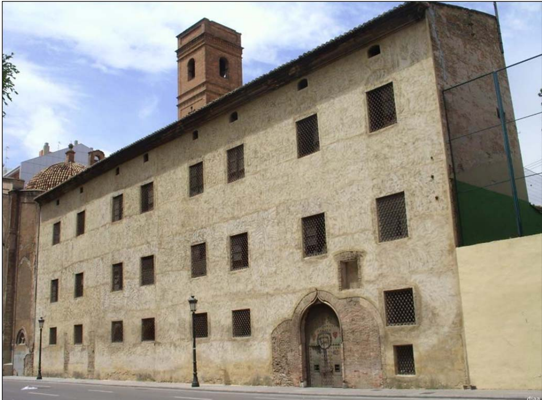
Vista de la fachada principal del Monasterio de San Vicente de la Roqueta
