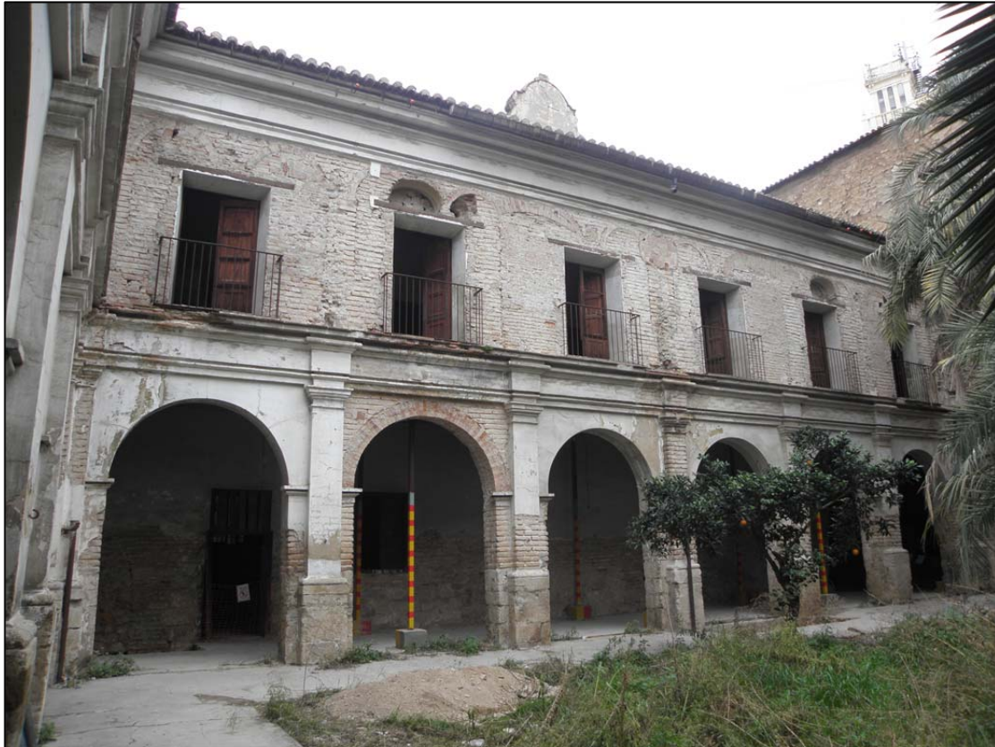
Vista de la panda Norte desde el interior del claustro
