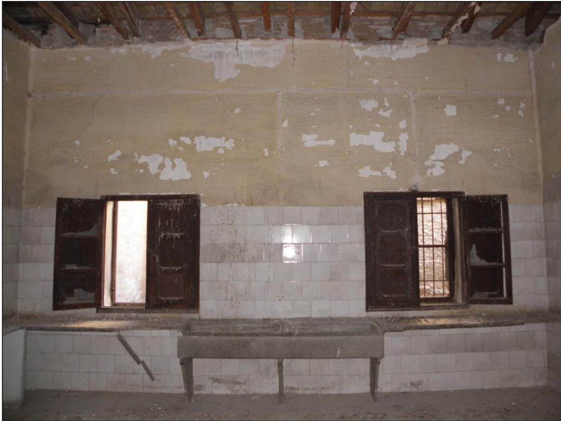
Vista del estado actual de cocina situada en planta primera
