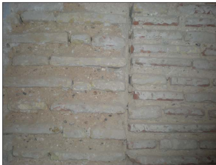
Imagen donde podemos observar las diferencias entre las fábricas de ladrillo del siglo XVII-XVIII (derecha) y siglo XIX (izquierda)
