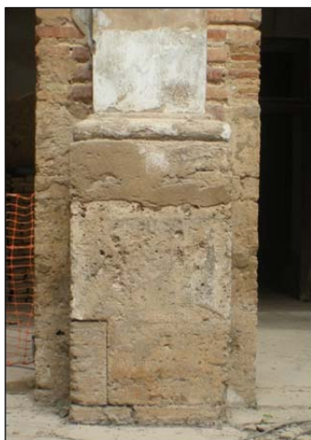
A la izquierda imagen de un pilar de la panda oeste, con arranque de sillares y a la derecha un pilar de la panda este, con arranque de fábrica de ladrillo
