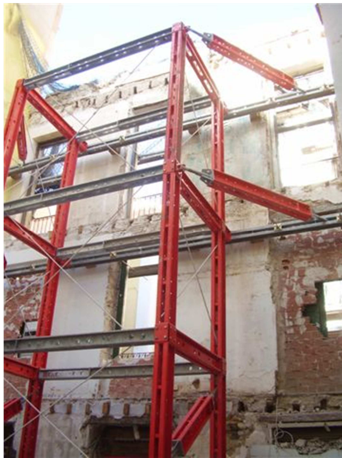
Montaje interior del sistema estabilizador.
