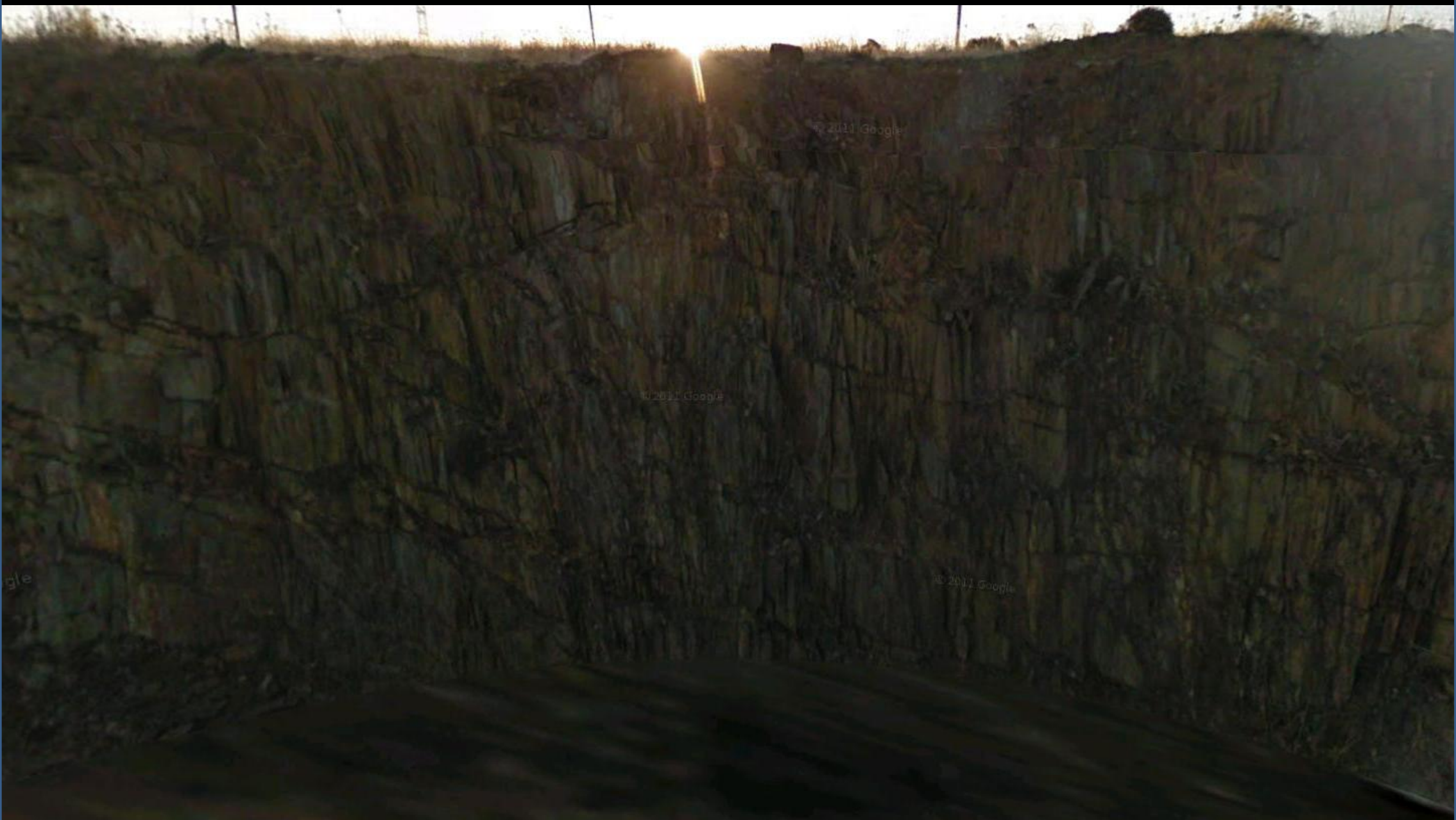
Pequeño talud de pizarras y grauvacas tectonizadas del Precámbrico. Los Degollados. NW Hoja de Cabeza de Buey.
