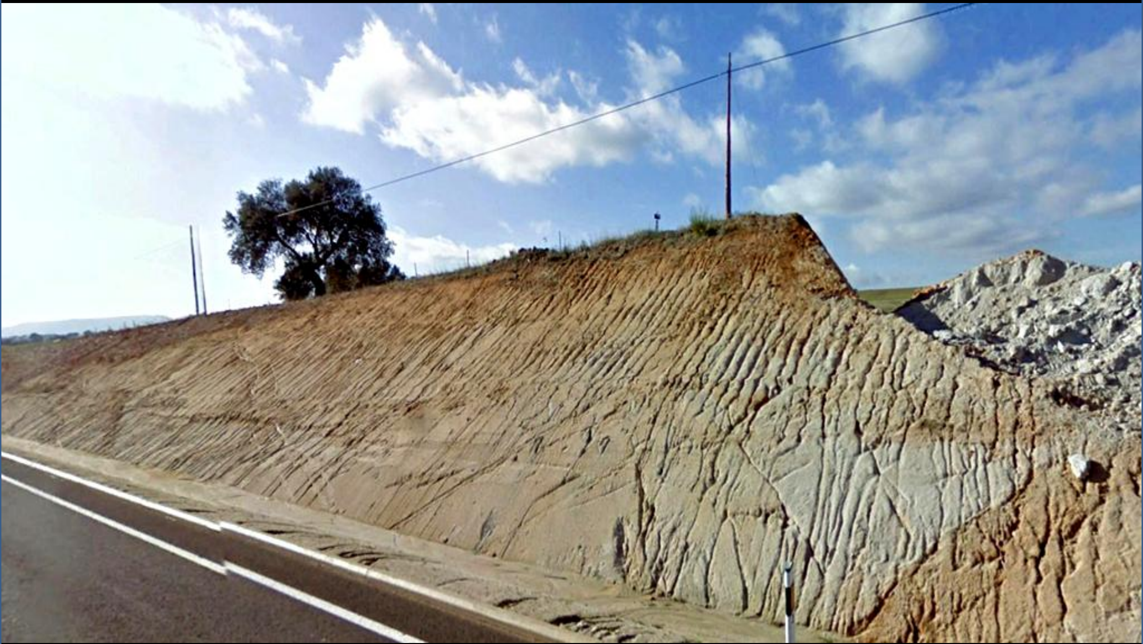
Talud en granodioritas alteradas. N de Casa Grande. N centro Hoja de Monterrubio de La Serena, Badajoz.
