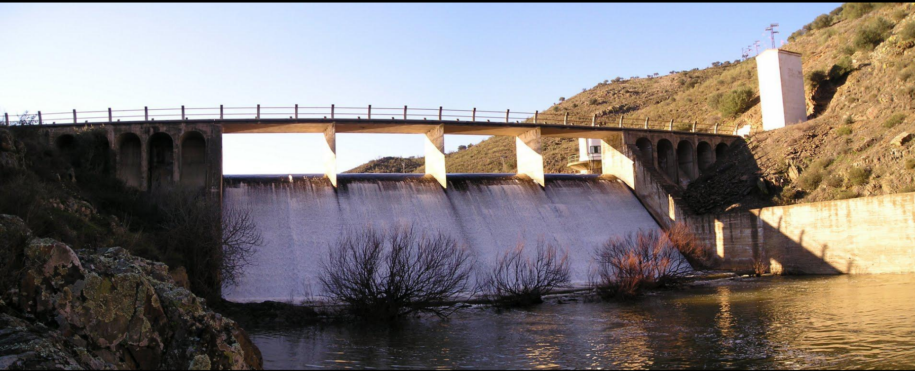
Presa de Azuaga. Badajoz. S de la población. Cerrada. En zona de filitas del Precámbrico-Cámbrico. SE Hoja. (por caesarem-google)
