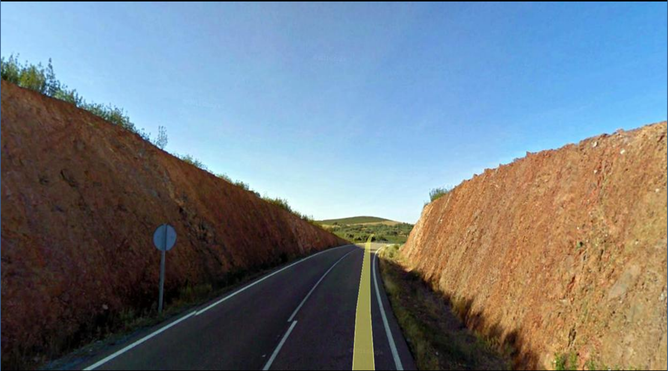
Taludes entre las pizarras del Devónico. Por Peñas del Gato, SE de Valencia de Mombuey, SW Hoja de Oliva de La Frontera. Badajoz
