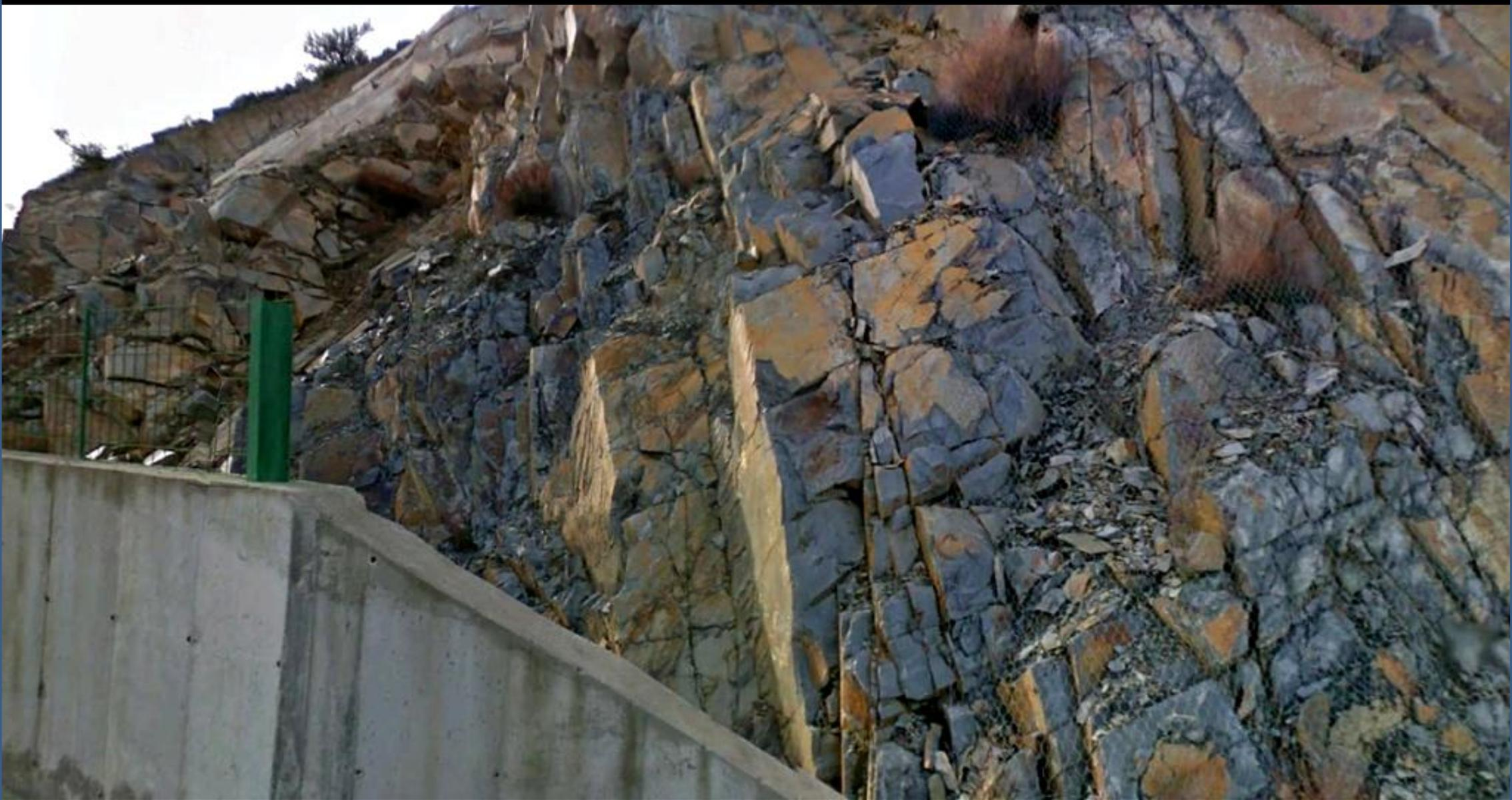
Mallazo y muro para la estabilización de los materiales del Complejo Esquisto Grauváquico, del Precámbrico Sup., al S del puente sobre el Río Salor. Valencia de Alcántara, Cáceres. SE Hoja de Membrío.
