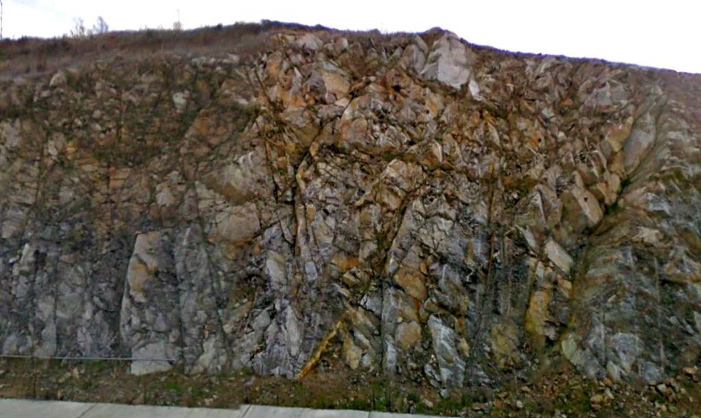
Granitos de dos micas tectonizados, y con mallazo. Autovía en el E de Oliva de Plasencia. NW Hoja de Plasencia. Cáceres.
