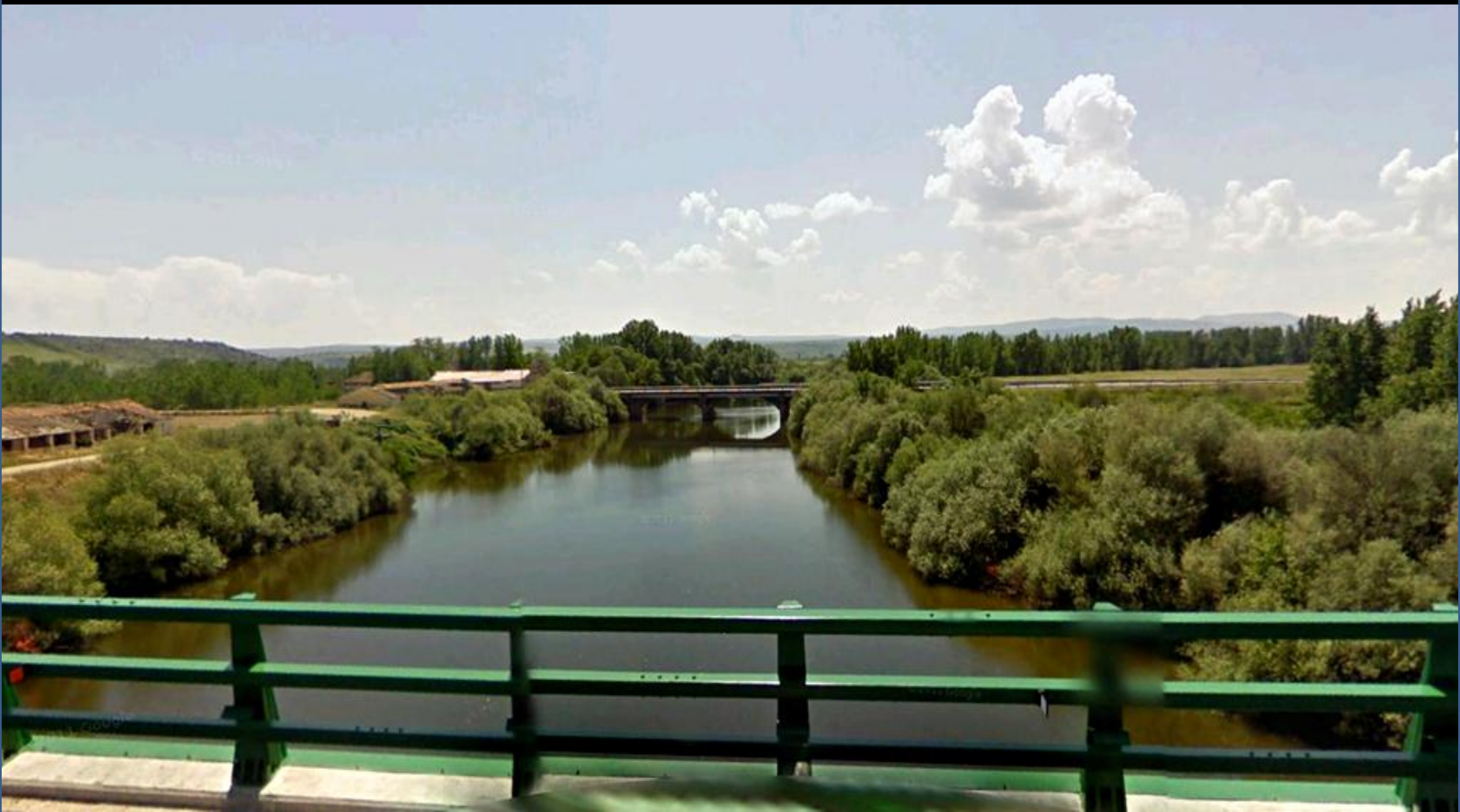
Puentes sobre el Río Alagón en la vega al NE de Alagón del Río, Cáceres. NE Hoja de Torrejuncillo.
