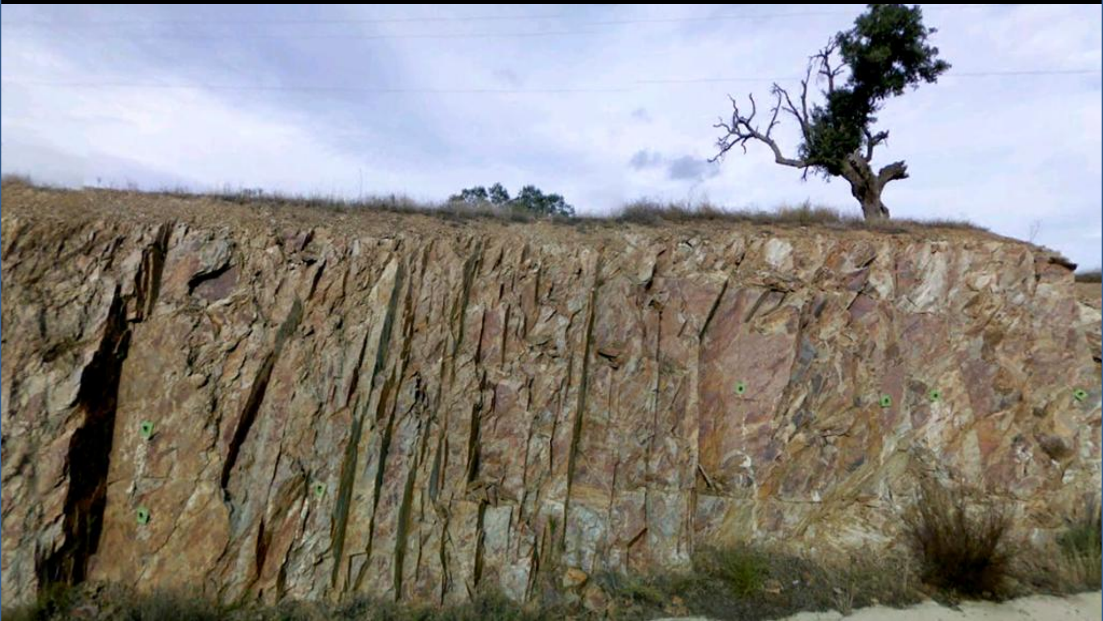
Grauvacas del Precámbrico Sup., bulonadas. Dehesa del Haza, SW de Valdeñigos, Cáceres. NE Hoja de Malpartida de Plasencia.
