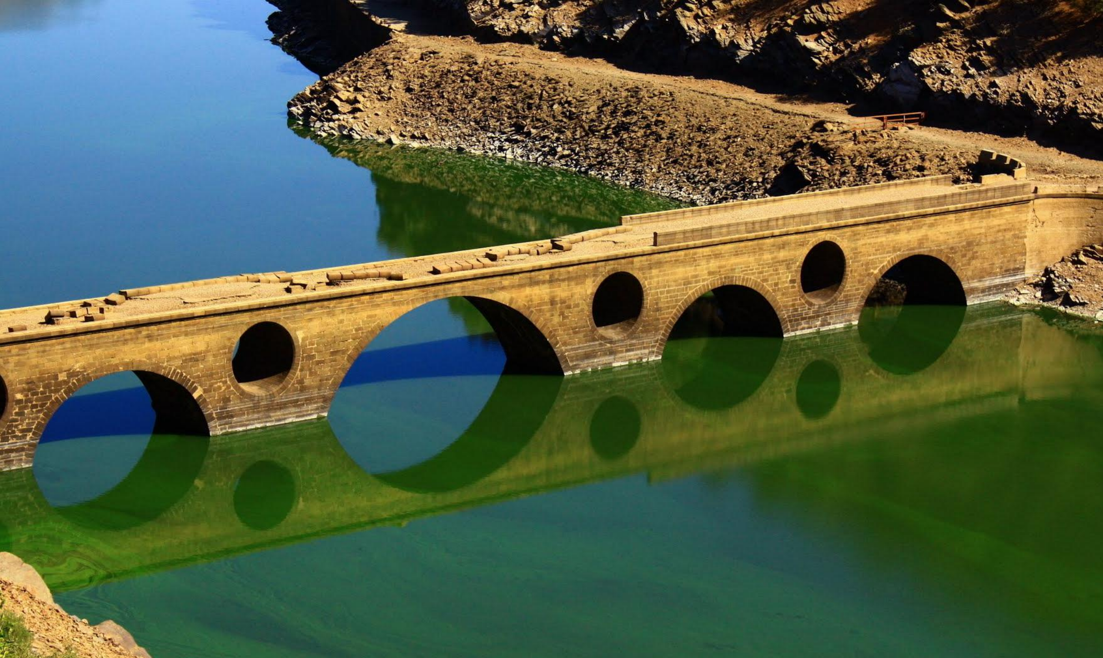
Puente del Cardenal, Río Tajo. Parque Nacional de Monfragüe. Entre SW Hoja de Malpartida de Plasencia. Y NW de la de Serradilla. Cáceres. (por x7y7-google)
