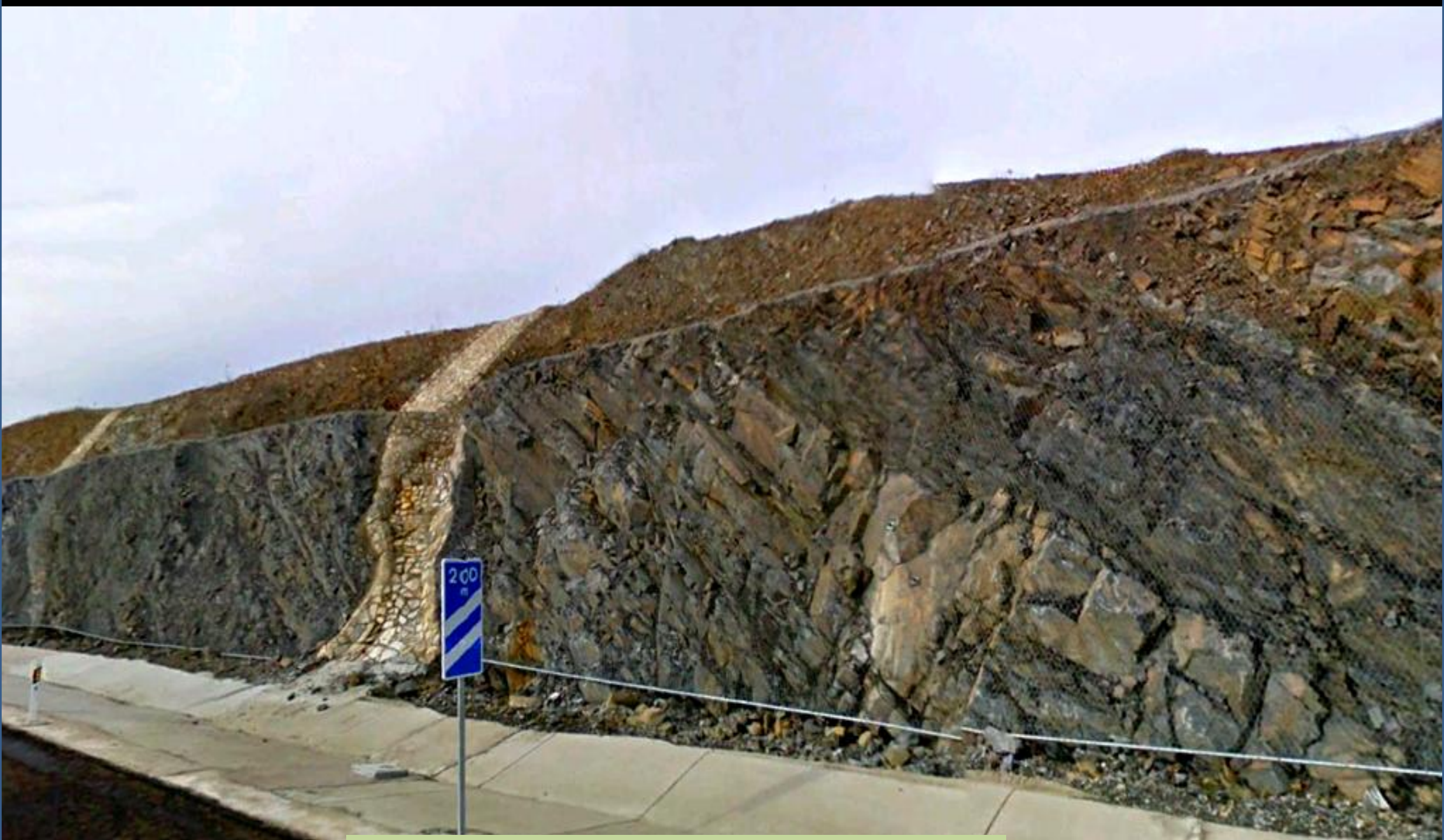
Junto anterior: Para encauzar aguas superficiales ¿?. Y mallazo. En las grauvacas del Precámbrico Sup. W de Malpartida de Plasencia, Cáceres. NW Hoja.
