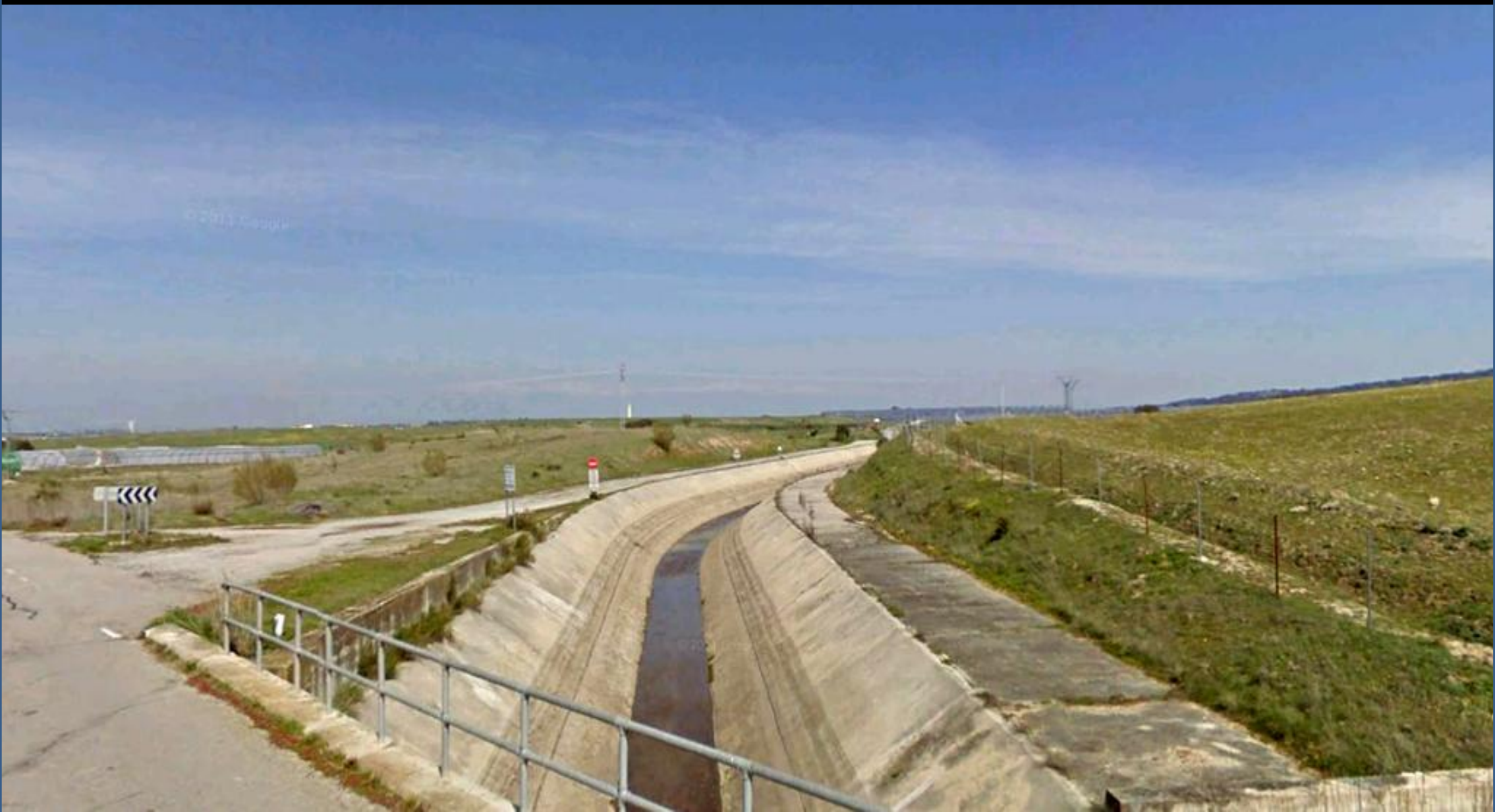
Canal de riego en terrenos del Paleoceno, Terciario. Carretera a Belvis de Montroy, Cáceres. NE Hoja de Jaraicejo.
