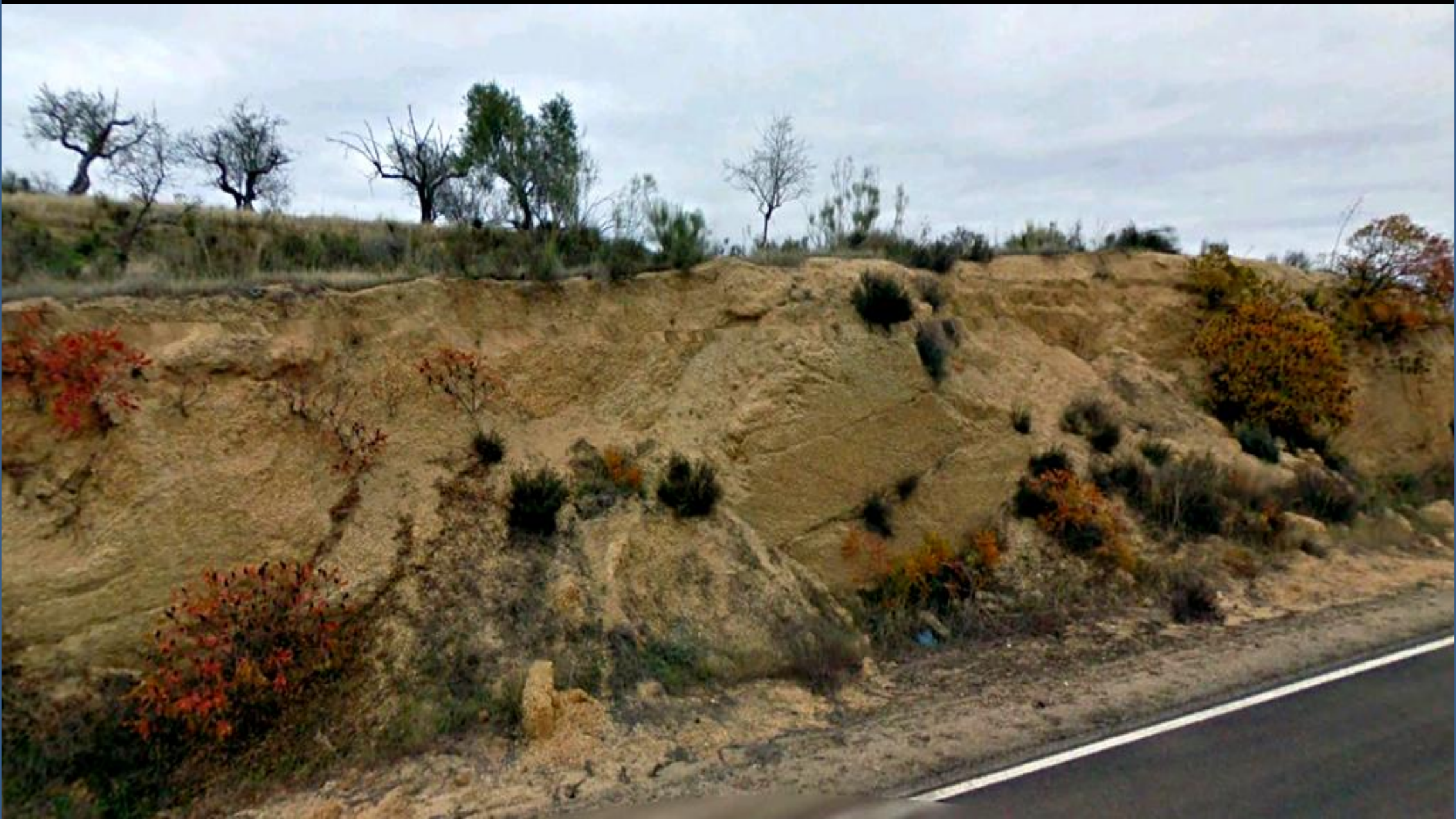
Granitos biotítico-moscovíticos, ortoneisificados, alterados. W de Garrovillas. Cáceres. SE Hoja.
