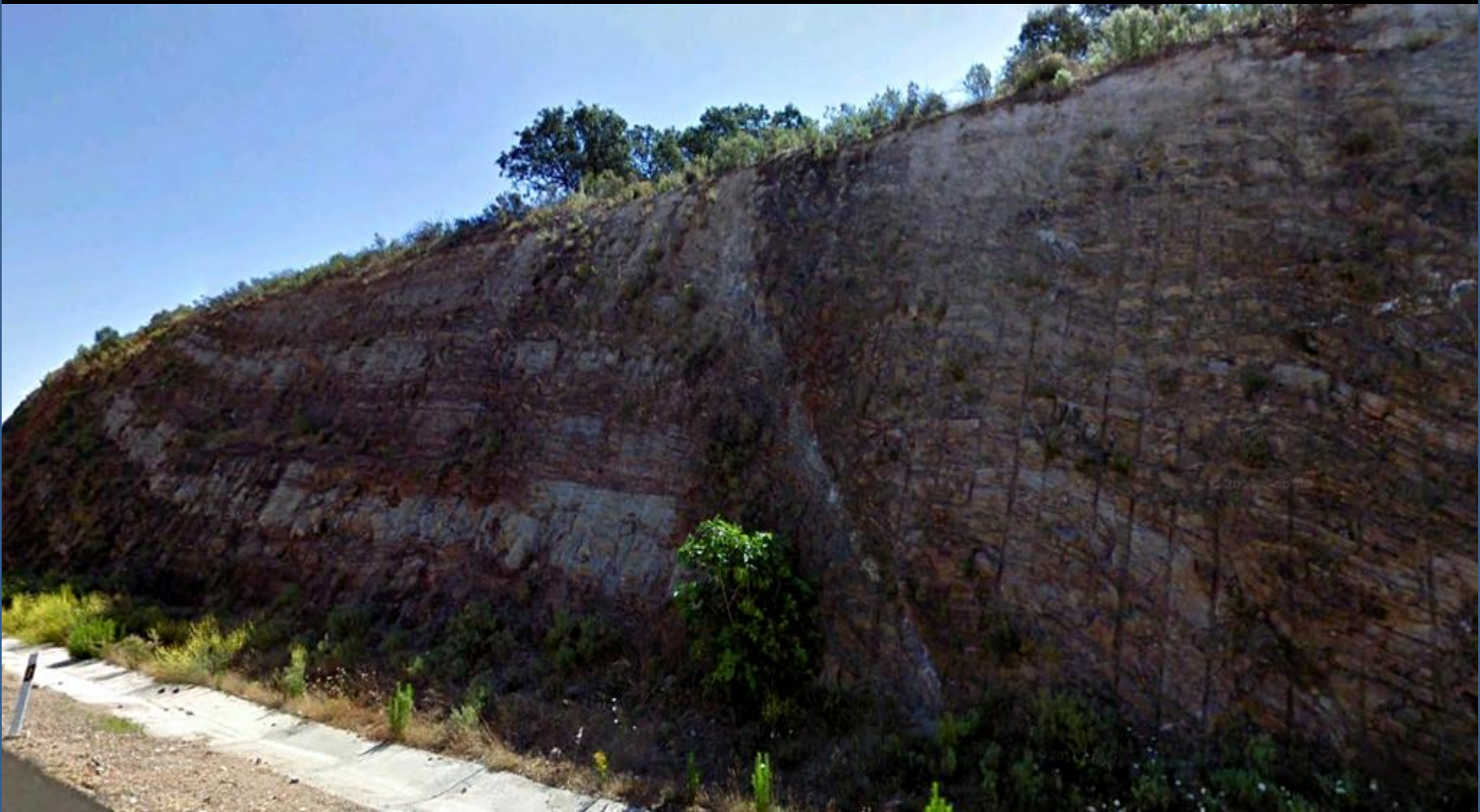
Detalle en zona anterior: Pliegues fallados en los sedimentos del Precámbrico Sup. Al NW de Romangordo. Centro NW de Hoja de Jaraicejo. Cáceres.
