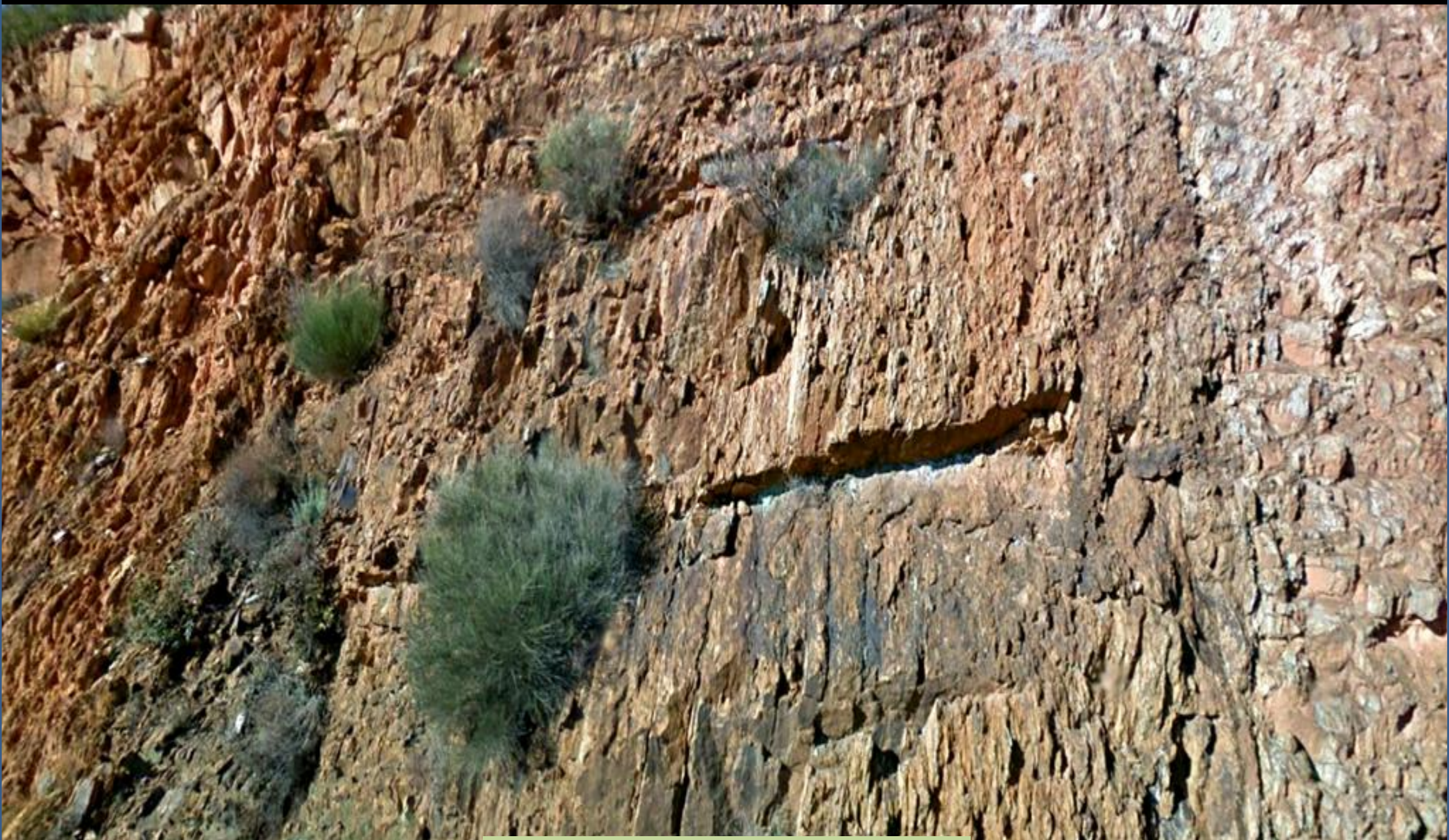
En estribo izq. Presa de Aliseda. Cáceres. Zona de cuarcitas y pizarras del Devónico. SW Hoja de Arroyo de La Luz.
