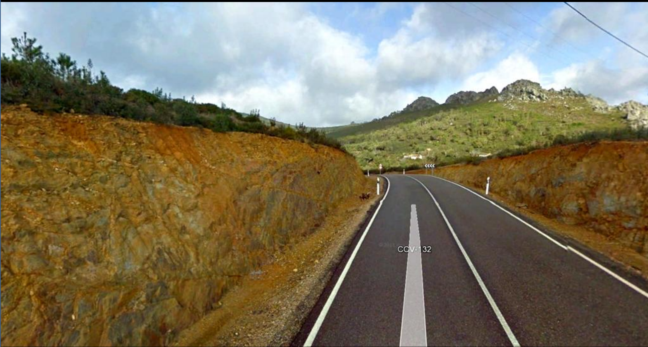
Taludes en las filitas del Ordovícico Inf. Puerto de Aguas Claras, S de Valencia de Alcántara, Cáceres. NE Hoja de Pino de Valencia.
