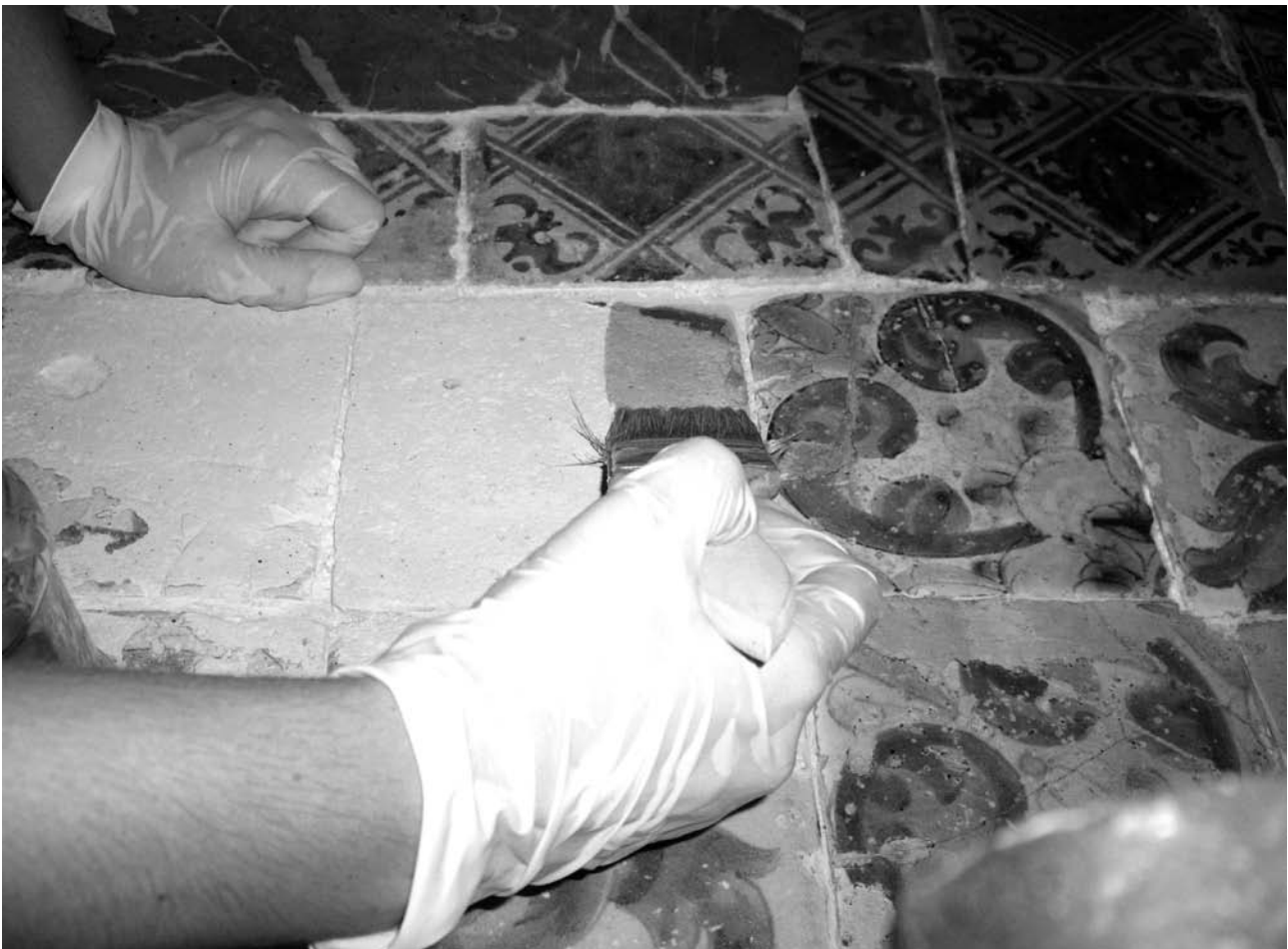
Figura 3. Tratamiento de consolidación por impregnación
