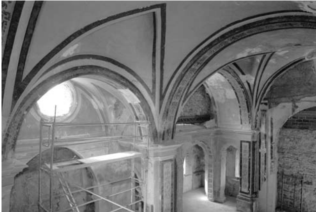
Figura 1. Vista general del interior de la iglesia antes de la intervención
