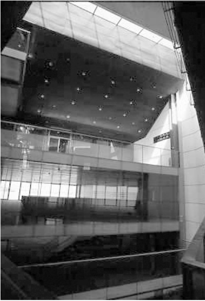
Figura 20. Pieza de Salón de Actos revestida al exterior de cobre
