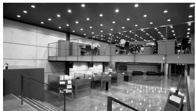
Figura 25. Pavimento de piedra Sierra Elvira en cota de acceso
