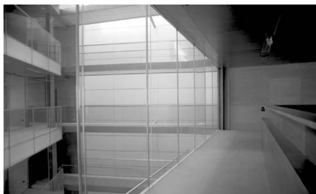
Figura 9. Entrada de luz por lucernario lateral
