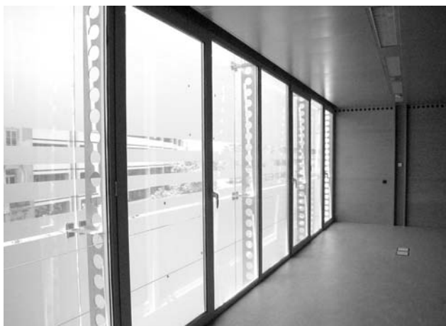
Figura 18. Detalle de fachada
