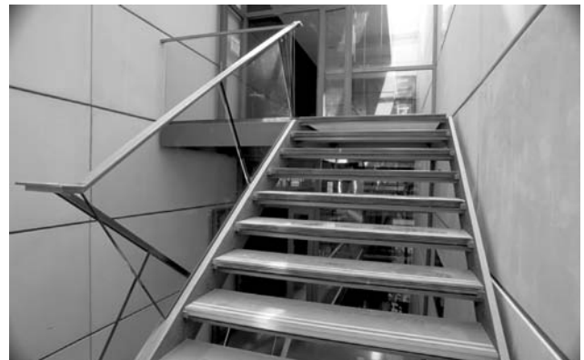
Figura 24. Peldaños de las escaleras en vidrio
