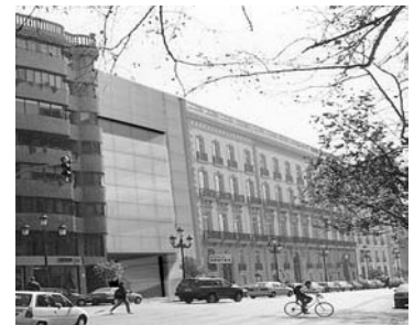
Figura 5. Vista de la fachada a Plaza de Tetuán
