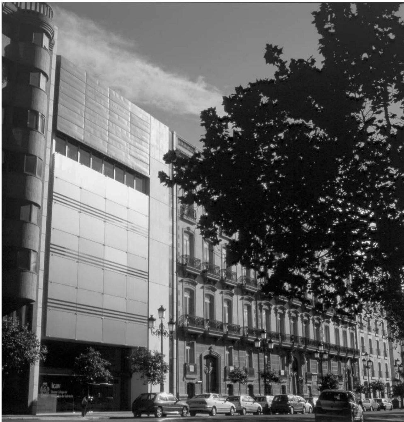
Figura 26. Vista de la fachada a Plaza de Tetuán
