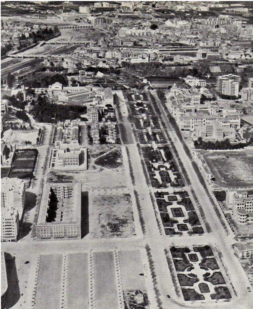
Imagen nº 25.- Primer tramo terminado de la Avenida 39
