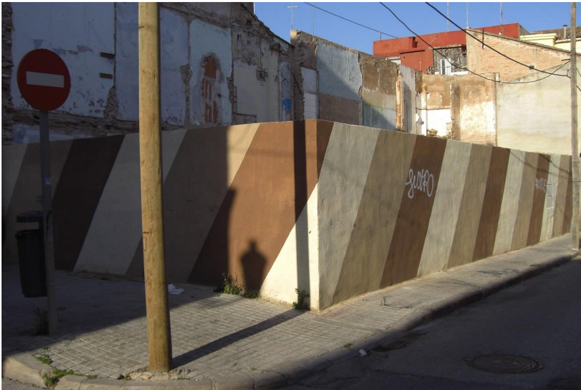
Imagen nº 46.- Solar en C/ Carlos Ros nº 5y7.
