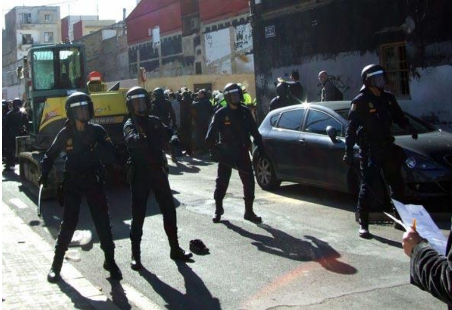
Imagen nº 37.- Excavadoras custodiadas en el derribo del edificio C/ San Pedro 37. 64
