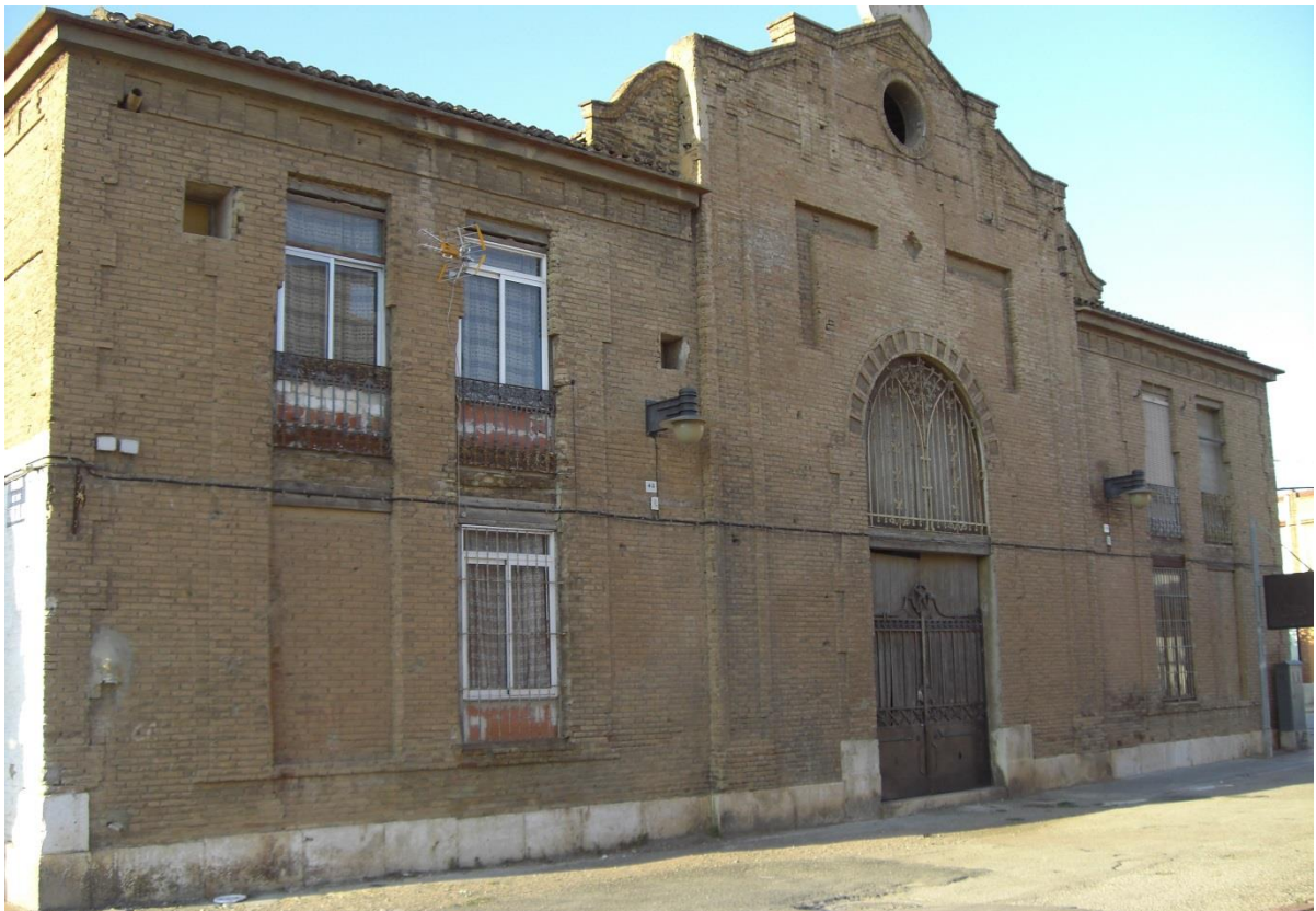
Imagen nº 48.- Fachada principal de la Lonja.
