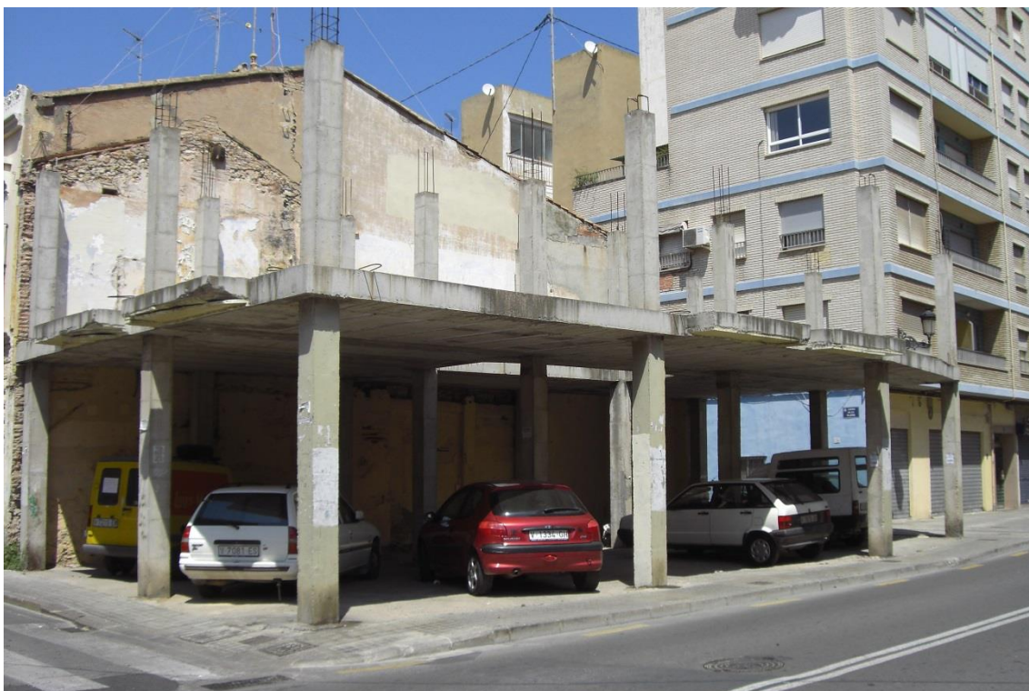
Imagen nº 44.- Obra parada en C/ Pintor Ferrandis nº11.
