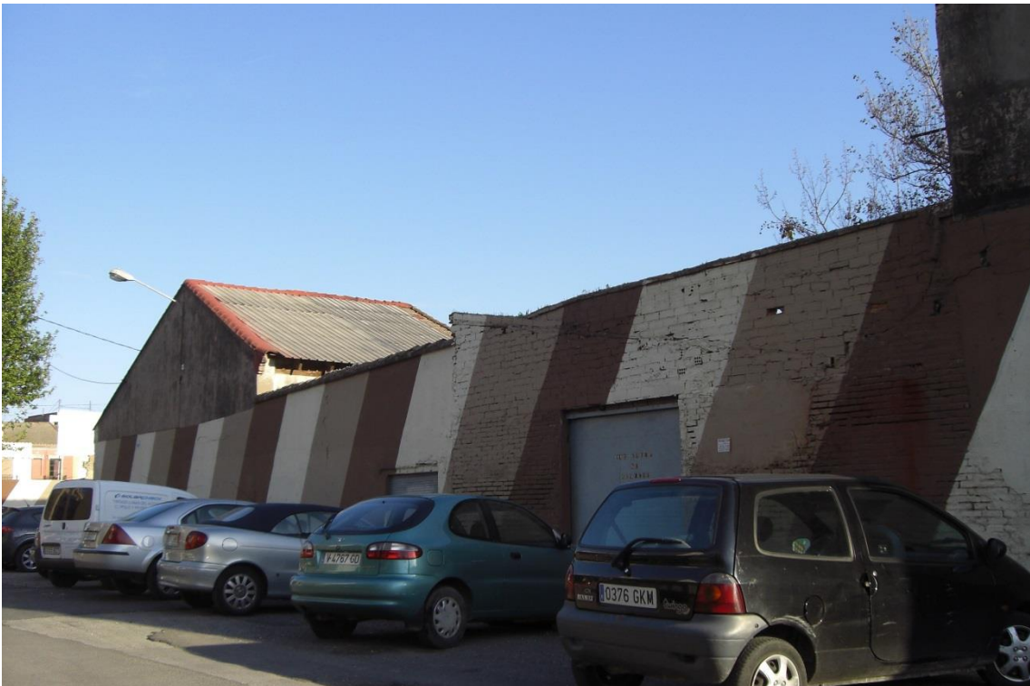
Imágenes nº 42-43.- Solares para edificios de realojo en Av. Blasco Ibáñez.
