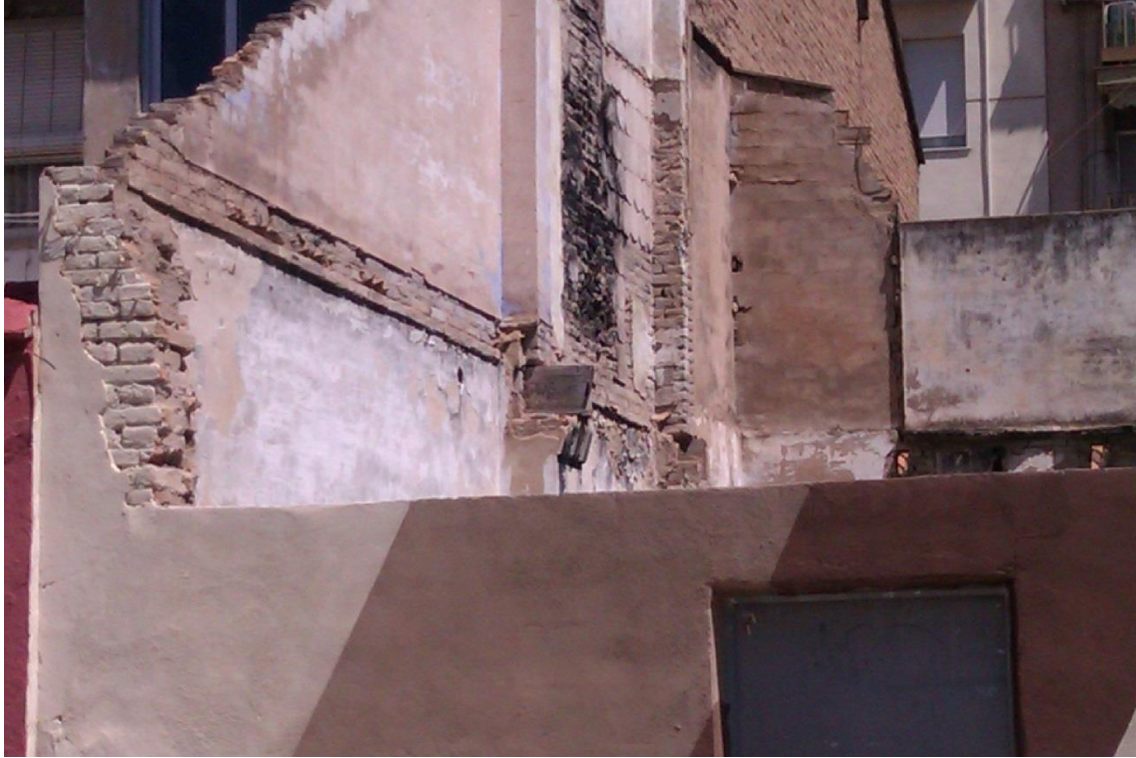
Imagen nº 21.- Sección jácena de madera de mobila apoyada en medianera, en C/ Padre Luis Navarro 252.
