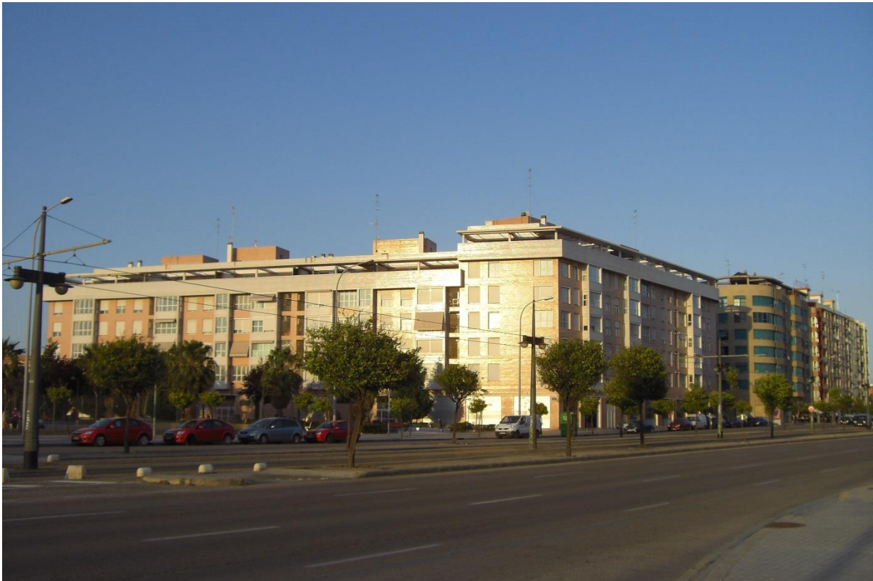
Imagen nº 39.- Edificio para realojos en Av. de los Naranjos nº 33.
