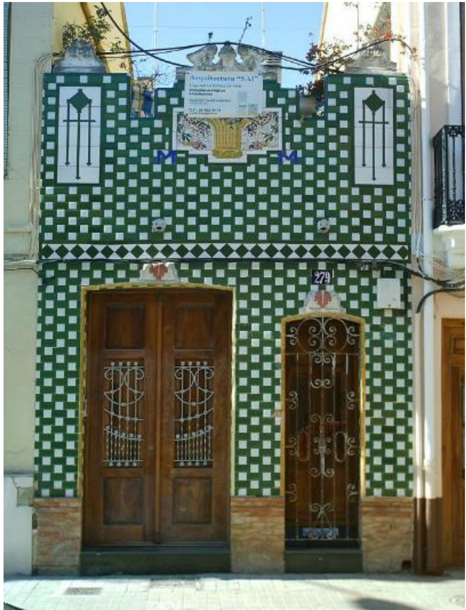
Imagen nº 12.- Vivienda en C/ Progreso 279.
