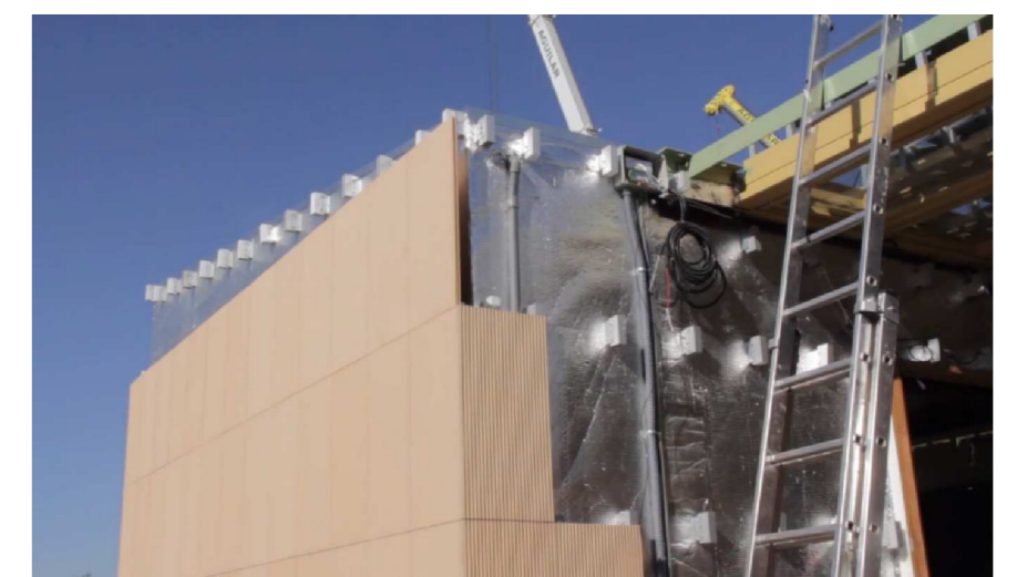
Aislante reflexivo y fachada ventilada
