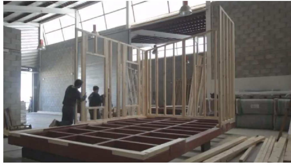
Montaje cerramiento en taller
