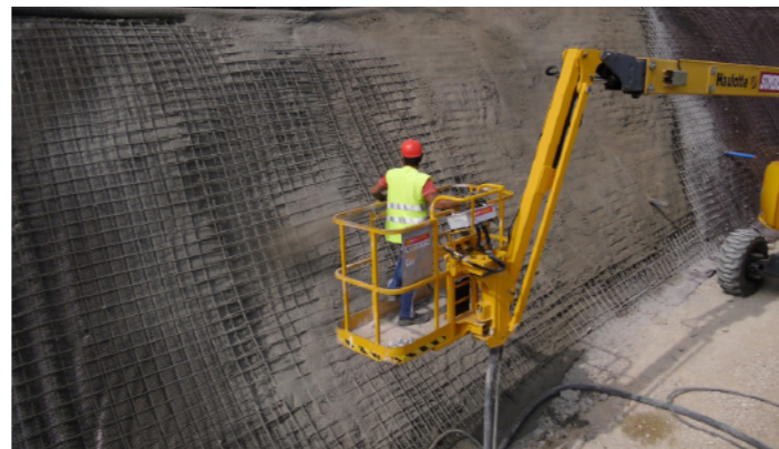
Foto 5.20 Proyección de hormigón por vía seca
