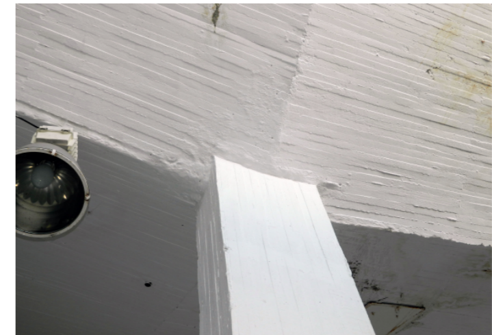
Foto 5.18 Foto Unión pilar-paraboloides hiperbólicos
