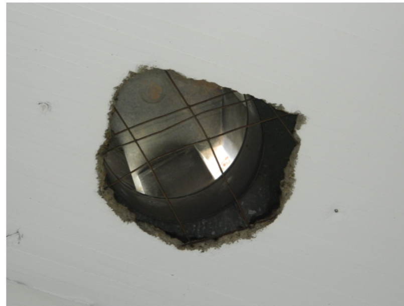
Foto 4.15 Apertura de huecos en paraboloides hiperbólicos 02
