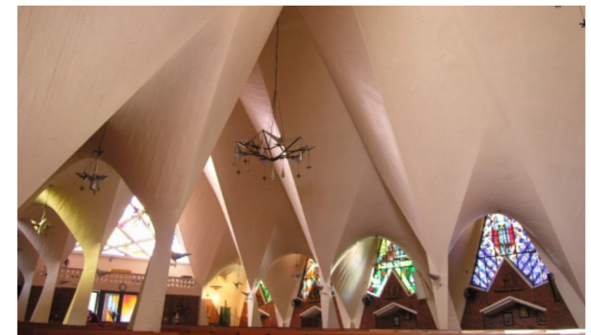
Foto 3.2 Iglesia de la Medalla Milagrosa (1954-1955), Félix Candela, utilizó paraguas invertidos para su construcción.
