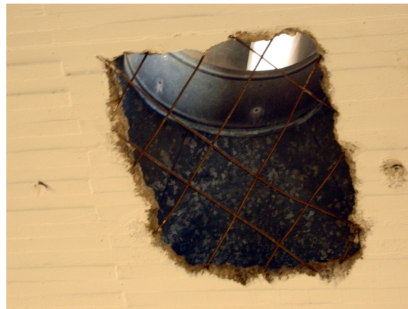
Foto 4.16 Apertura de huecos en paraboloides hiperbólicos 03
