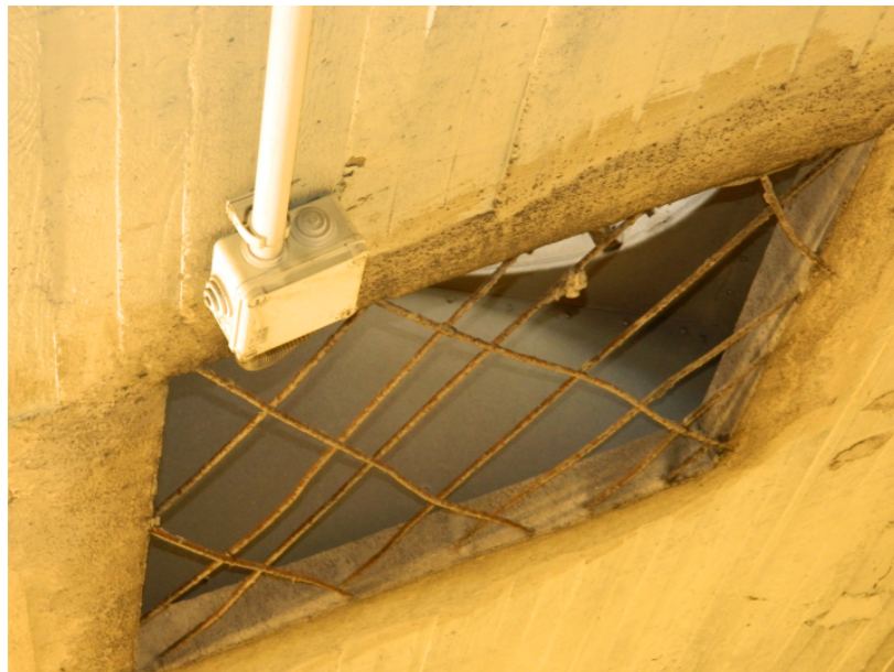
Foto 4.14 Apertura de huecos en paraboloides hiperbólicos 01
