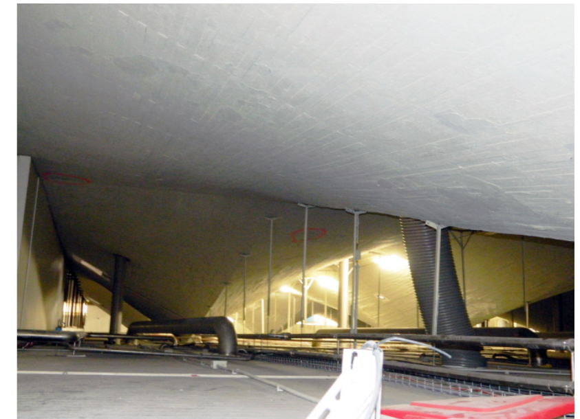
Foto 4.17 Estructura del falso techo, colgada de los paraboloides.
