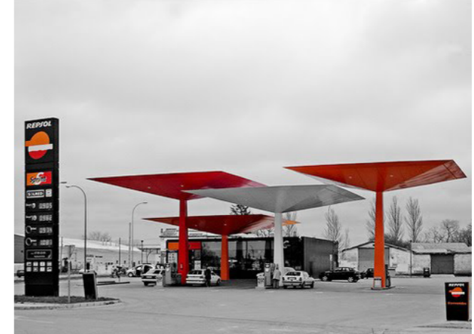
Los diseños de Norman Foster para Repsol, son una reinterpretación de los paraguas invertidos de Candela, con otros materiales y un agregado de color.
