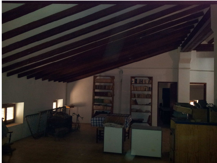
PARES EMPOTRADOS EN MURO DE CARGA DE FACHADA
