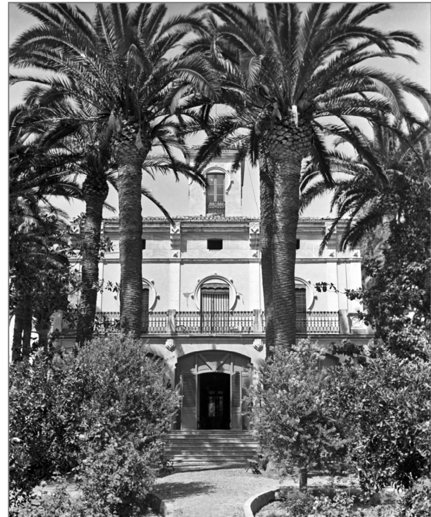
FOTO ORIGINAL DE LA FACHADA PRINCIPAL
