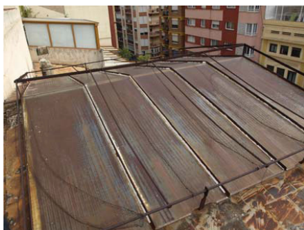
Claraboya de casetón de escalera.
