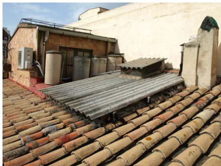
Claraboya de patio de luces.
