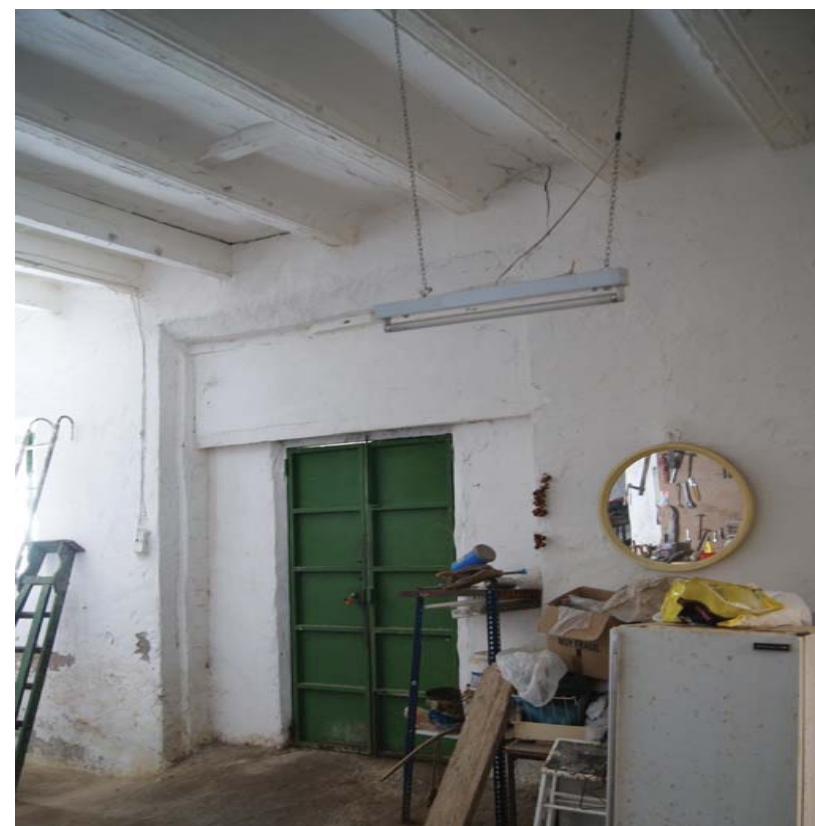
Fig 5.27: Puerta acceso ELE Planta Baja
