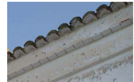
Fig 3.47: Alero fachada oeste
