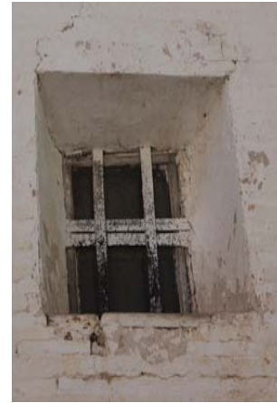
Fig 3.66: Ventana alzado oeste
