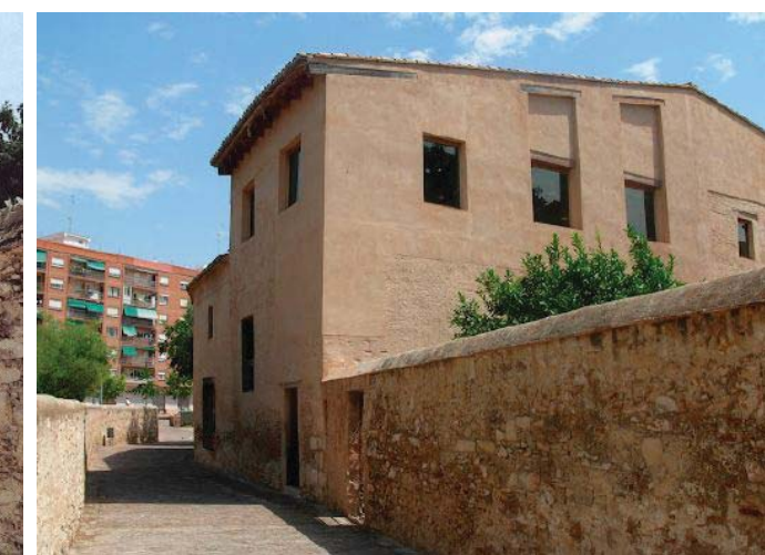
Fig 2.26: Fachada posterior Alquería de Barrinto 2011
