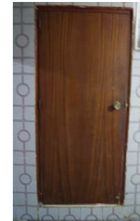
Fig 3.70: Puerta salida patio 1
