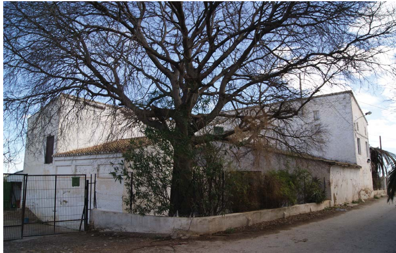
Fig 5.5: Fachada Sur - Oeste
