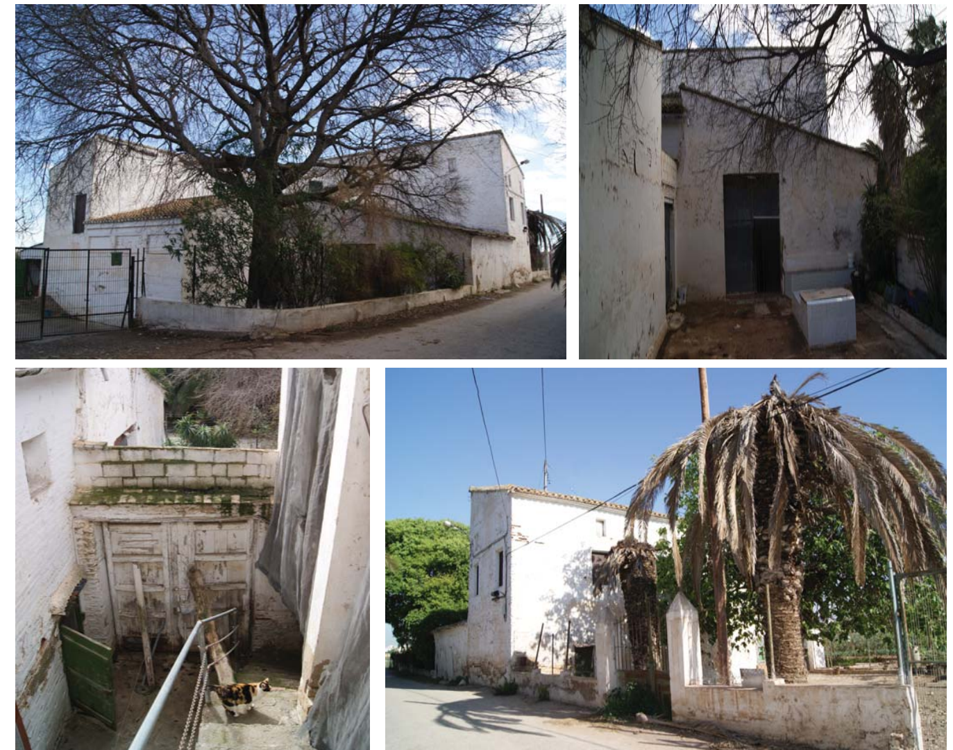
Fig 3.5: Vistas de la fachada principal y patio interior
