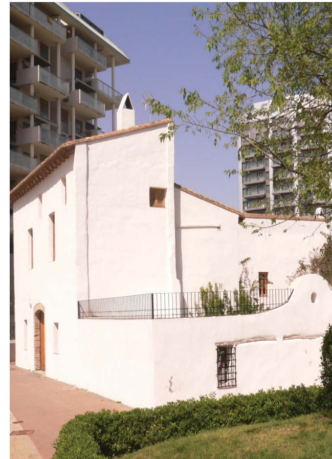
Fig 6.3: Fachada posterior Alquería Puchades
