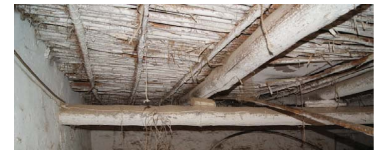
Fig 3.44: Forjado de cañizo
