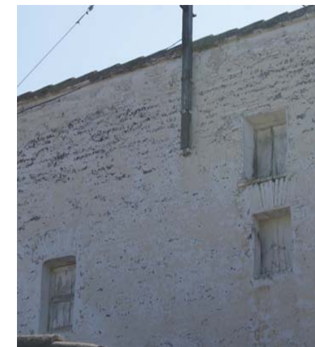
Fig 3.60: Ventana alzado oeste
