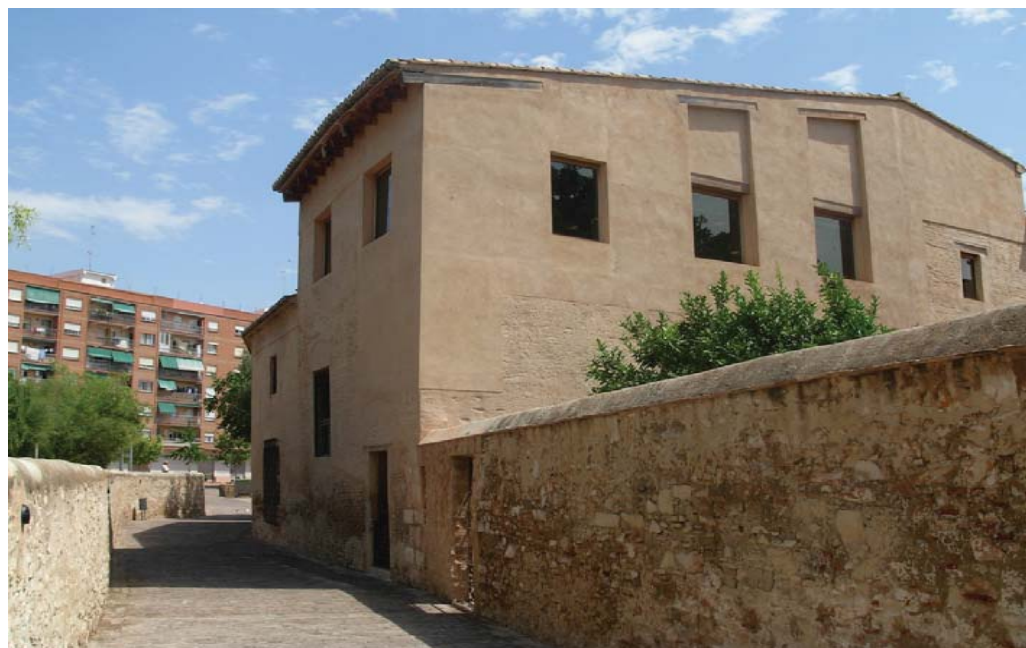
Fig 6.2: Fachada posterior Alquería de Barrinto
