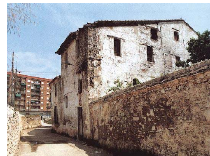
Fig 2.25: Fachada posterior Alquería de Barrinto 1996
