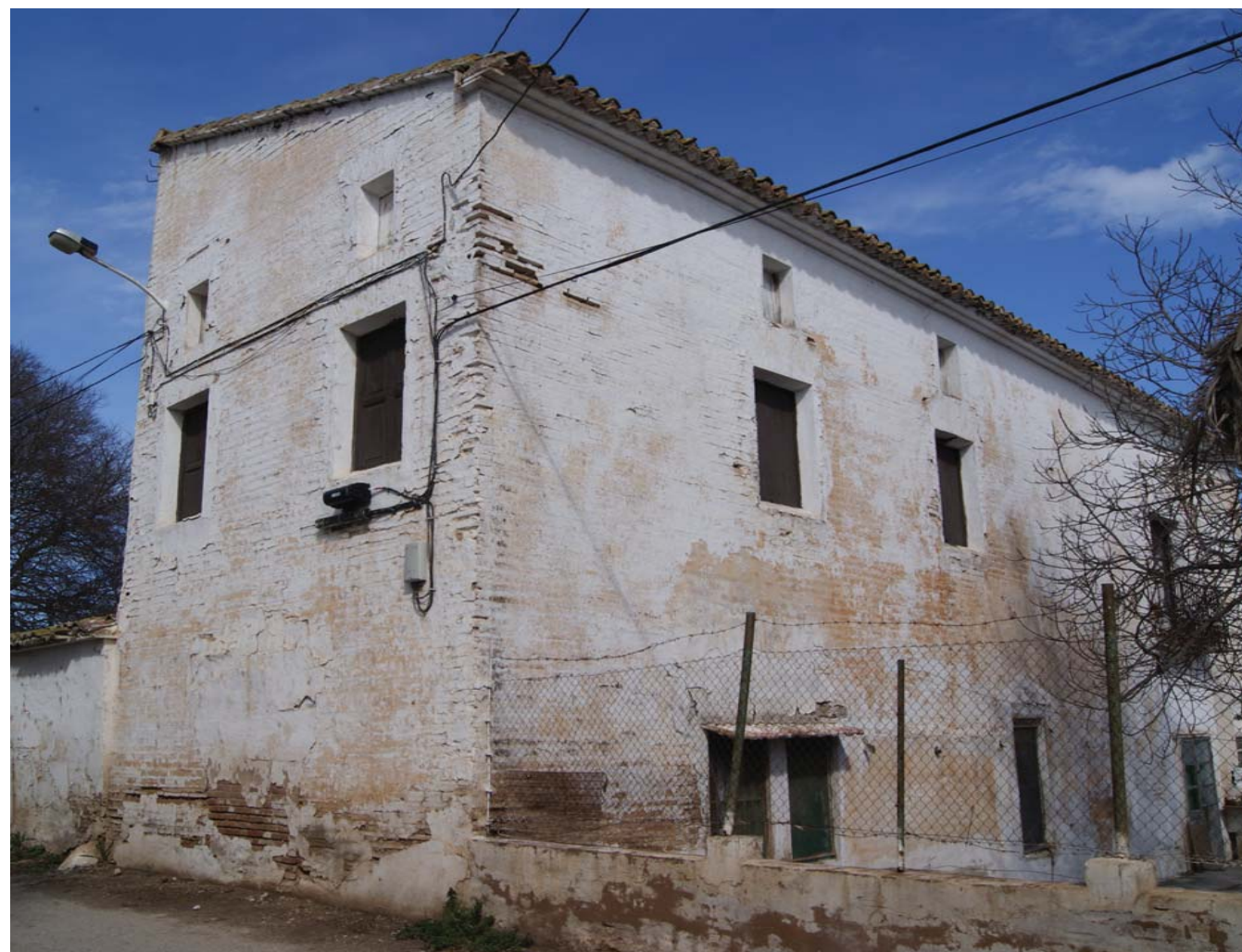
Fig 3.6: Vista de la carpintería en fachada principal
