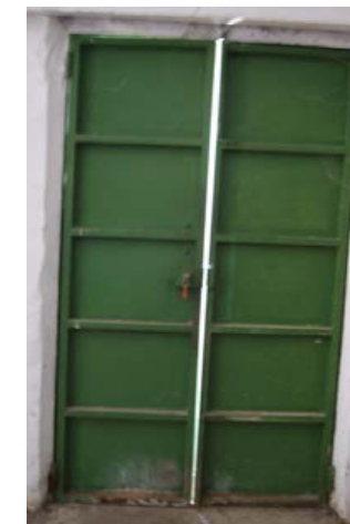
Fig 3.73: Puerta fachada E
