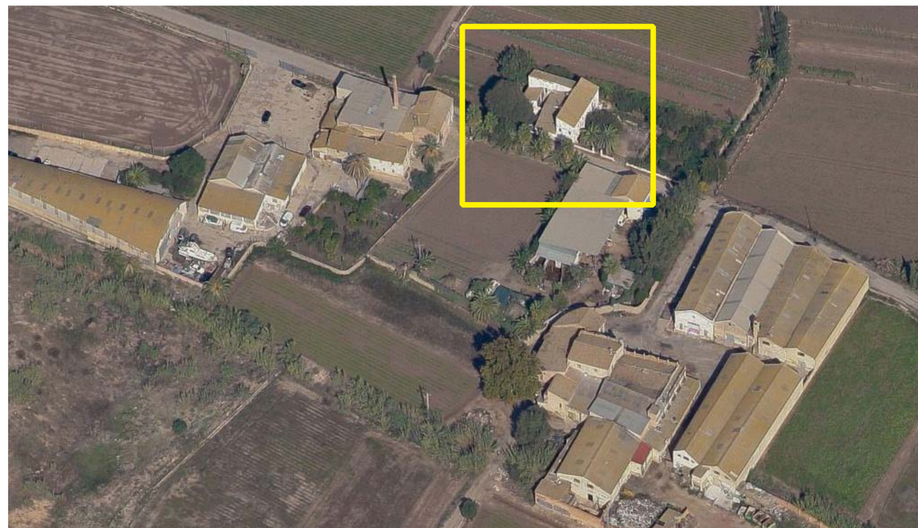
Fig 1.8: Conjunto de Alquerías Partida de Dalt
