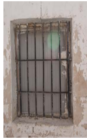
Fig 3.65: Ventana alzado oeste
