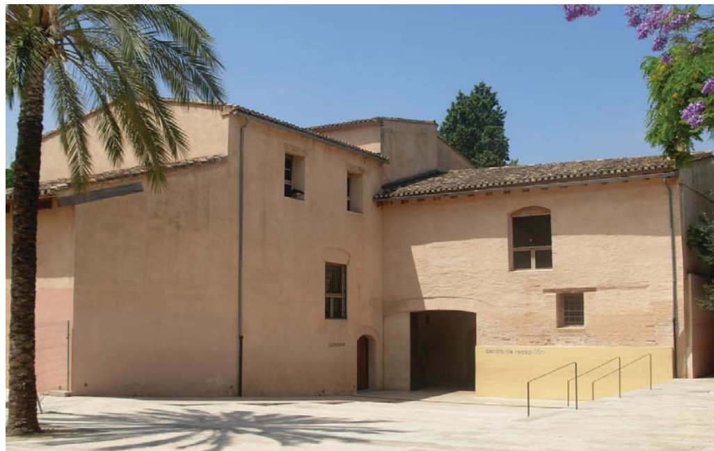
Fig 6.1: Puerta principal Alquería de Barrinto
