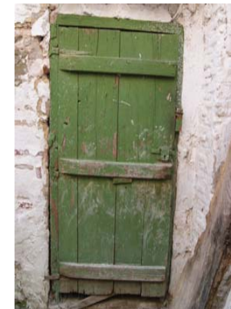
Fig 3.71: Puerta salida patio 2
