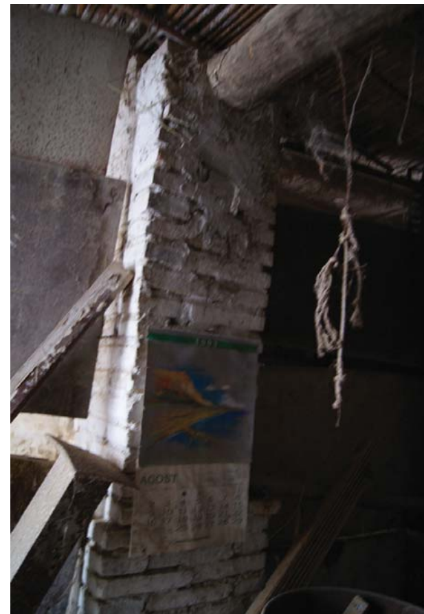
Fig 3.43: Pilar de ladrillo macizo
