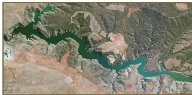
Ilustración 8. Fotografía aérea del Embalse de Arquillo de San Blas. Google Earth. 2013
