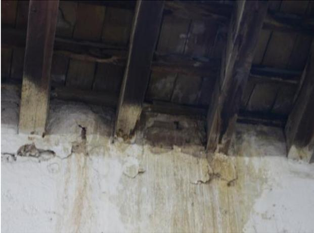
**Imagen: Humedad presente en el encuentro de los pares de la cubierta y el muro.**
