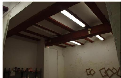
Imagen Viga con registro de cajas para control de termitas.
