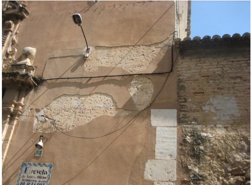
Imagen: Desconchados de existentes en la fachada suroeste en su zona derecha intermedia del edificio por falta de adherencia. Fuente : propia
