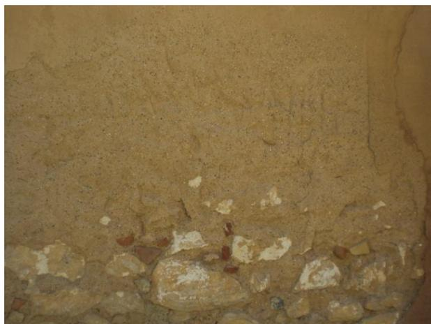
Imagen: Arenización producida en la fachada suroeste , observamos la pérdida de revestimiento. Fuente: Propia
