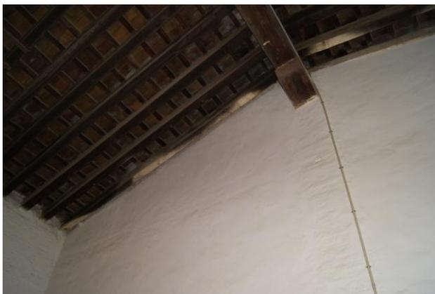
Imagen Detalle cubierta donde se observan los pares correas y cobertura de ladrillo fuente: propia
