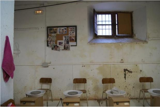
Imagen: Humedades presentes en el interior del muro de fachada noroeste, se observa la decoloración del paramento . Fuente: Ana Valls
