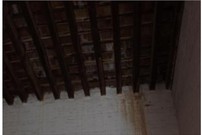
**Imagen: Humedad presente en el encuentro de los pares de la cubierta y el material de soporte de la cubierta.**
