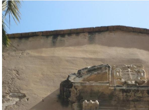
Imagen: Lavados negros bajo el faldón de la cubierta en la fachada principal. Fuente: propia
