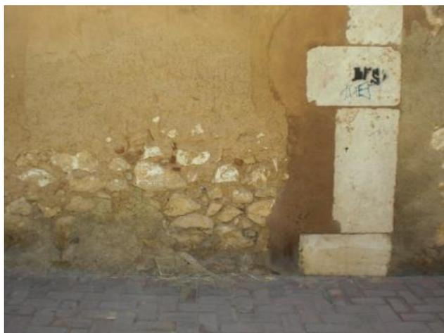
Imagen: Arenización producida en la parte inferior derecha de la Fachada Suroeste Observándose las piedras del muro ordinario. Fuente: Propia
