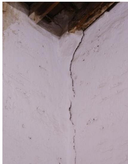
Imagen: Grieta Vertical en la fachada Noroeste, producida desde el encuentro del par con el muro, hasta el hueco de ventana.
