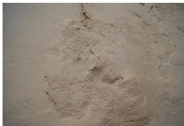
Imagen : abombamiento del revoco provocado por la humedad Fuente: Ana Valls
