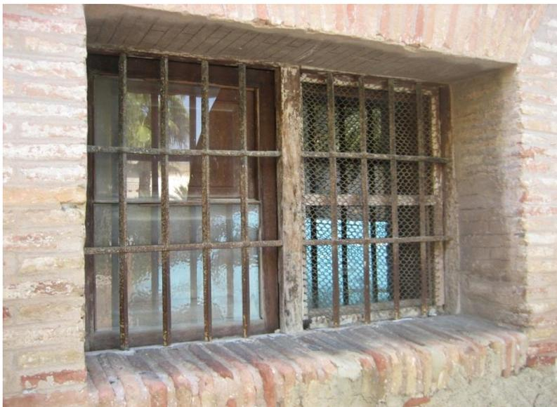
Imagen : oxidación del elemento de protección metálico existente en las ventanas de fachada noroeste.
