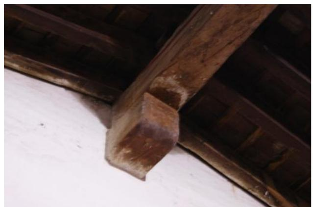
Imagen Detalle cubierta Hilera descansando en apoyo fuente: propia
