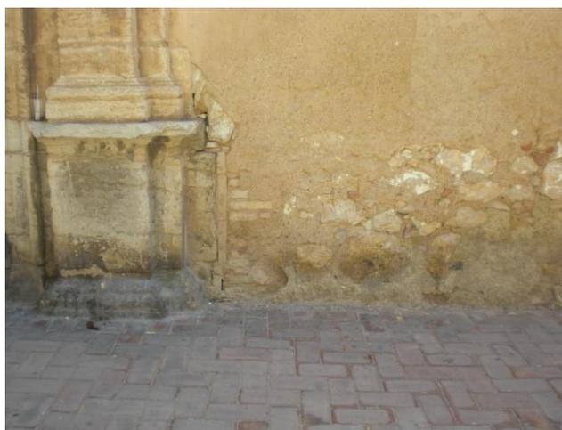
Arenización producida en la parte inferior de la Fachada Suroeste del edificio
