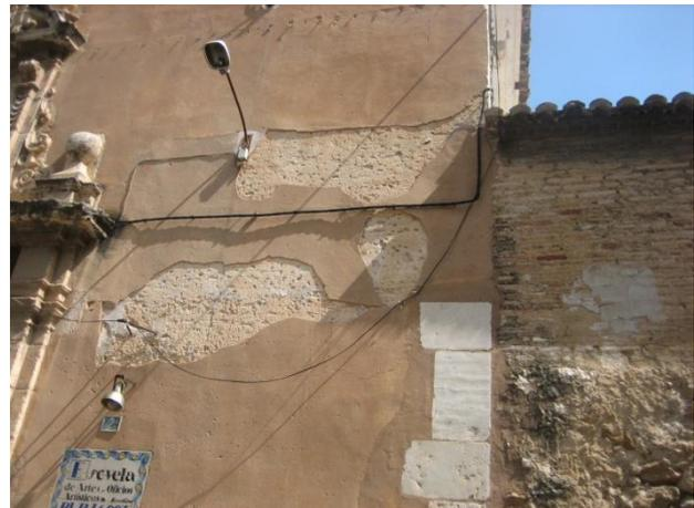
Imagen: Presencia del cableado de instalación eléctrica así como una farola, además de varios elementos metálicos empotrados en la fachada sureste del edificio
