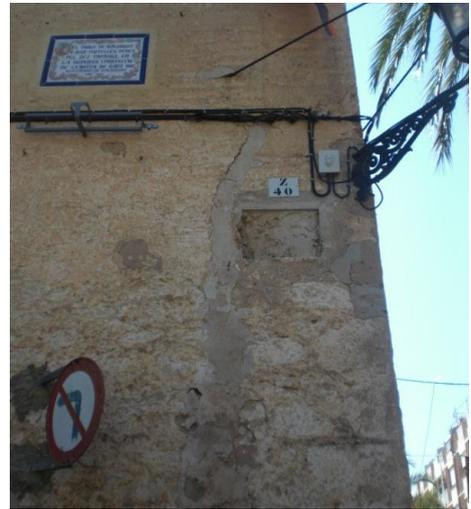
Imagen: observamos situados en la fachada suroeste, una placa de circulación y una farola entre otros elementos impropios Fuente: propia
