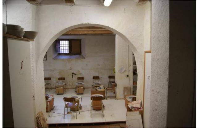
**Imagen: Arco medio punto sala principal planta baja Fuente: Propia**
