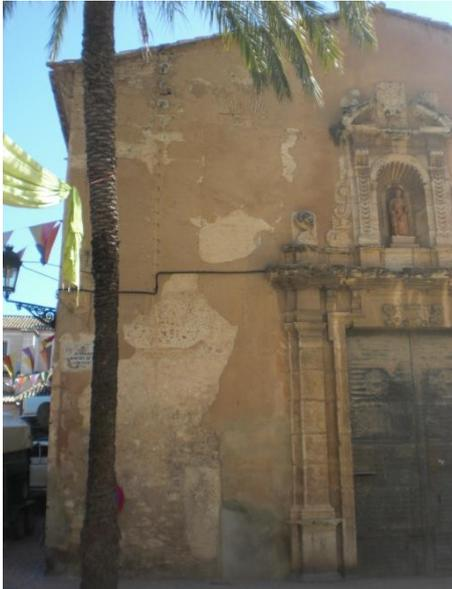
Imagen: Desconchados de gran envergadura existentes en la fachada suroeste del edificio. Fuente : propia
