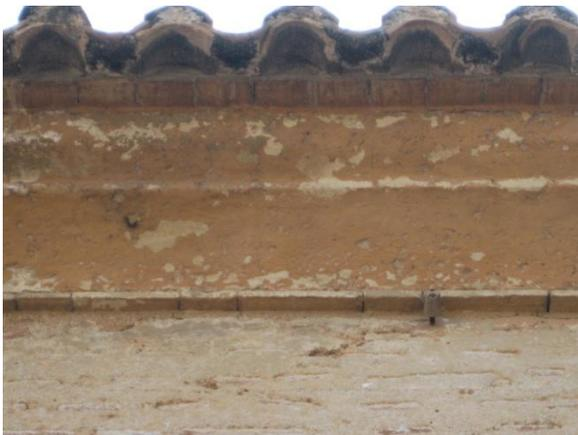
Imagen: Desconchados parciales existentes en la cornisa de la fachada Noroeste del edificio. Fuente : propia
