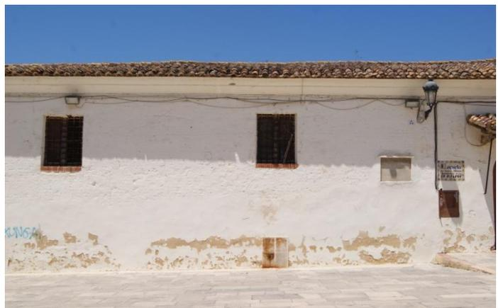
Imagen: Desconchados localizados en la parte baja de la fachada Sureste del edificio producidos por humedad. Fuente : Ana Valls
