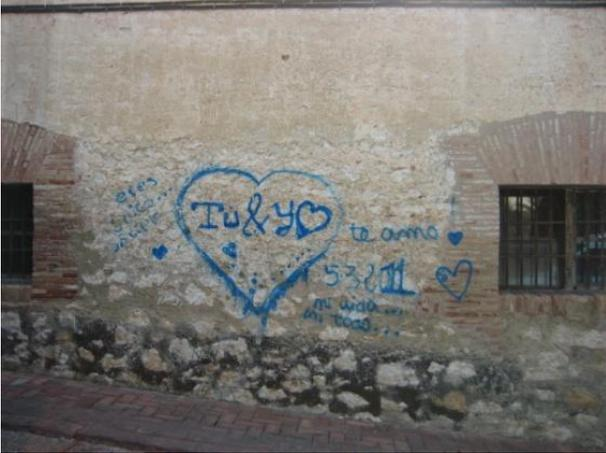
Imagen: Ennegrecimiento en la parte inferior de la fachada noroeste. Fuente: Propia
