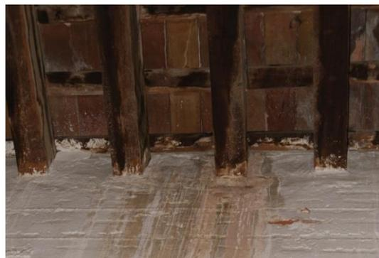
Imagen : Deterioro de los pares por filtraciones de cubierta Fuente: Ana Valls
