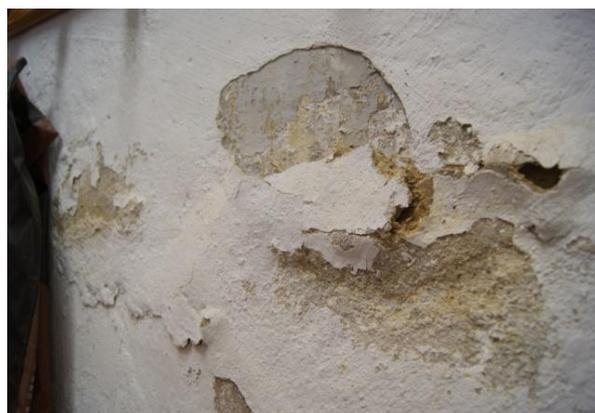
Imagen : Desprendimiento del revoco provocado por la humedad Fuente: Ana Valls
