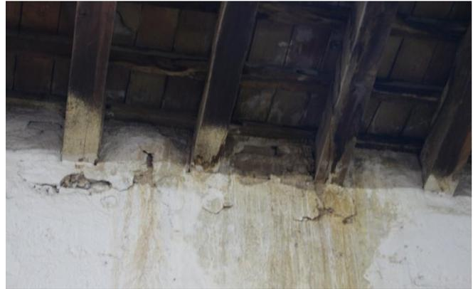
**Imagen:** Deterioro de las cabezas de los pares de cubierta, debido a la pudrición de la madera.
