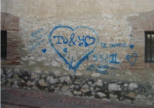
Imagen: Grafiti realizado en la fachada recayente a la subida de san Roque, observamos pintadas impropias sobre el paramento. Fuente: Propia
