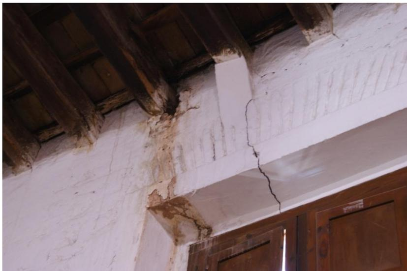
Imagen: Grieta Vertical en el encuentro de esquina entre las fachadas sureste y suroeste, puede observarse como han intentado rellenar la misma con argamasa y mortero.
