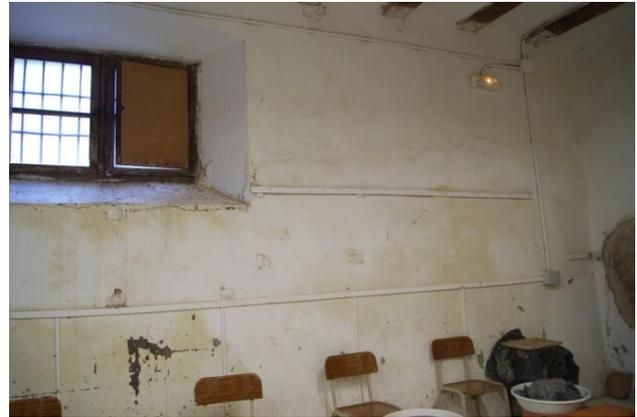
Imagen: Observamos la presencia de humedades y los posteriores desconchados que producen así como el deterioro de la carpintería de madera. Fuente: Ana Valls
