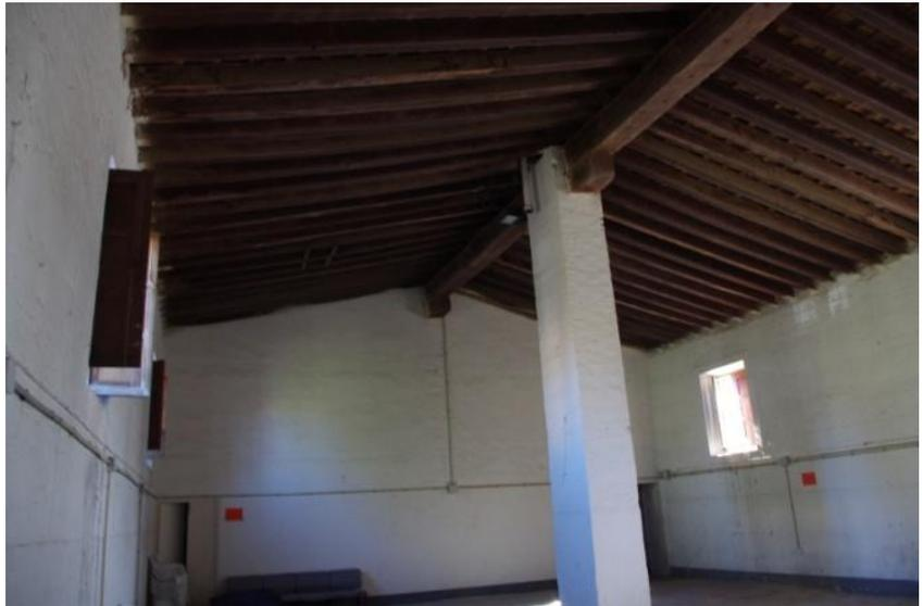
Imagen: Cubierta a dos aguas fuente: propia
