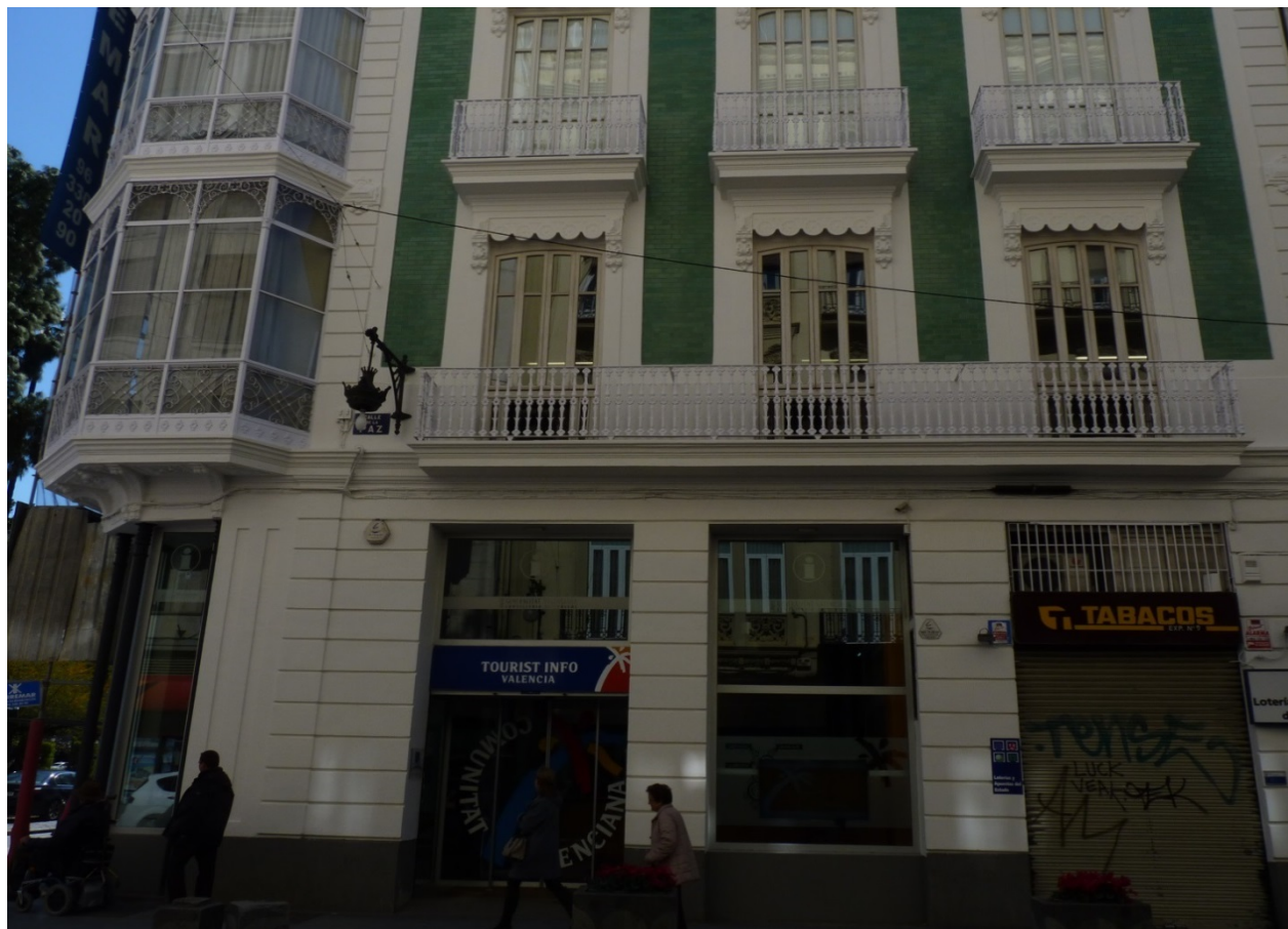
Edificio Bolinches: fachada recayente a la calle de la Paz.
