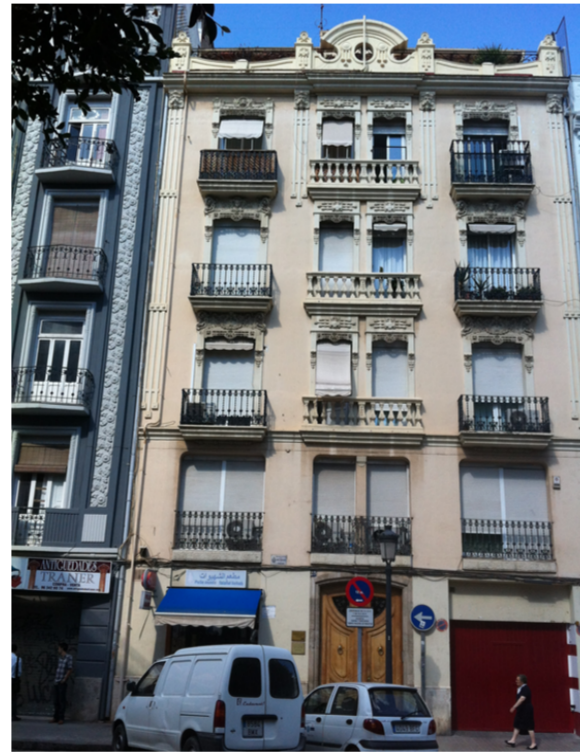
Edificio de viviendas en la C/ Sueca nº 25 (1912).
