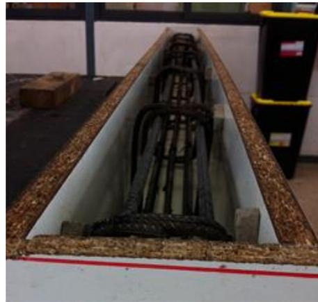
Imagen 35. Colocación de los separadores
