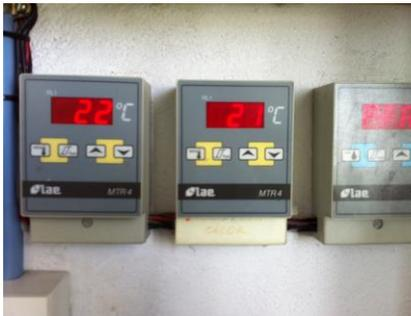
Imagen 5. Termómetro cámara de curado
