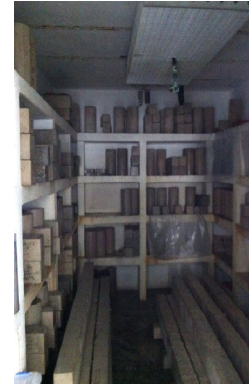
Traslado de vigas y probetas a la cámara de curado
