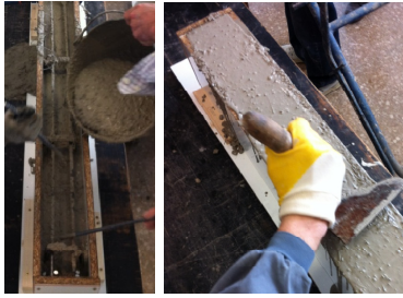
Hormigonado de vigas
