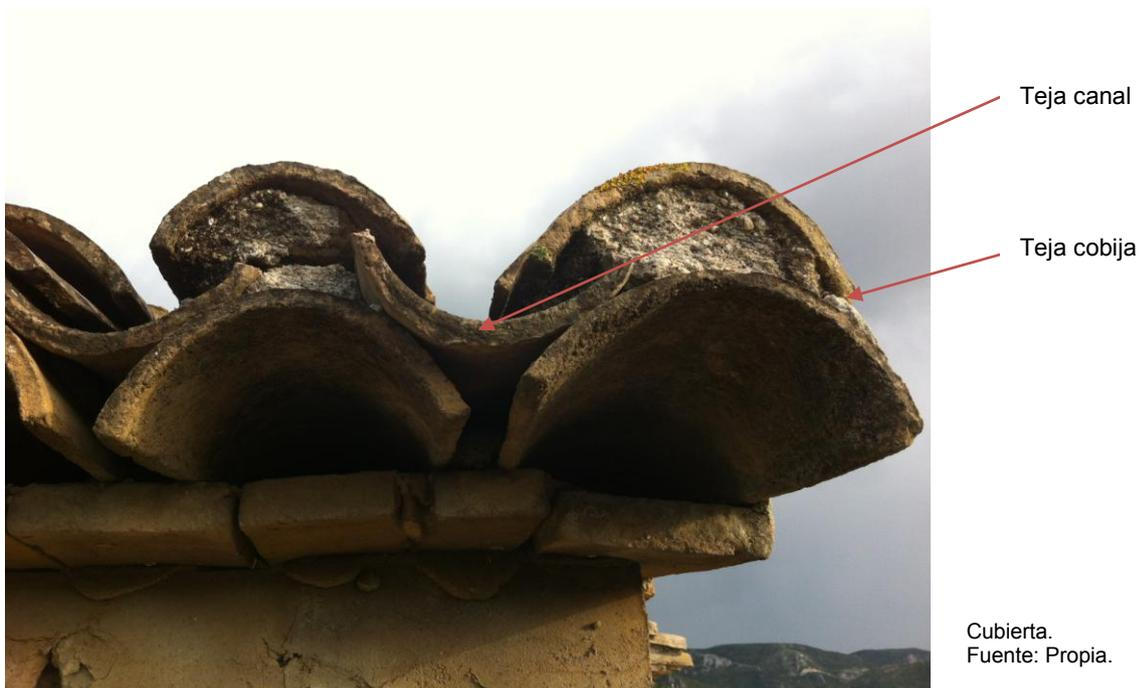
Después, se colocan las tejas, cogidas con mortero, en el arranque para replantear la cubierta, y una hilera vertical de tejas, también cogidas con mortero, en los laterales, para tener una referencia. Seguidamente, con un poco de mortero, se va colocando la primera hilera en horizontal, con canales y cobijas, estos se ejecutará de manera ascendente.
