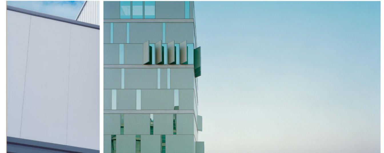
Se ha optado por un panel con acabado de aluminio para el revestimiento del edificio. Dadas las características técnicas de este panel, la piel exterior del edificio va a ejercer un papel muy importante para el confort interior.
