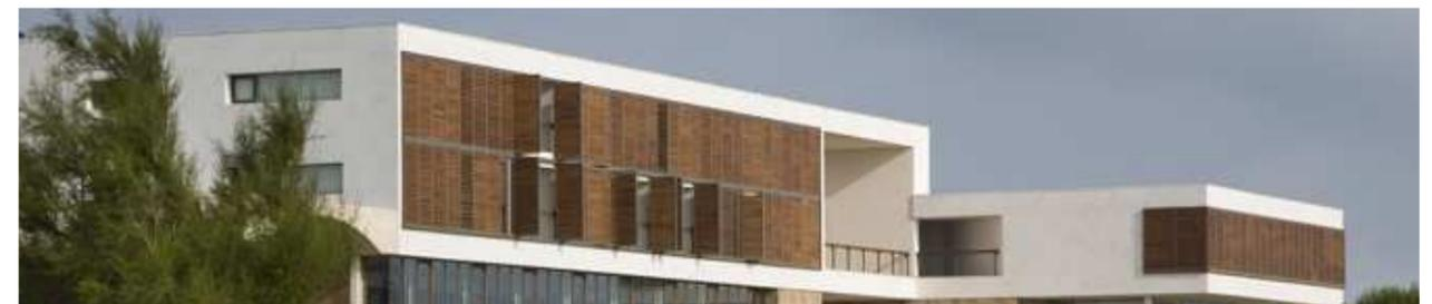
Para marcar de una manera contundente la organización interior, en las fachadas este y oeste se disponen lamas verticales de hormigón de mucha más sección en el espacio que ocupa el corredor central del edificio y que atraviesa el vestíbulo, estas lamas serán de de hormigón pretensado de 10 x 40 centímetros y separadas 35 centímetros.
