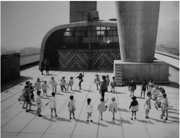
Cubierta, Unidad de habitación Marsella, LC
