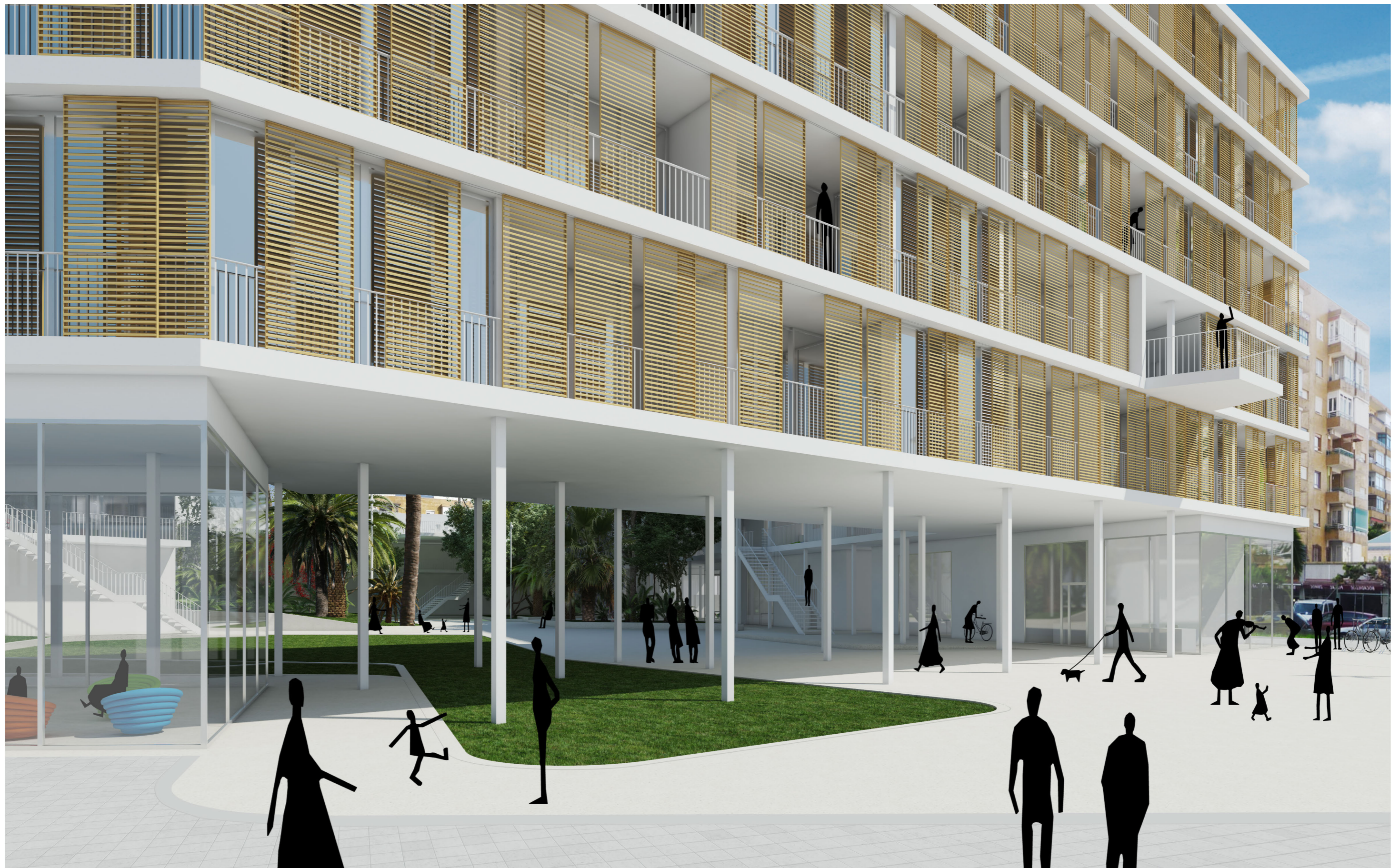
alumno nacho company selma . tutor manuel lillo navarro. pfc taller 2. edificio híbrido de viviendas + equipamientos.
