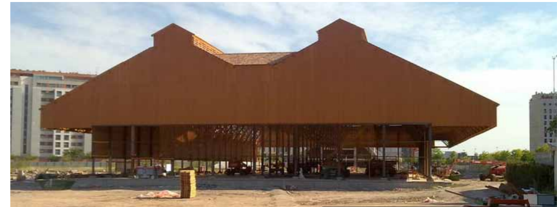
estado actual, exterior
