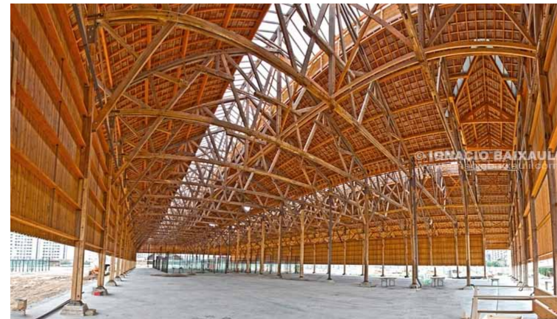
estado actual, interior
