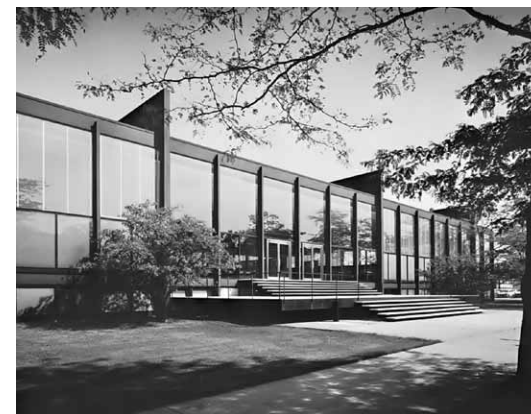
CROWN HALL, M.VAN DER ROHE
