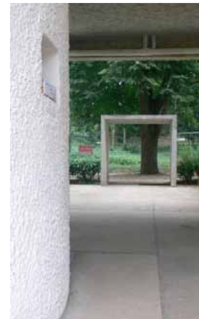
CONVENTO LA TOURETTE, LE CORBUSIER
