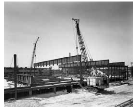
CROWN HALL EN CONSTRUCCIÓN
