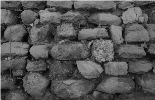
Figura 13. Detalle de fábricas y modulación (m/vara), Torre de Valhermoso medio, ya se trate de madera, piedra o cal.
