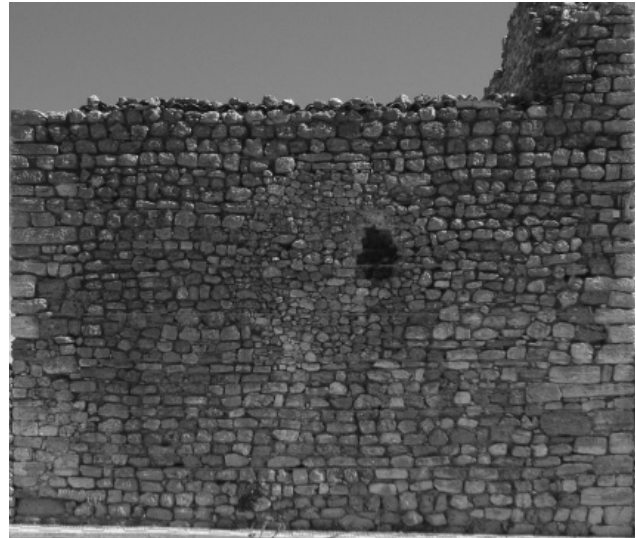
Figura 14. Detalle del alzado suroeste de la torre de Solera donde, a pesar de la intervención a posteriori en la zona del vano, se aprecian las hiladas de las posibles jornadas de trabajo .
