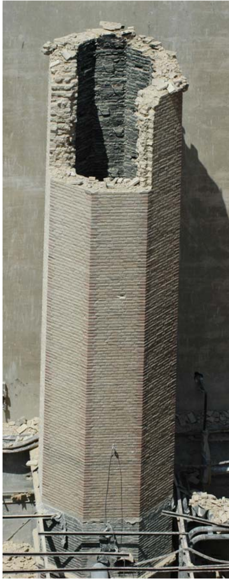
Figura 2.1: Chimenea derribada de Manufacturas Aracil, Valencia
