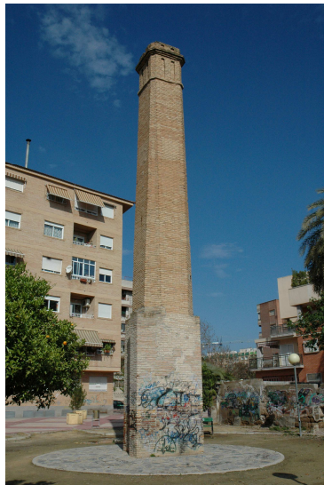
Figura 4.66: Chimenea octogonal, Llaurí (Valencia)
