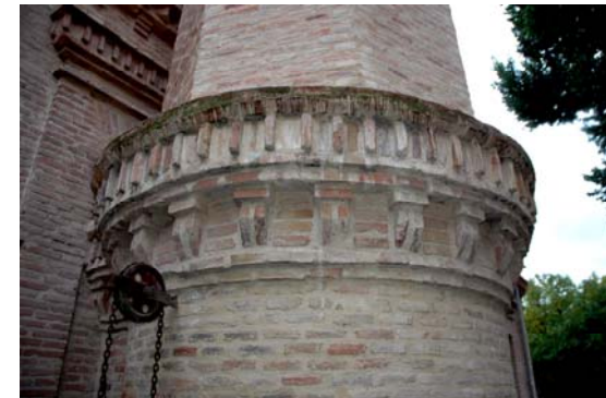
Figura 5.191: Cornisa dentellado pareado en T con espaciado a tizón en chimenea de cerámica Pascual Barreres, Oliva (Valencia)
