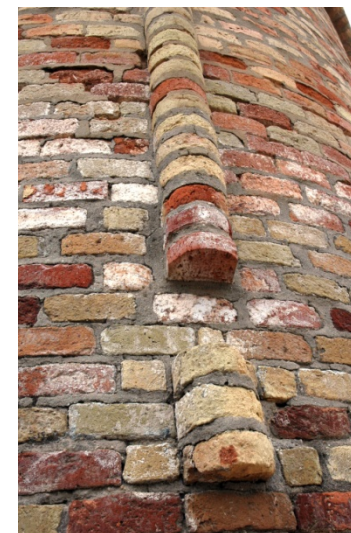
Figura 5.18: Ladrillo aplantillado utilizado en la chimenea de la papelera Layana, Valencia
