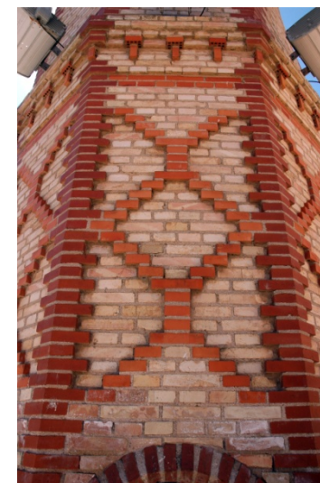
Figura 5.44: Base de la chimenea de la Estación, con dos tipos de rombos, Albaida (Valencia)
