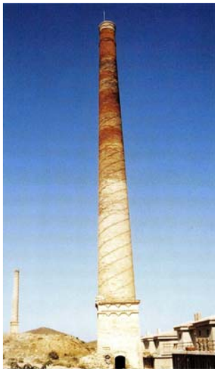
Figura 6.225: Chimenea de fábrica conservera con pintado helicoidal, Calasparra (Murcia)
