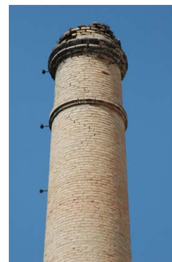
Figura 6.190: Corona de chimenea de la fábrica de conservas Esteva, Alcantarilla (Murcia)
