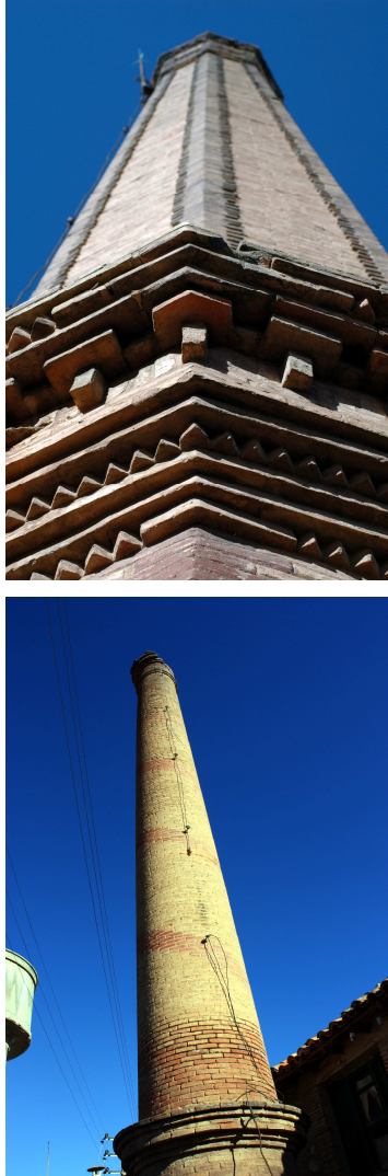
Figura 4.204: Chimenea de fuste y base de sección octogonal realizada por valencianos de Resinera del Carmen, Teruel
