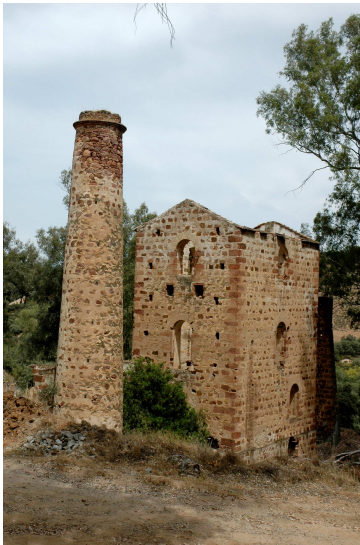
Figura 4.141: Chimenea adosada a la esquina de casa de máquinas Cornish de Pozo Ancho, Linares (Jaén)
