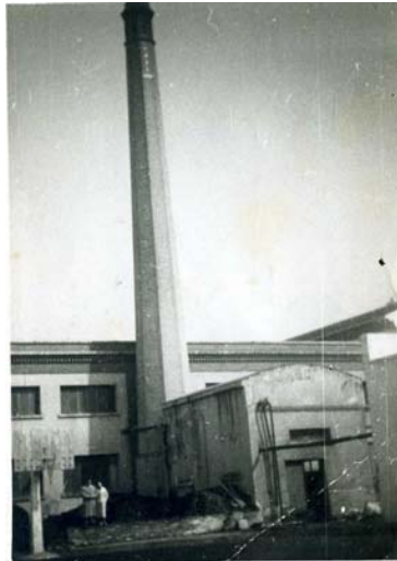
Figura 6.94: Ejecución de la chimenea de Estambrera Riojana, Logroño. Archivo familia M. Crespo
