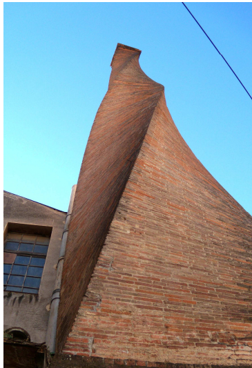
Figura 4.62: Chimenea tejera Puertollano, Ciudad Real
