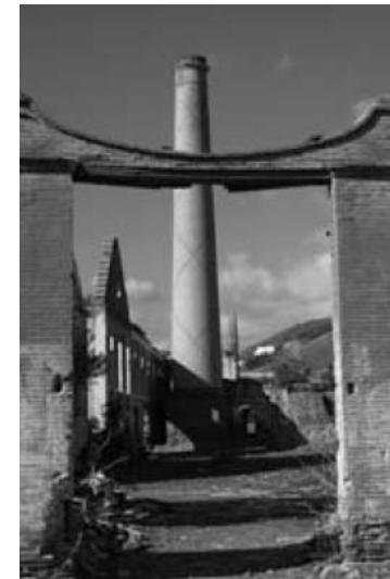
Figura 4.175: Chimenea de la cerámica llamada La Peladera, Segovia
