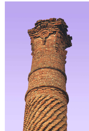
Figura 4.103: Corona chimenea Lechera El Prado, Valencia
