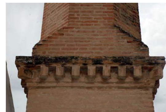
Figura 5.145: Cornisa dentellado pareado sin T en calera de Chaume, Requena (Valencia)
