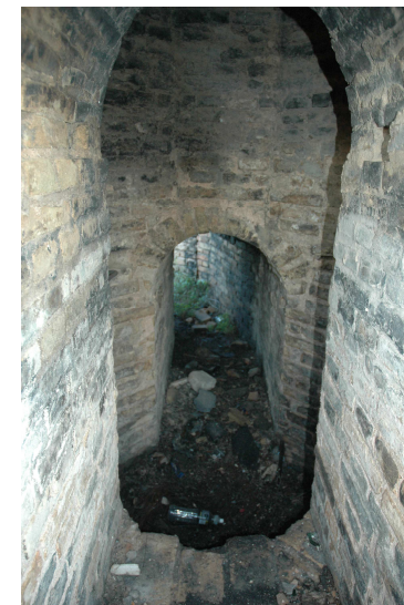
Figura 4.30: Entrada bajo rasante en Bodega Hnos. Espinosa, Tomelloso (C. Real)
