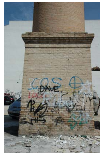
Figura 6.199: Base de chimenea con pendiente y cornisa de hiladas corridas de fábrica Esteva, Alcantarilla (Murcia)
