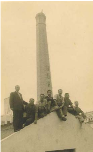
Figura 6.8: Chimenea en construcción fábrica de café Borrás, Ceuta. Archivo familia Goig
