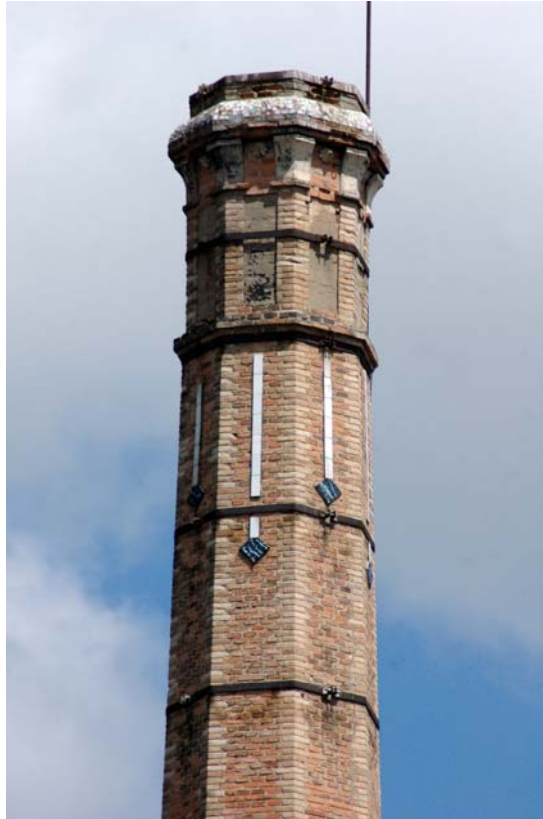
Figura 5.342: Corona con decoración de cerámica vidriada en chimenea de Fábrica de loza, Segovia
