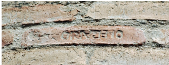
Figura 5.11: Ladrillo mecánico macizo prensado con inscripción A. López de la chimenea de la Azucarera, Zaragoza
