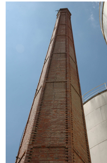
Figura 4.64: Chimenea fuste de sección cuadrada con variación de sección en prismas, Banyeres de Mariola. Autor: Julia Ramos
