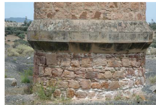
Figura 5.312: Base cuadrada de sillera de piedra en chimenea de fábrica de tintes Sant Jordi, Alcoy (Alicante)
