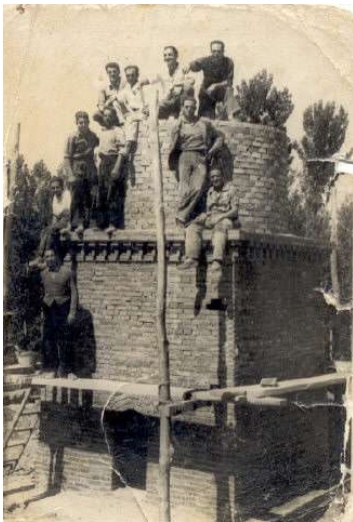
Figura 6.245: Construcción de chimenea de Unión Española de Explosivos, Ugés (La Coruña). (Cascales, 2001)
