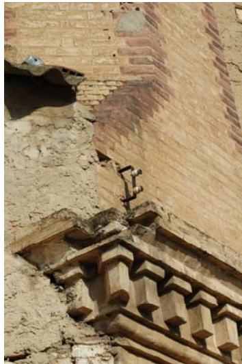
Figura 5.157: Cornisa dentellado pareado en T en chimenea motor riego Santa Ana, Albal (Valencia)
