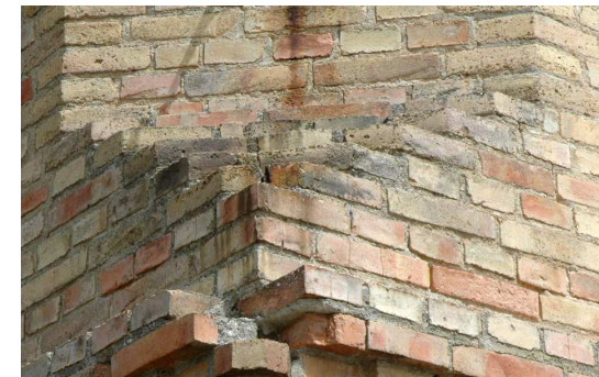
Figura 7.23: Vista interior de chimenea con el escalonado y los mechinales para andamiaje en Casa Boix, Burjassot (Valencia)
