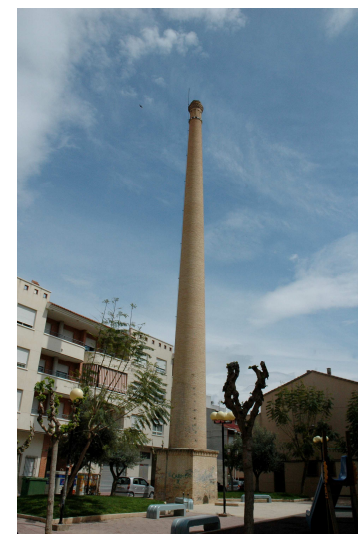
Figura 4.163: Chimenea llamada de la Loma perteneciente a la fundición Iberia dedicada al tratamiento de los minerales de plomo y plata. Se construyó en 1843 y años más tarde sería adquirida por la compañía inglesa Edward Bates, Águilas (Murcia). Autor: Lilia Zaragoza
