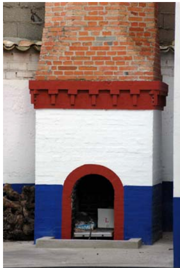
Figura 6.181: Base de chimenea con ornamentación rombale en distintos colores de alcoholera Antonio Fábregas Mompeó, Tomelloso (C. Real)
