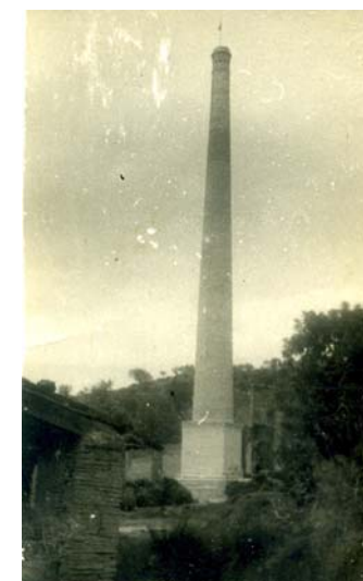
Figura 6.269: Construcción de chimenea de fábrica de ladrillos Pastor, Ràfol de Salem (Valencia). Archivo J. Miñana
