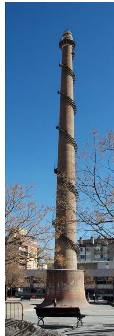
Figura 6.296: Chimenea de fábrica cerámica Bòbila de l'Almirall, Terrassa (Barcelona)
