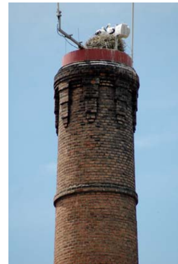
Figura 5.299: Detalle de dentellado modillón en cornisa de corona y rehundido de borde liso en chimenea del taller de cartuchería de fusil de la Real Fábrica de Armas, Toledo
