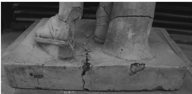
Figura 4. Grietas superficiales y profundas
