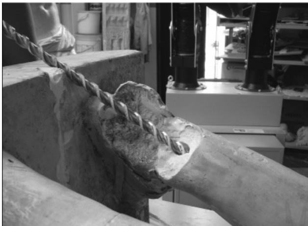
Figura 9. Perforación para posterior refuerzo estructural
