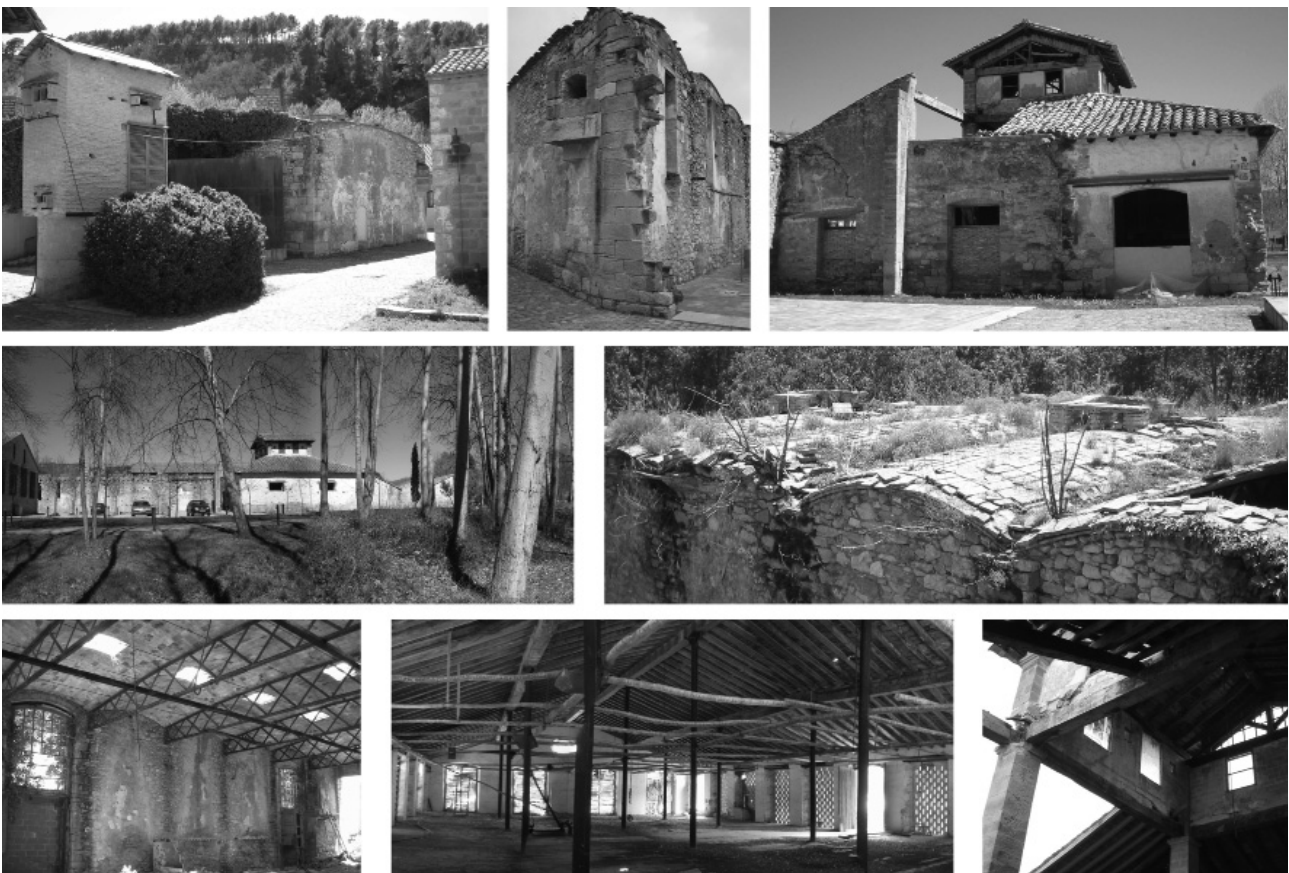
Figura 5. Imágenes del estado actual de las naves de la Fábrica Giner
