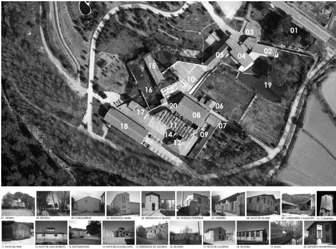
Figura 6. Fotografía aérea del estado actual de la Fábrica Giner. Numeración de las naves (conforme a los usos originales)
