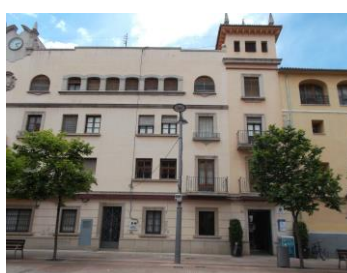
Imagen 10 Antiguo Convento de Sant Roc (s. XVI) – Actual Biblioteca Central. Fuente: propia.
