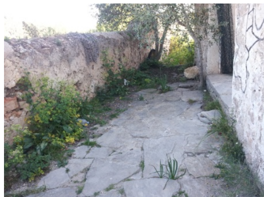
Pavimento de la zona de acceso
