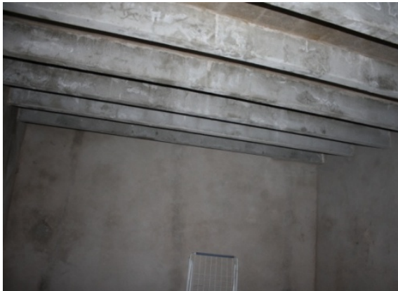
Fotografías del forjado de la habitación nueva 1
