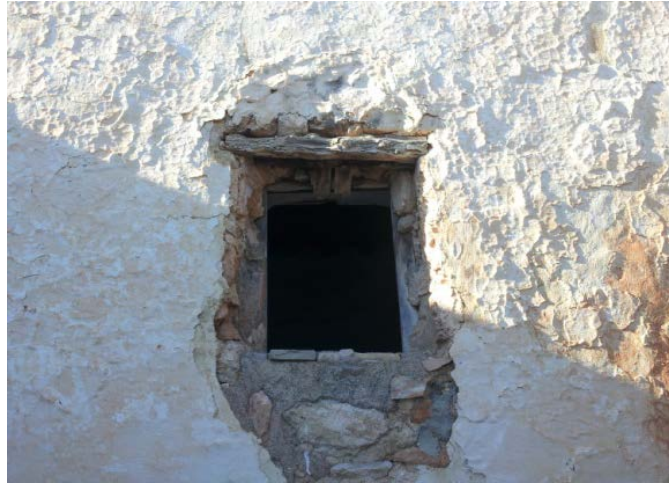
Fotografía de la ventana del porxo
