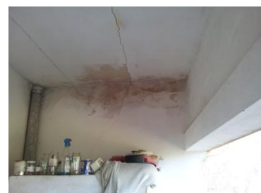
Humedad por filtración en las esquinas del techo de la zona exterior cubierta (zona de cisterna)
