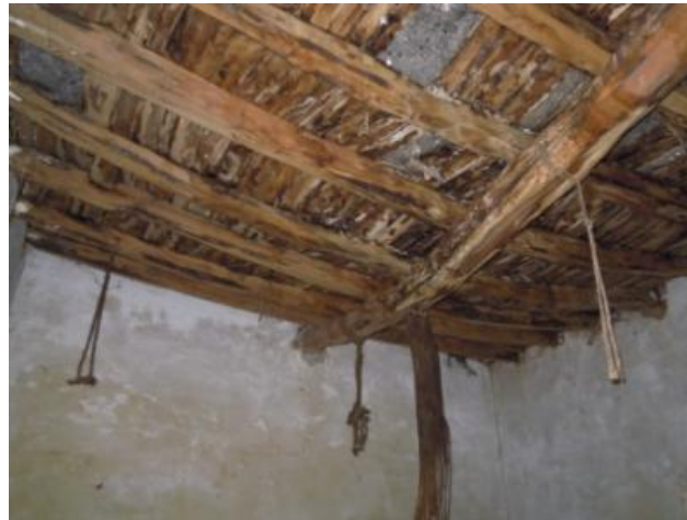
Apuntalamiento de la jácena de una de las estancias
