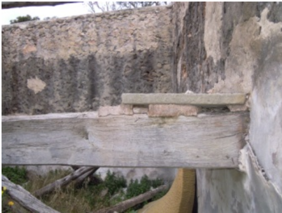
Fotografía de la viga de la cocina a media altura
