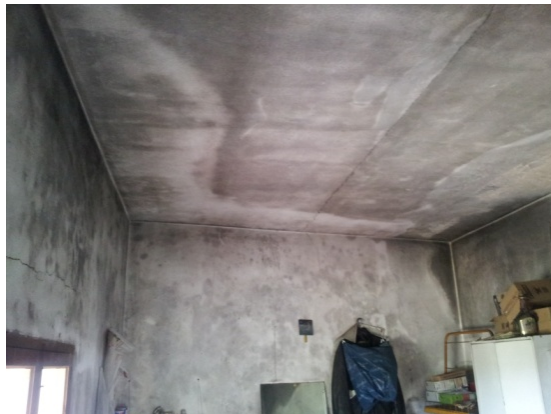
Fotografías del techo de la habitación exterior
