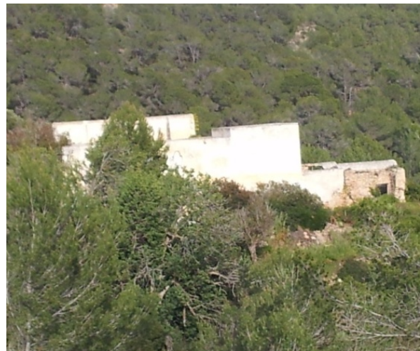
Terreno posterior de la vivienda
