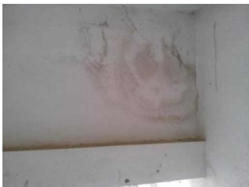
Humedad por filtración en las esquinas del techo de la zona exterior cubierta (zona de cisterna)
