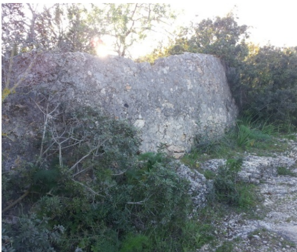
Muro perimetral de la casa
