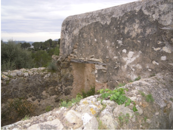
Fotografía de dintel de una puerta en muro de corral
