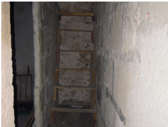
Escalera de acceso a estancia superior
