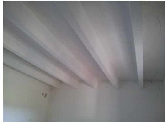
Fotografías del forjado de la habitación nueva 2
