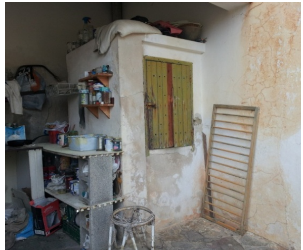
Cisterna adosada a la casa
