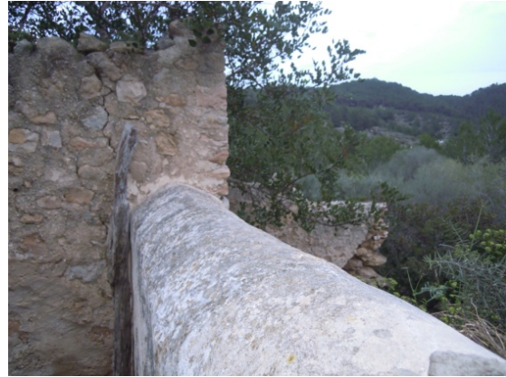
Fotografía de un muro con cumbra
