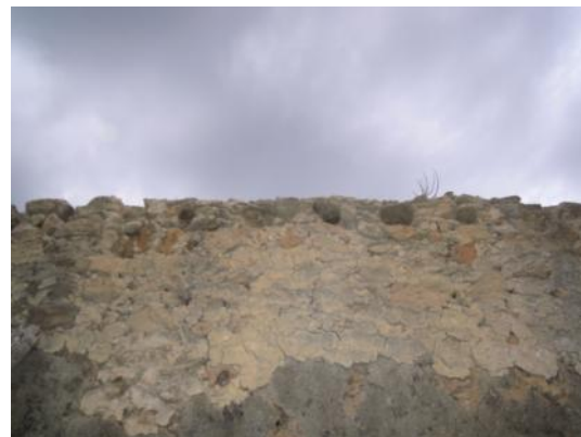
Huecos de los apoyos de las vigas de la cubierta
