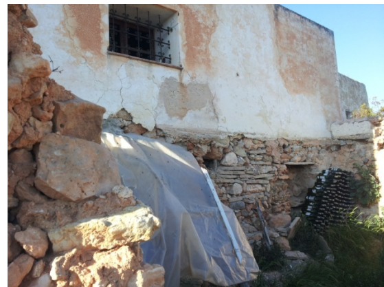
Fotografía de muro orientado al sur de habitación exterior
