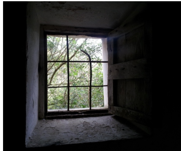
Ventana original de la casa
