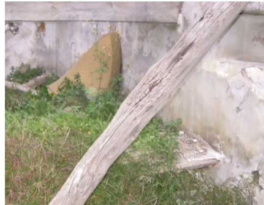
Fotografía del escalón de la chimenea
