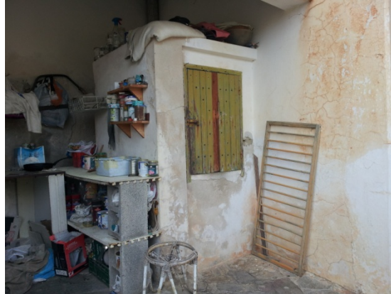
Cisterna adosada a la fachada principal de la casa
