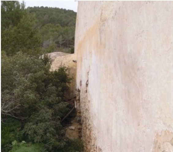
Fotografa exterior del horno 1
