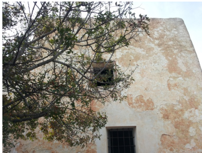
Fotografía de muro revestido de cal
