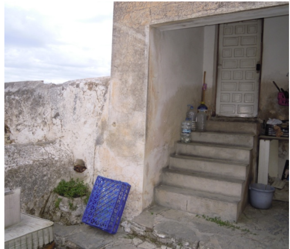
12. Escalera de acceso a habitación exterior
