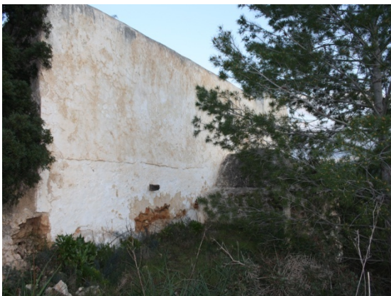
Fotografía de muro fachada oeste
