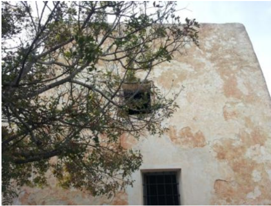
Fotografías de la fachada sur afectada por arenización
