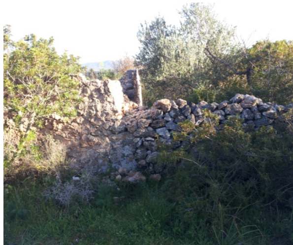
Muro perimetral de la casa
