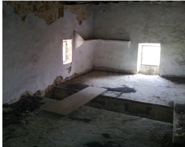
Fotografía desde la planta superior del hueco de escalera
