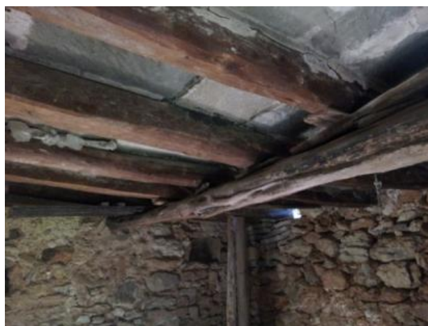
Techo del corral situado debajo de la habitación exterior
