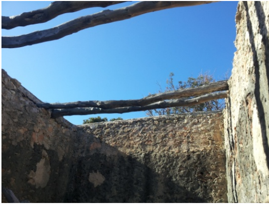
Fotografía de las únicas vigas de la cubierta de la cocina
