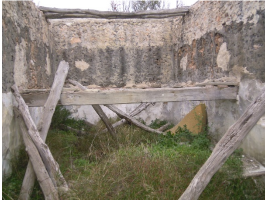
Fotografías de los muros de la cocina ennegrecidos por el humo de la chimenea original
