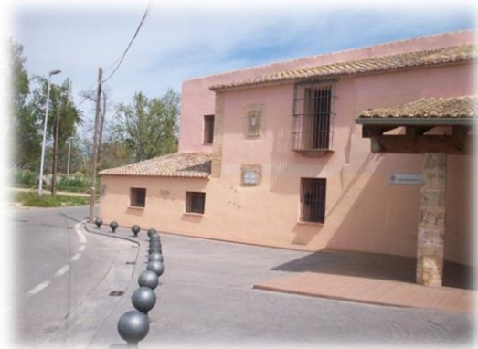
Fig.39.-Molí de Vera en su estado actual,2013.
