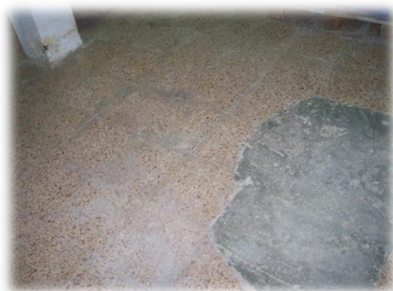
Fig.101.-Suelo del molino en su estado actual, 2013.
