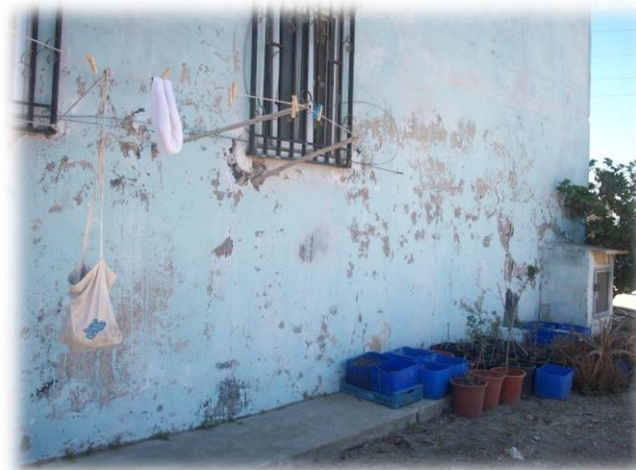
Fig.113.-Cerramiento exterior que da a levante
