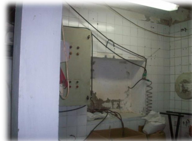
Fig.88.-Ventana tapada que servía de ventilación natural en sala de trabajo.
