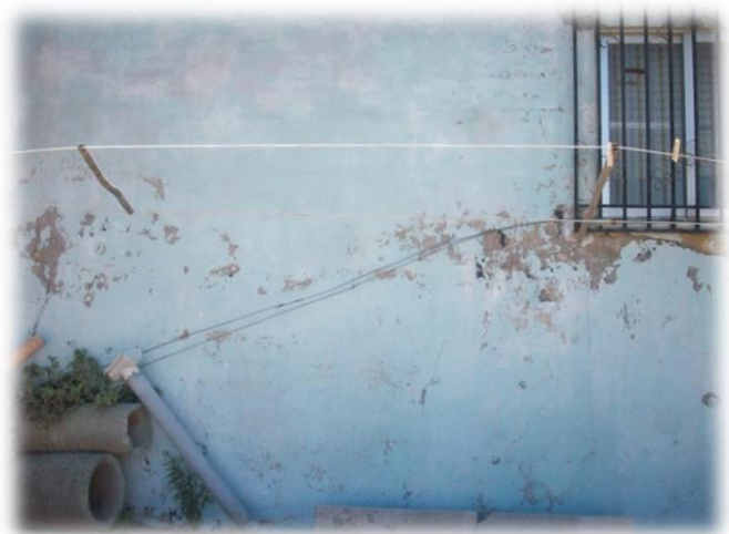
Fig.111.-Cerramiento exterior que da a levante
