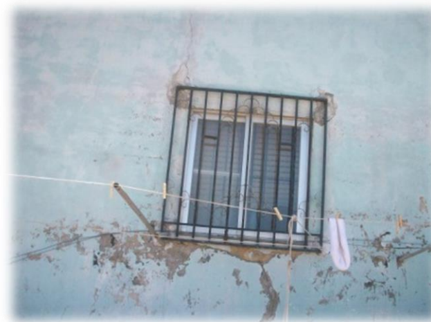
Fig.112.-Cerramiento exterior que da a levante
