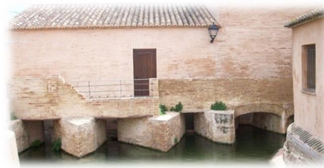
Fig.40.-Molí de Vera en su estado actual,2013
