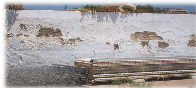
Fig.116.-Muro exterior que delimita el patio.
