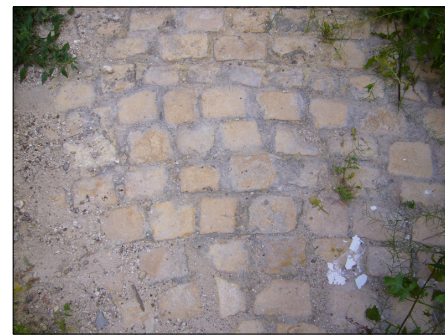
Adoquín de piedra amarillo Tamaño pieza 13x7x5 Juntas 1-2 cm
