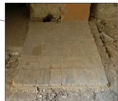
Ladrillo Cerámico macizo Tamaño pieza 28x13,5x3 Juntas de 1,5 cm
