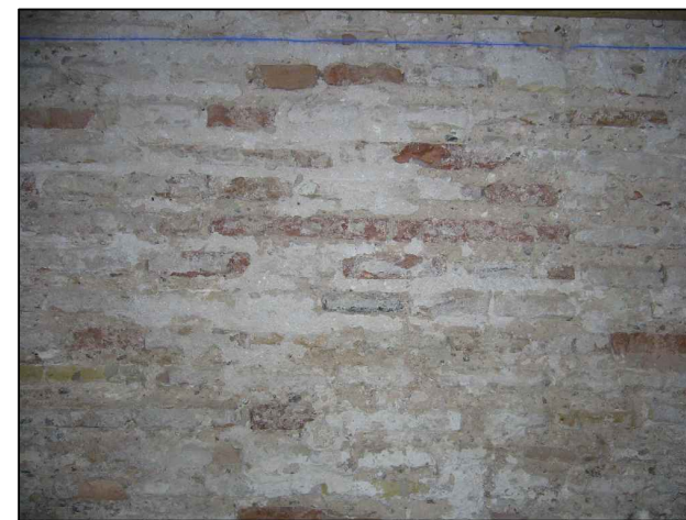
MURO DE CARGA Tamaño pieza cerámica 31x13x4 Llagas 0.5-1 cm Tendeles 3 cm
