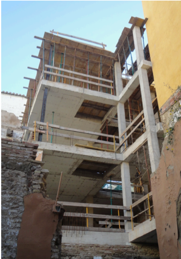
Estructura nueva sobre el palacio
