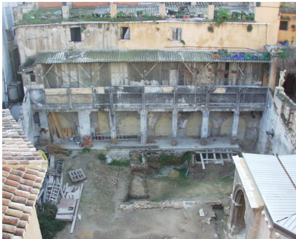
Construcción sobre los arcosolios antes de la demolición.
