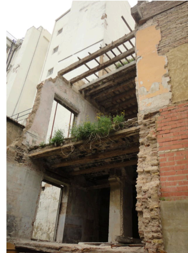
Forjados que fueron apoyados en los arcosolios
