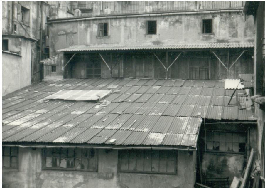
Cobertizos de la antigua imprenta de los Domenech encerrando los arcosolios dentro de ella.
