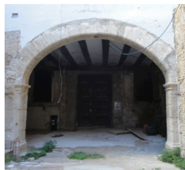
Arco carpanel de acceso al patio. Al fondo el portal de entrada
