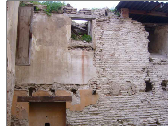
MURO DE CARGA Tamaño pieza cerámica 29x14x4 Llagas 1 cm Tendeles 1 cm
