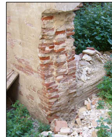
MURO DE CARGA Tamaño pieza cerámica 29x14x4 Llagas 1 cm Tendeles 1 cm
