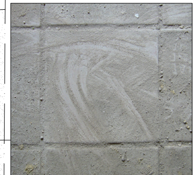
Baldosa de Cemento Tamaño pieza 29x29 Juntas de 1,5 cm
