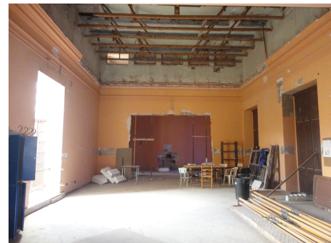
Salón noble principal con el falso techo demolido
