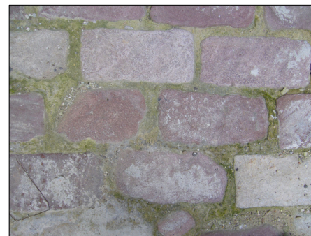
Adoquines de piedra rojizos y grises Tamaño pieza 31x16,5x7 Juntas de 1-3 cm
