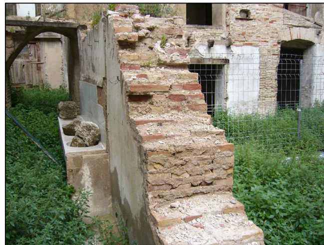
MURO DE CARGA Tamaño pieza cerámica 29x15x4.5 Llagas 1 cm Tendeles 2 cm
