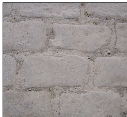
Adoquín de piedra gris Tamaño pieza 32x15x11 Juntas de 2,5 cm
