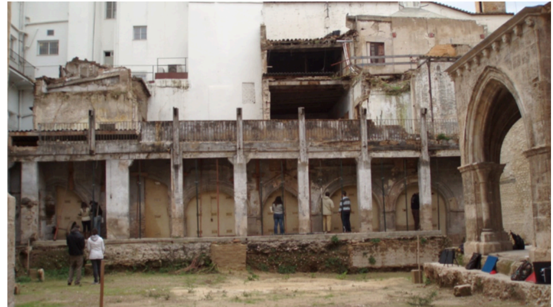
Los arcosolios con la construcción superior ya derruida. En el fondo se puede apreciar el Palacio de los Valeriola en estado ruinoso.
