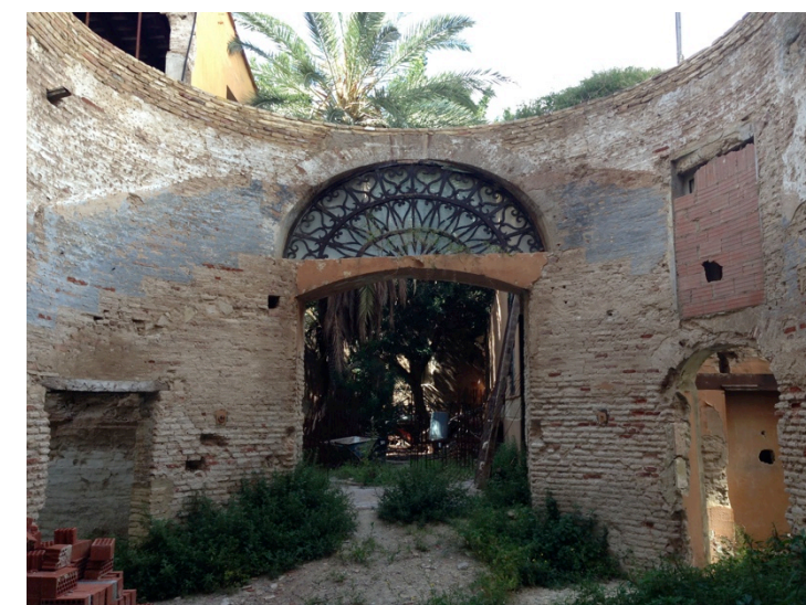
Acceso al jardín. Se pueden observar unas marcas en azul de la antigua escalera imperial
