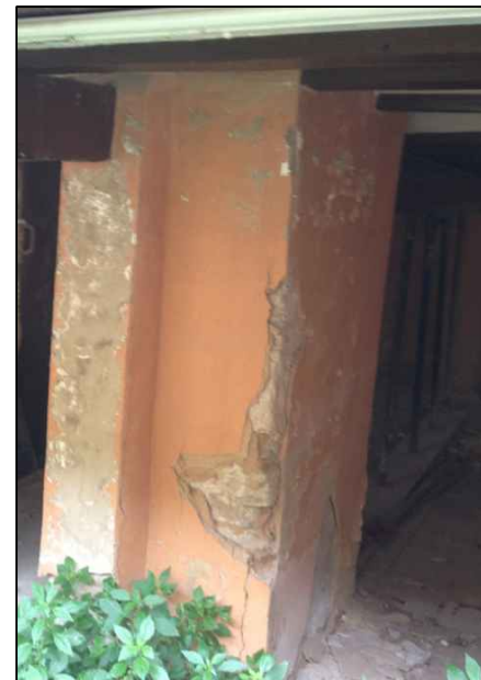
PILAR Tamaño pieza cerámica 30x13x4 Llagas 1.5 cm Tendeles 1.5 cm
