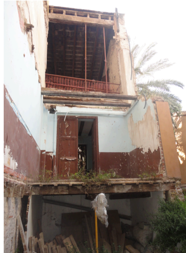
Parte anexa a la intemperie
