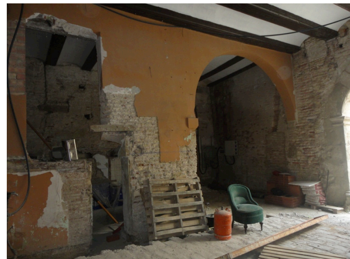
Parte izquierda de la zona de entrada. Antigua habitación del portero, ahora demolida
