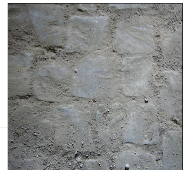
Adoquín de piedra gris Tamaño pieza 13x9x7 Juntas de 1,5 cm
