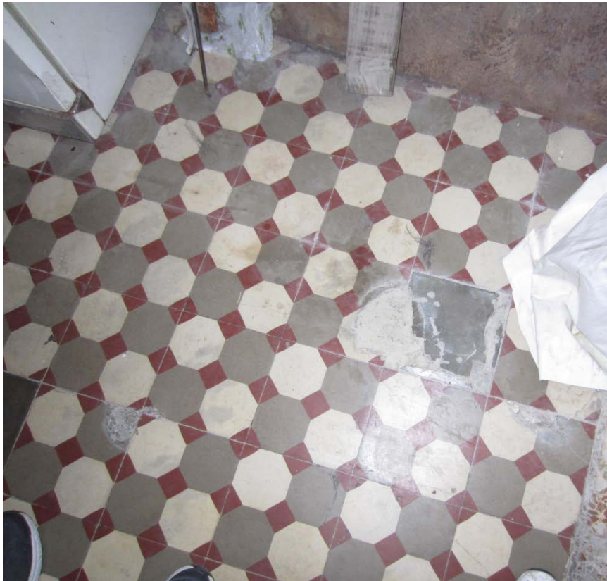
Pavimento de cocina.
