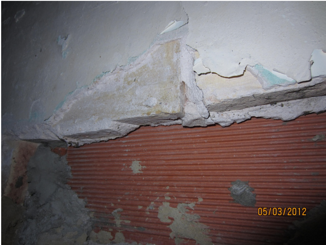
Ladrillo con capa de yeso y pintura
