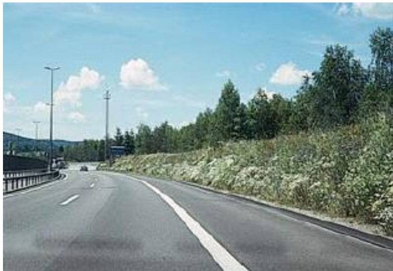
Fig.2. Pantalla Acústica de tierra [8]
