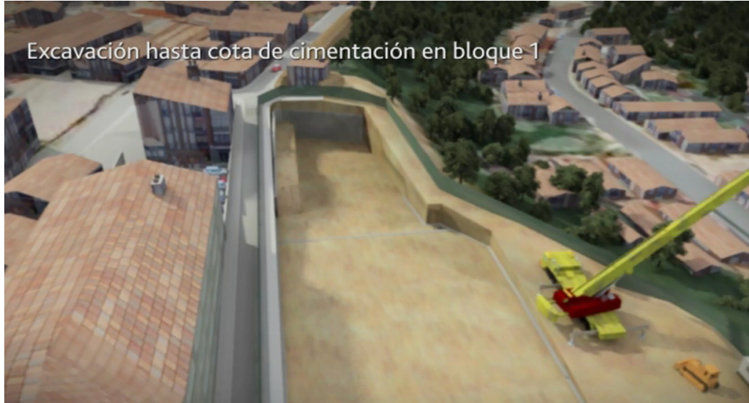
(P85: Excavación part 3, till final depth in block 1)
