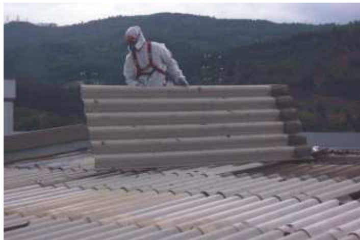
Retirada controlada de la cubierta de fibrocemento 42
