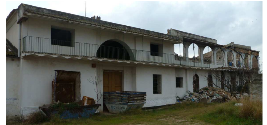
Fachada principal de las naves anexas delanteras y la vivienda del propietario (Noroeste)
