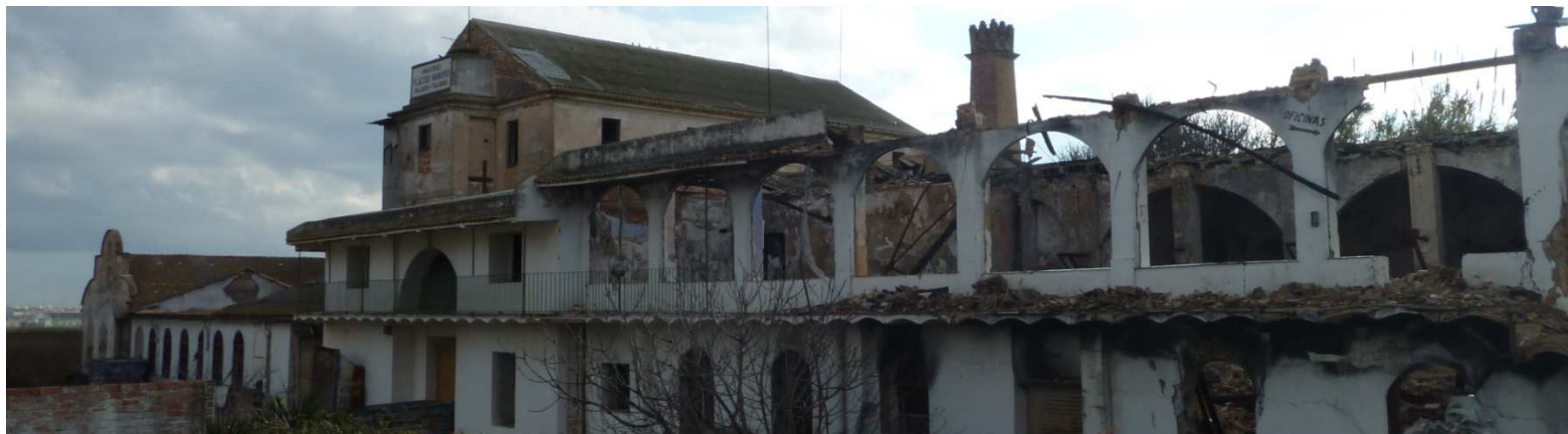
Fachada principal del conjunto de la nave principal, las naves anexas y la vivienda del propietario
