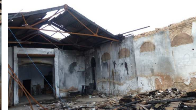
Zonas a retirar previo a la rehabilitación-nave central
