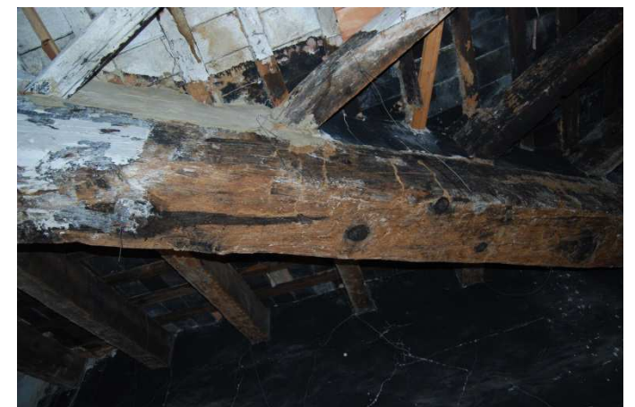
Fotografías de la disposición de la cubierta de la vivienda del propietario
