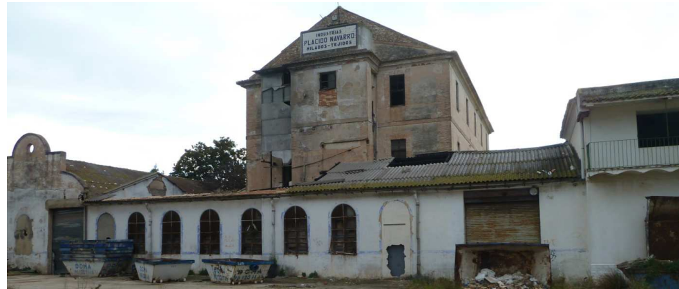
Fachada principal de las naves anexas delanteras (Noroeste)
