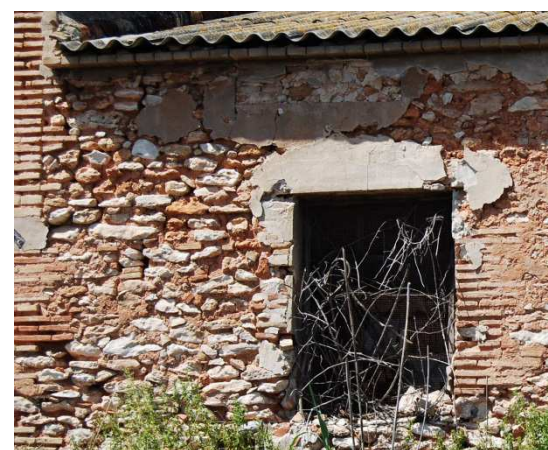
Capas de mortero para tapado de orificios
