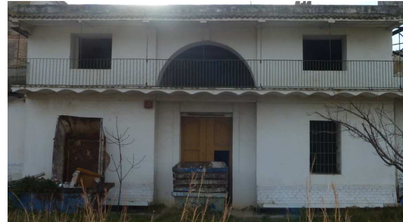
Fachada principal de la vivienda del propietario
