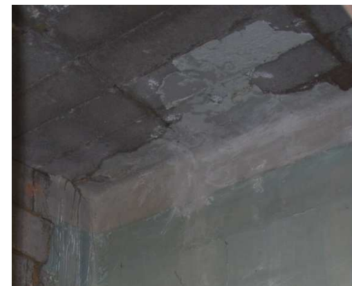
Fotografía del forjado/cubierta interior
