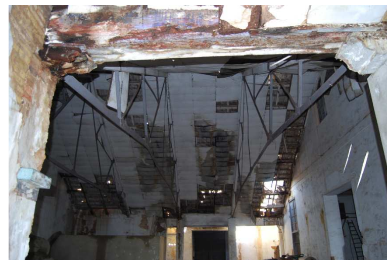
Interior del segundo bloque de naves anexas (cubierta)
