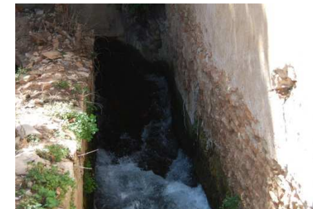
Fotografía detalle de cimentación 1.
