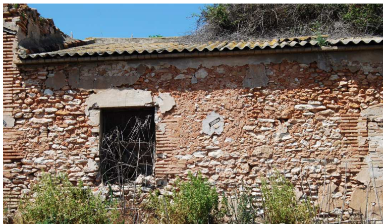
Fachada posterior del cuarto bloque de naves anexas
