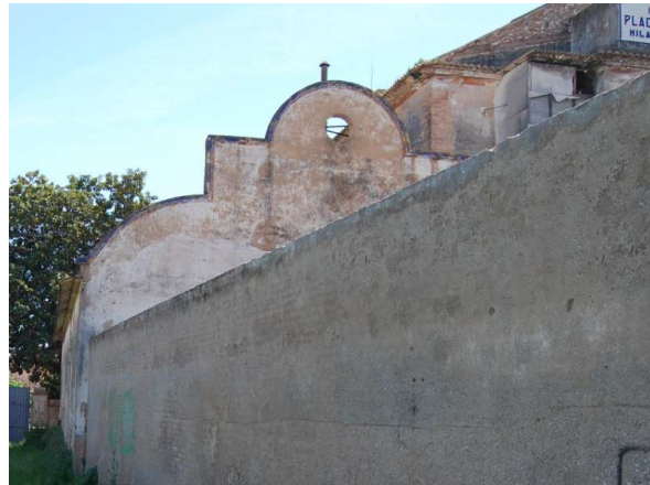
Fachada principal de la nave lateral derecha con el muro
