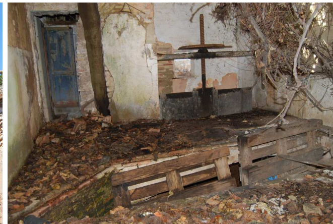
Zona de trampilla para el paso del agua de la Acequia
