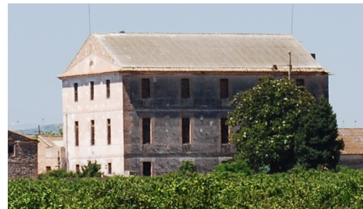
Fotografía de fachada lateral
