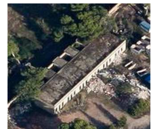
Fotografía del forjado/cubierta exterior
