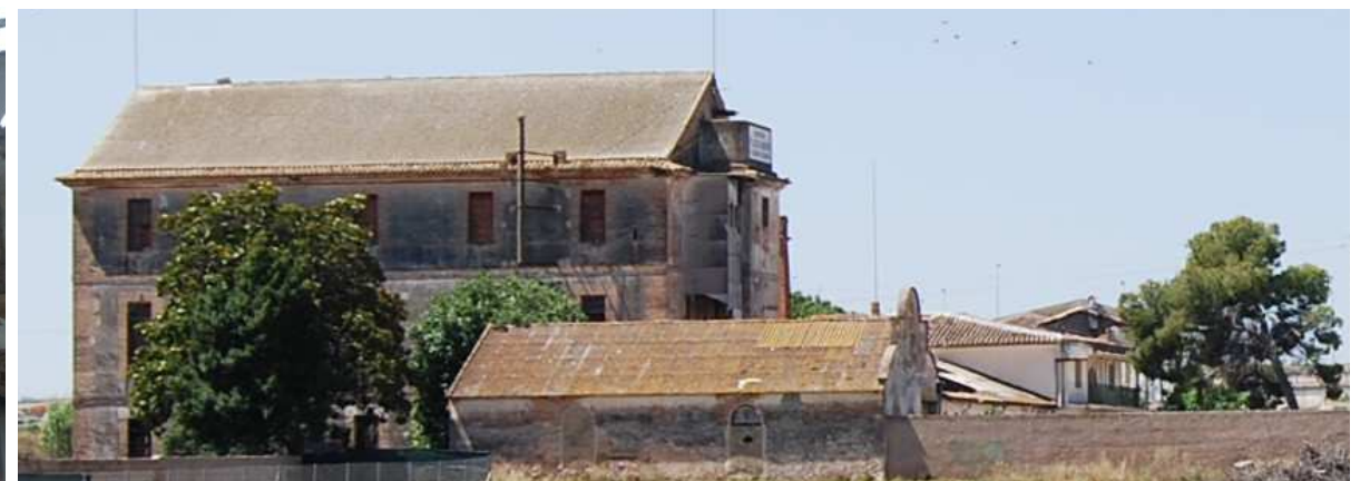
Fachada principal/lateral del conjunto de la nave principal, las naves anexas y la vivienda del propietario
