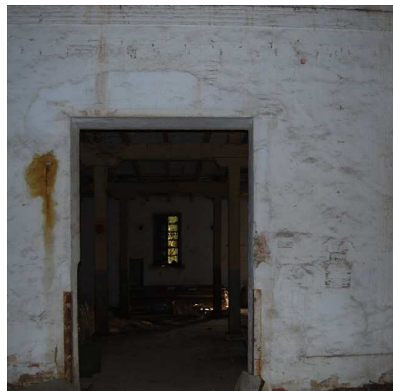
Fotografía muro interior 1.
