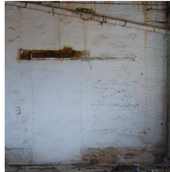
Fotografía muro interior 2.
