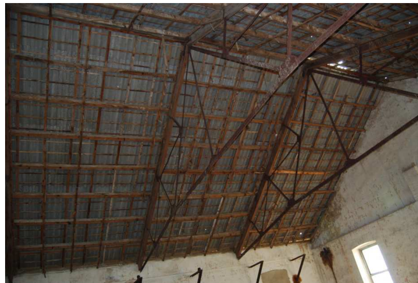
Cubierta de cerchas metálicas y de madera
