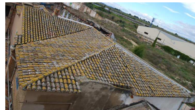
Fotografías de los faldones con teja curva y resolución de correas, enlistonado y entablado de madera.
