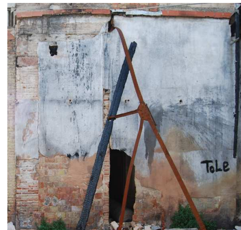
Tapiado de acceso original de la nave ppal.
