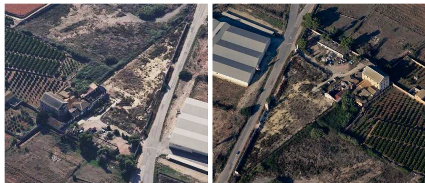
Vista aérea Sur
