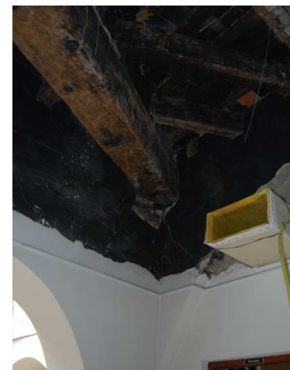
Cubierta y muro portante de la vivienda
