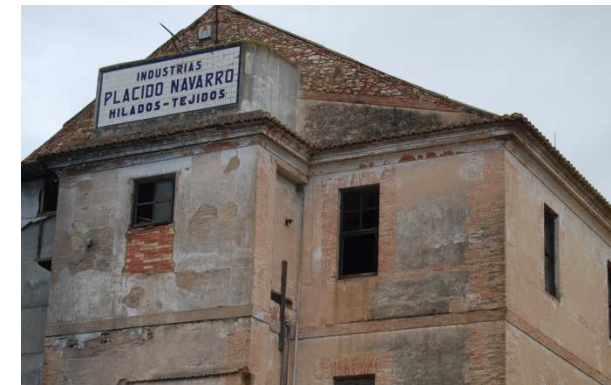
Fotografía de fachada principal
