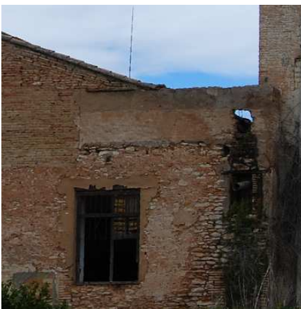
Enlucidos de mortero
