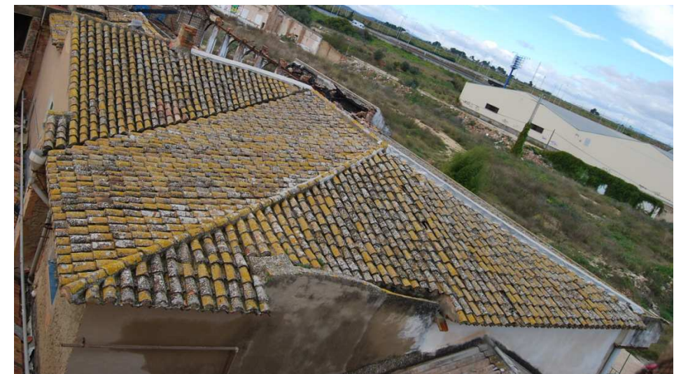
Disposición de faldones de la cubierta
