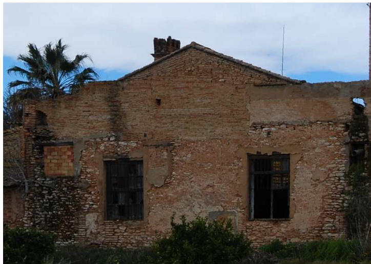
Fachada posterior del segundo bloque de naves anexas
