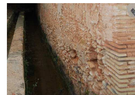
Fotografía detalle de cimentación 1.
