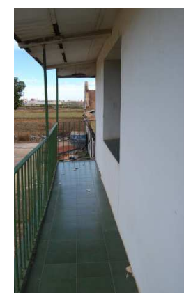
Fotografía de los paramentos exteriores
