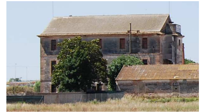
Fotografía de fachada lateral
