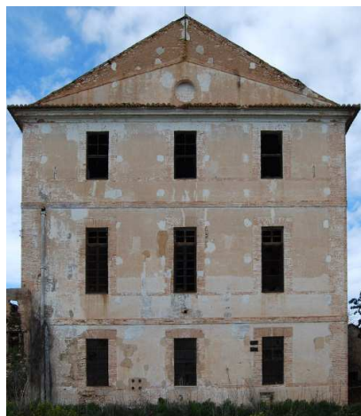
Capas de mortero en toda la fachada
