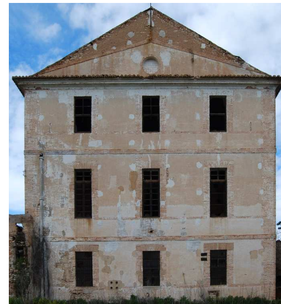
Fotografía detalle de muros
