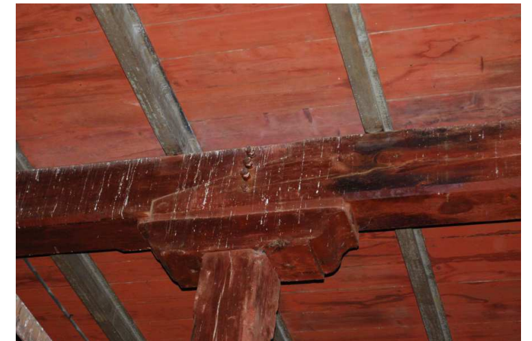
Encuentro viga y pilar en planta segunda
