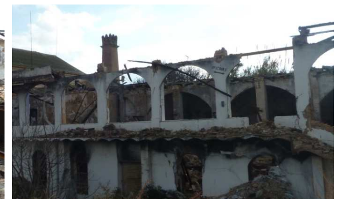
Zonas a retirar previo a la rehabilitación-ala izquierda del conjunto
