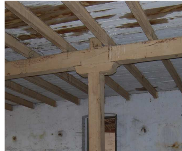
Encuentro viga y pilar en planta baja
