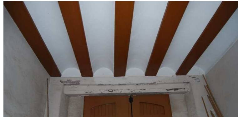
Fotografía del forjado de la vivienda
