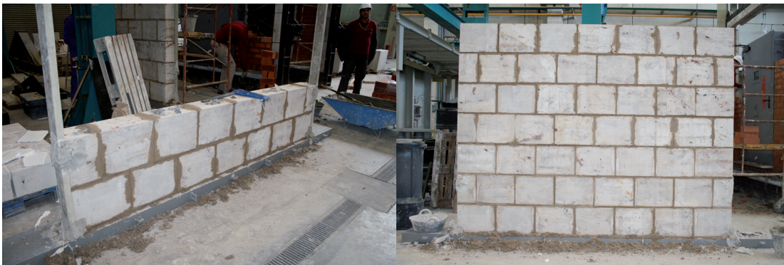
Imágenes 3.56 y 3.57 Construcción del muro de sillería.
