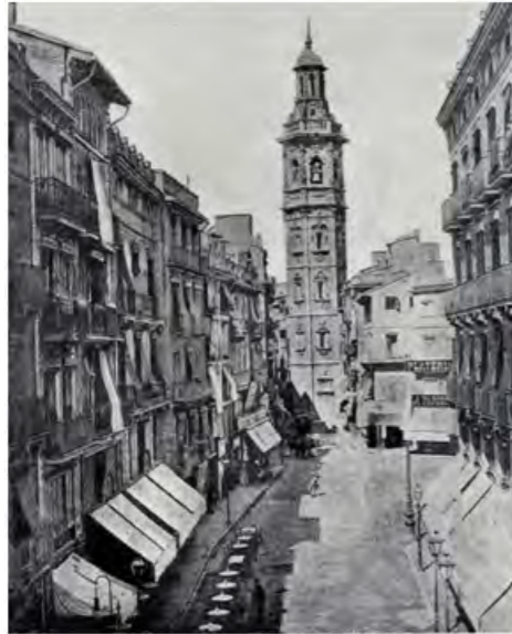
Fotografía de 1885, captada desde la calle, donde se observa el "forn de la ceca", edificio que fue demolido para la construcción de los almacenes "La isla de Cuba". La construcción de la calle de la Paz todavía no ha finalizado
