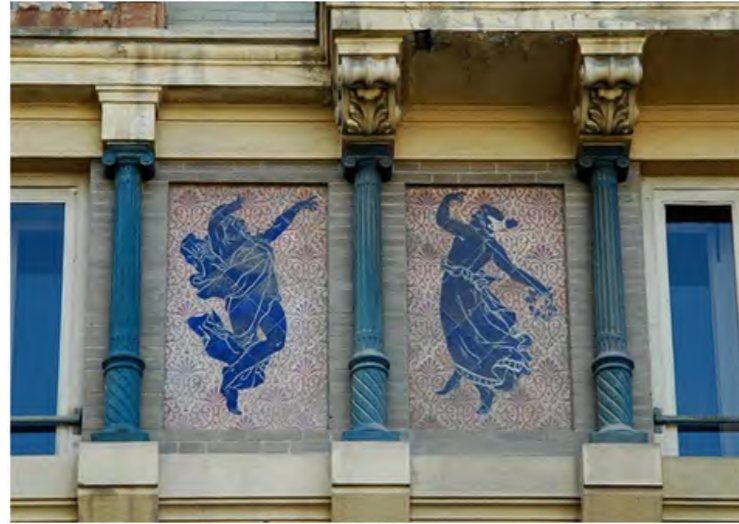
DETALLE DECORACIÓN CERÁMICA DE FACHADA.
