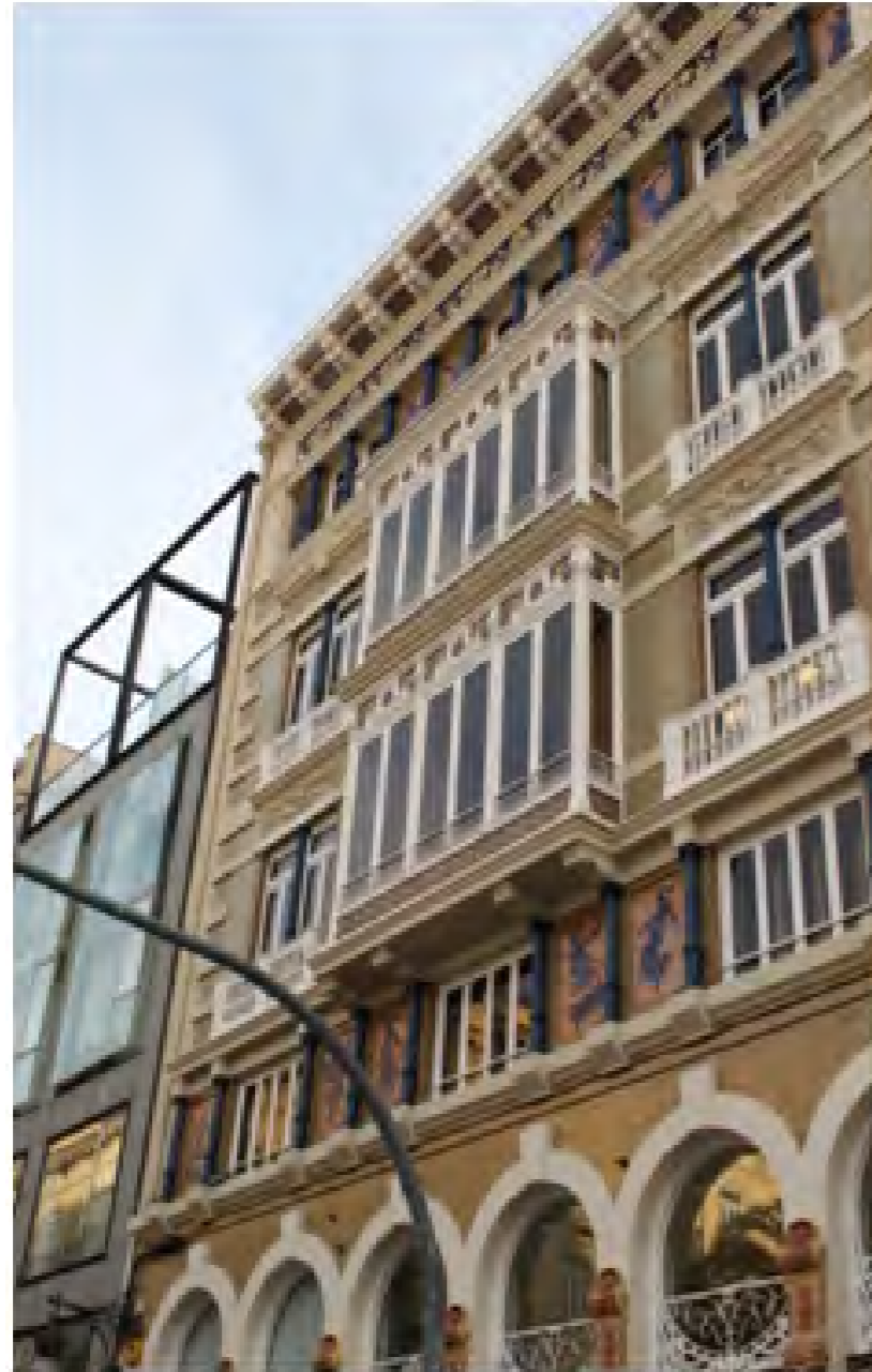
FACHADA PRINCIPAL (CALLE DE LA PAZ)
