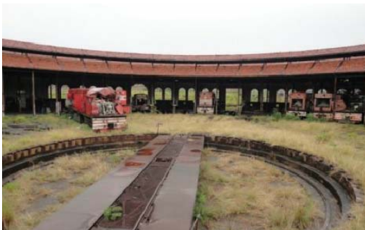
13 Rotonda (para mantenimiento de vagones). Actualidad en abandono
