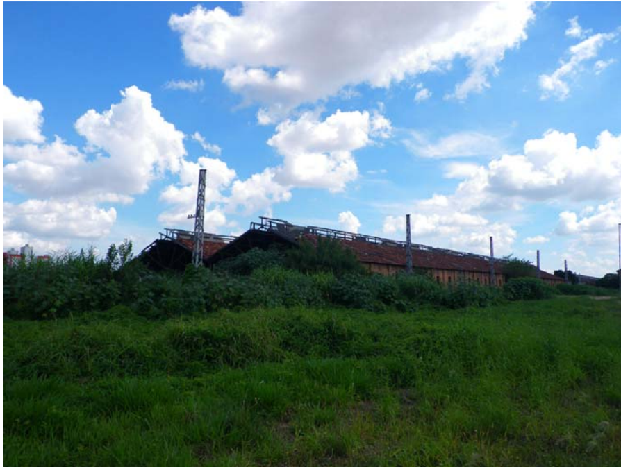
31 Imagen actual de los viejos almacenes de mantenimiento de trenes, 2011
