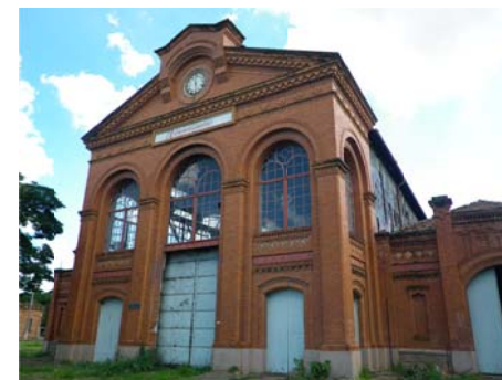
37 Fachada principal del almacén de montaje de vagones
