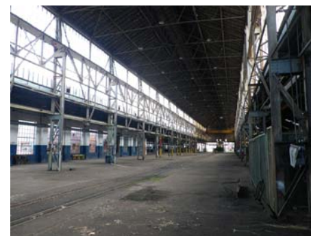
38 Imagen interior del almacén de montaje de vagones
