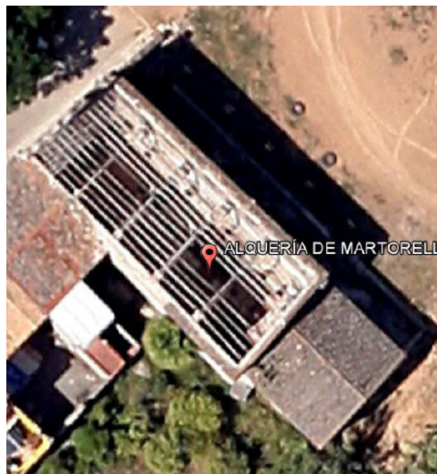
Situación: Ermita de la Alquería de Martorell
