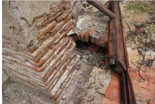
Arco de ladrillo (cubrición del pozo)
