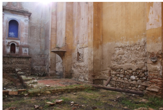
Muros enterrado pertenecientes al ingenio de azúcar
