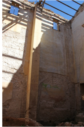
Cegado de los tres arcos
