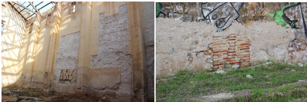
Arcos del ingenio embebidos en el muro
