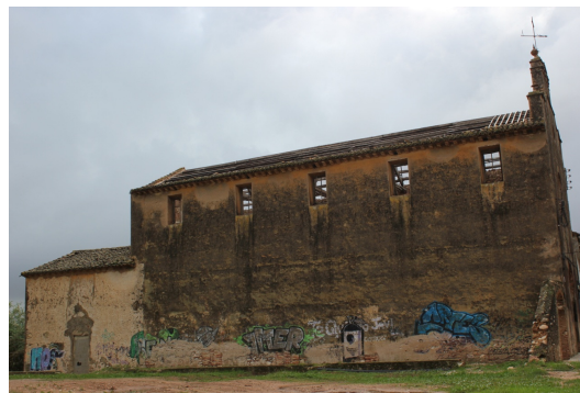
Perfil del edificio (dos cuerpos diferenciados)
