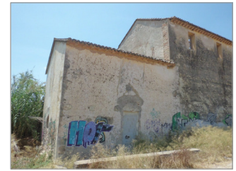
Puerta cegada de bloques
