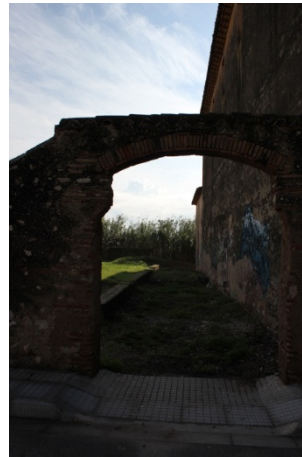
Arco anexo a la fachada
