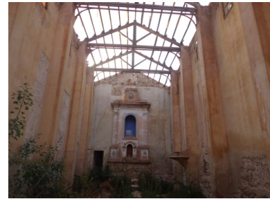
Interior del edificio (5 crujeas)
