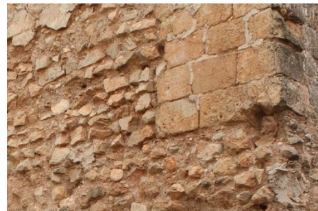
Detalle de mampostería ordinaria con mampostería concertada en esquina y restos de revestimiento superficial.
