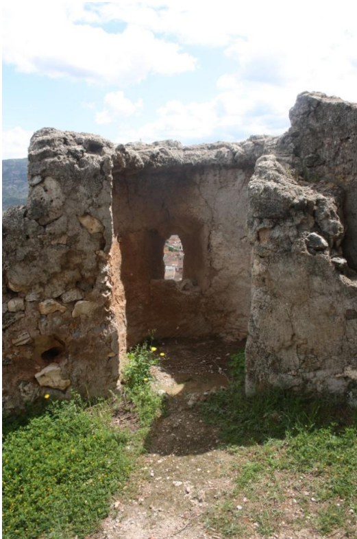
27.Foto detalle de la torre esquinera de la muralla
