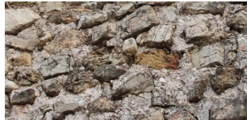
Detalle de labra de los mampuestos
