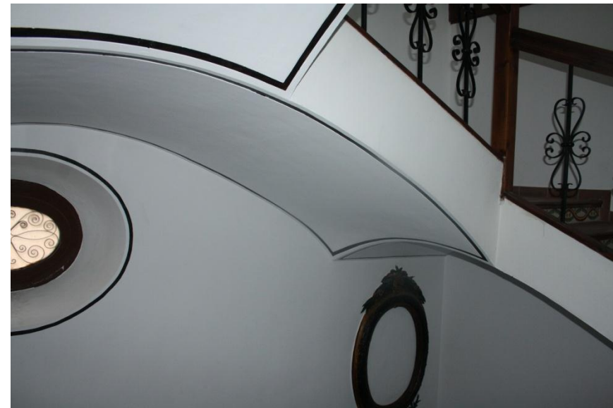
Foto de escalera de planta cuadrada, bóveda tabicada, escalera del convento de San Francisco (casa de la cultura de Ayora)
