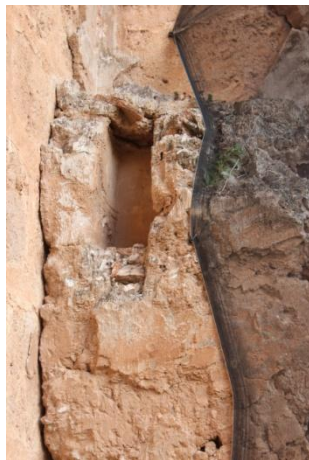
16. Foto de detalle del hueco de las vigas del forjado
