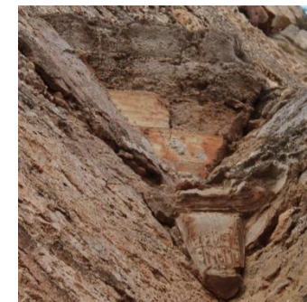
20.Foto detalle de arranque de bóveda sobre arco
