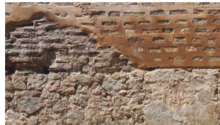
Detalle del muro interior de cerramiento parte original y parte rehabilitada
