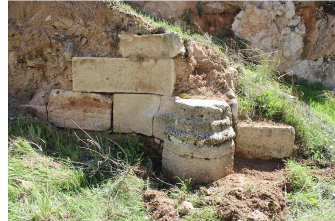
17.Detalle del arranque de la escalera, estilo gótico
