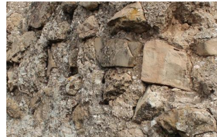
Detalle de muro tosco de mampuesto ordinario y mortero de cal.
