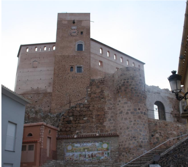
34. Foto del acceso al castill
