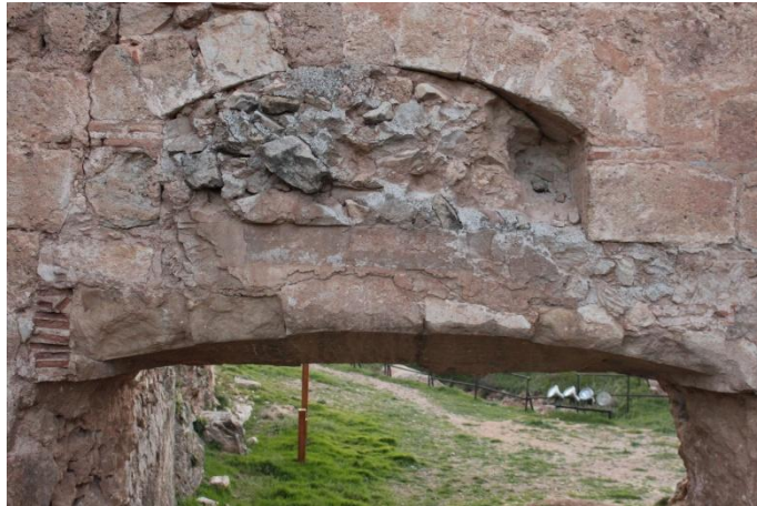
13. Foto de detalle de puerta de acceso, arco cegado
