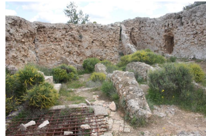
30.Foto del interior de la torre, restos de las dependencias
