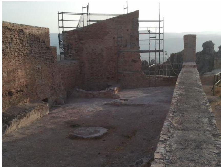
4. Foto del interior de la cocina
