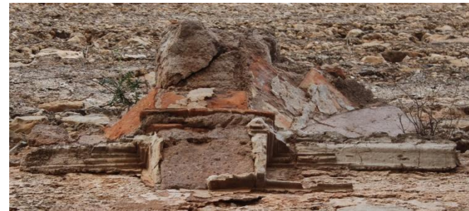
20.Foto detalle de arranque de bóveda sobre arco
