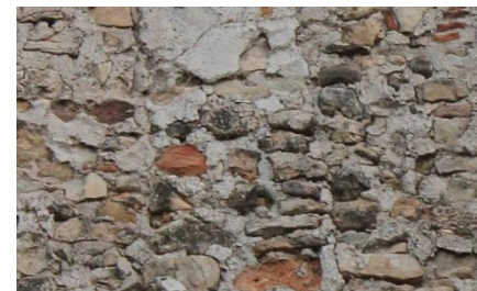
Detalle de labra y enlucido de los mampuestos.
