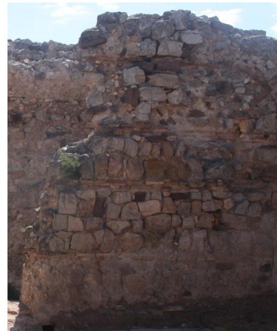
Foto detalle de la tabiquería, mampuestos con hileras de ladrillos cerámicos regularizando los tramos del tabique (torre del homenaje)
