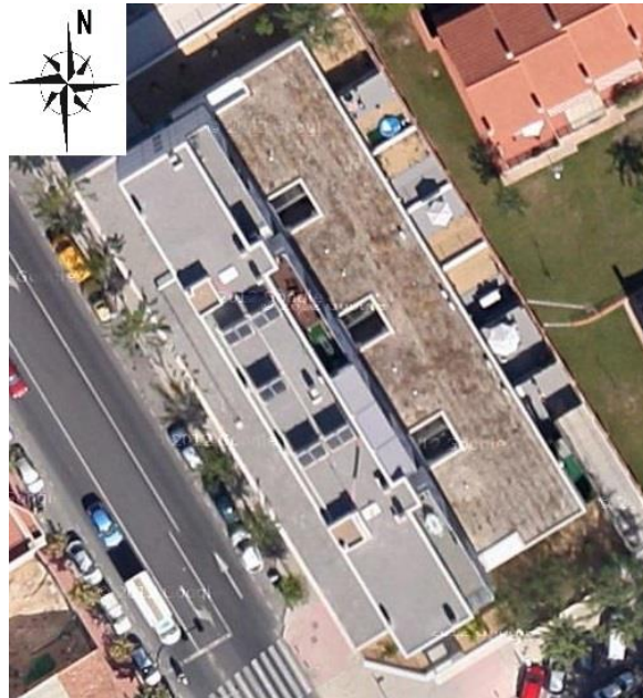
Figura 9. Vista aérea del edificio
