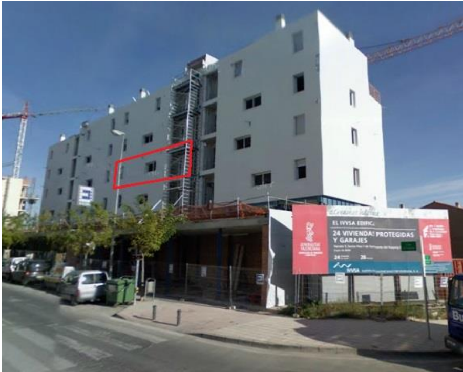
Figura 12. Edificio en construcción
