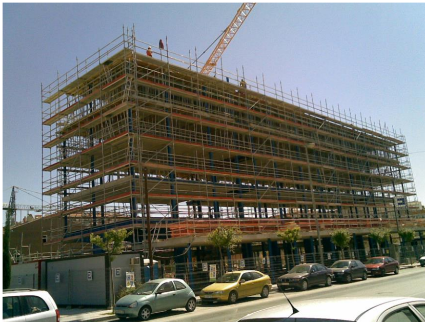
Figura 10. Construcción del edificio
