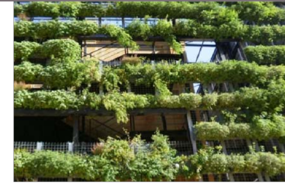
Sistema mixto trespadoras y gaviones
