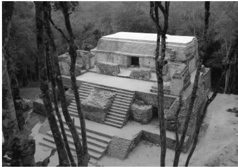
Fig. 24. Edificio N, Nakum, fotografía de 1910 Tozzer, y 2000 Noriega
