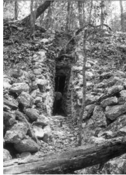
Fig. 21. Daños en edificios causados por saqueo
