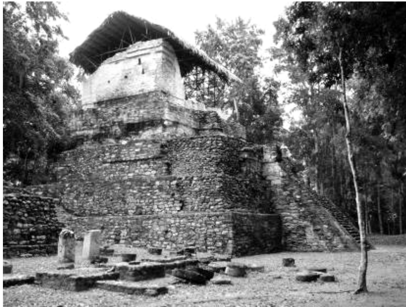
Fig. 26. Edificio C de Topoxté, fotografía Noriega
